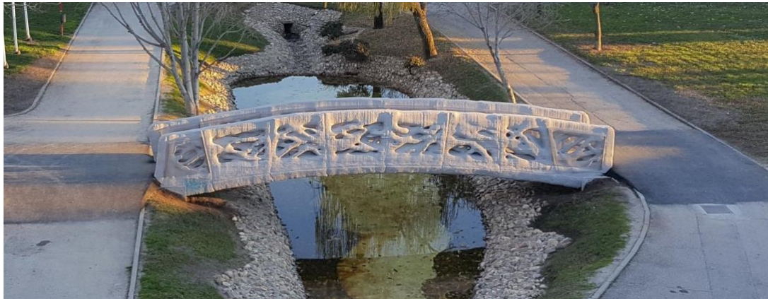
Figura 1.8. Puente impreso por IAAC mediante la tecnología D-Shape (Alcobendas) [16].
