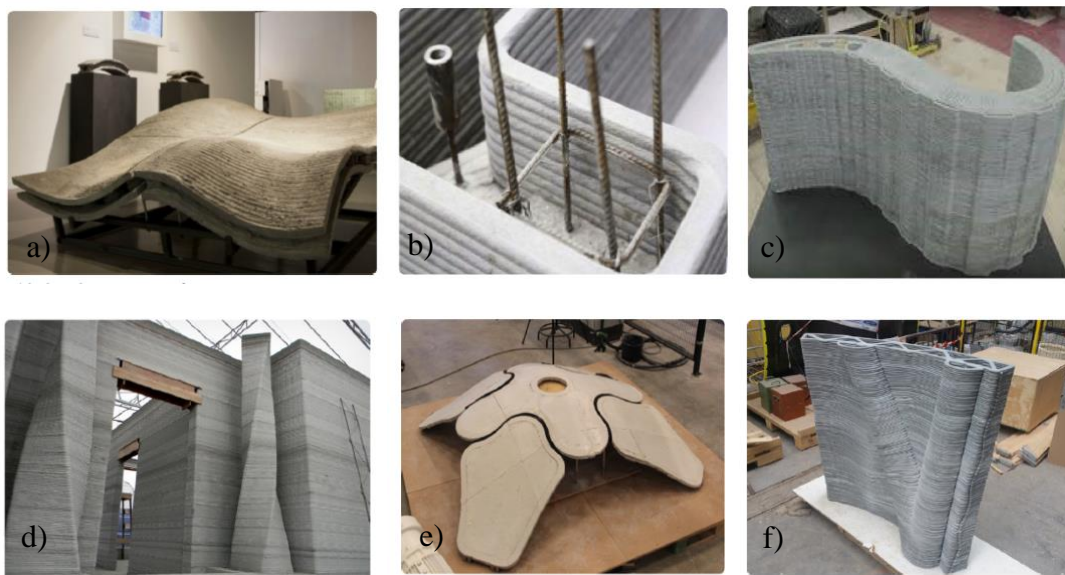
Figura 1.15. a) Fabricación de componentes horizontales (Universidad de Loughborough, Reino Unido), b) Elemento estructural. Fuente: https://3dprint.com/38144/3d-printed-apartment-building/ , c) Componente impreso verticalmente (Universidad de Loughborough, Reino Unido), d) paredes y columnas impresas verticalmente in situ (EE.UU.), e) panel, impreso horizontalmente en forma de cáscara (TU Delft y TU Eindhoven, Países Bajos), f) componente de panel impreso verticalmente (XTreeE, Francia) [4,37].
