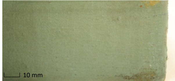
Figura 89. Borde inferior, zona derecha, muestra abrasiones y manchas de pintura.
