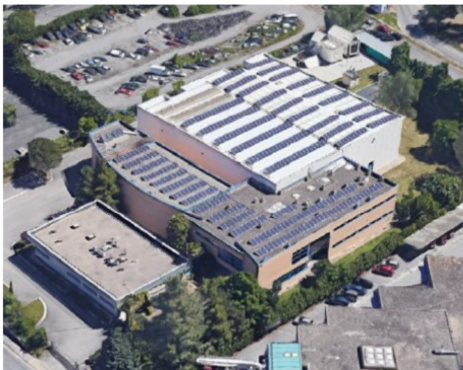
Figura 12. Vista aérea de la instalación fotovoltaica actual
