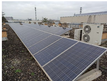
Figura 11. Paneles en el edificio principal
