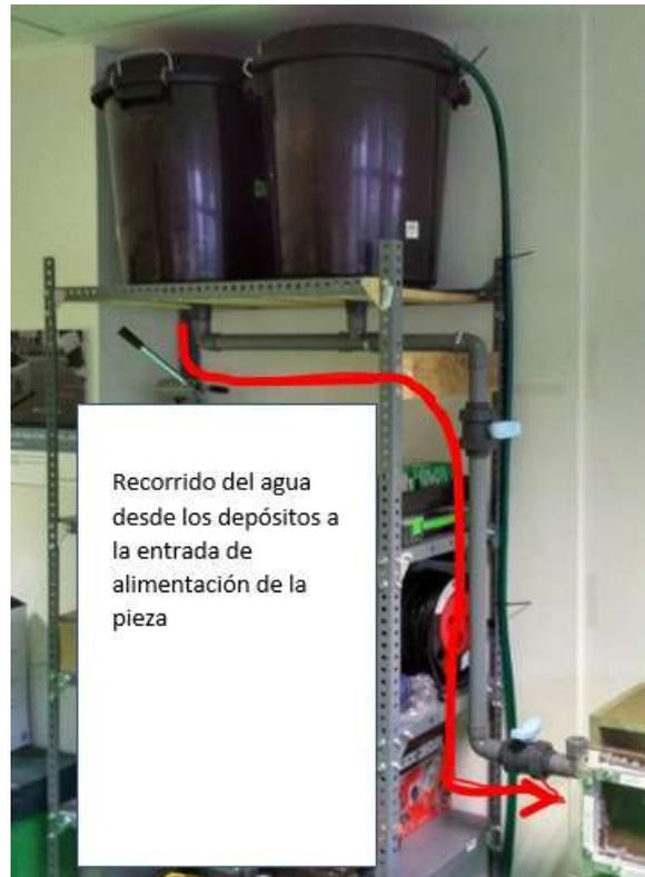
*Figura 3.26 Depósitos de agua*
