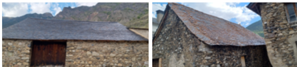
Figura 2. Imágenes de las cubiertas de pizarra de los tejados de varios edificios de la localidad de Espot. 2017. Fuente: Imagen del autor
