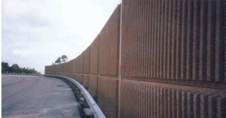
*Ilustración 31. Pantallas realizadas con módulos de hormigón. Tomada de [Estudio de la tipología de las pantallas acústicas. normativa y estado del arte]*
