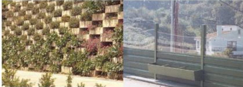
Ilustración 34. Pantallas tipo jardinera. Tomada de [Estudio de la tipología de las pantallas acústicas. normativa y estado del arte]
