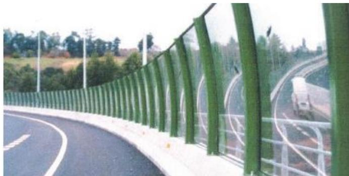
*Ilustración 30. Pantallas realizadas con módulos transparentes. Tomada de [Estudio de la tipología de las pantallas acústicas. normativa y estado del arte]*
