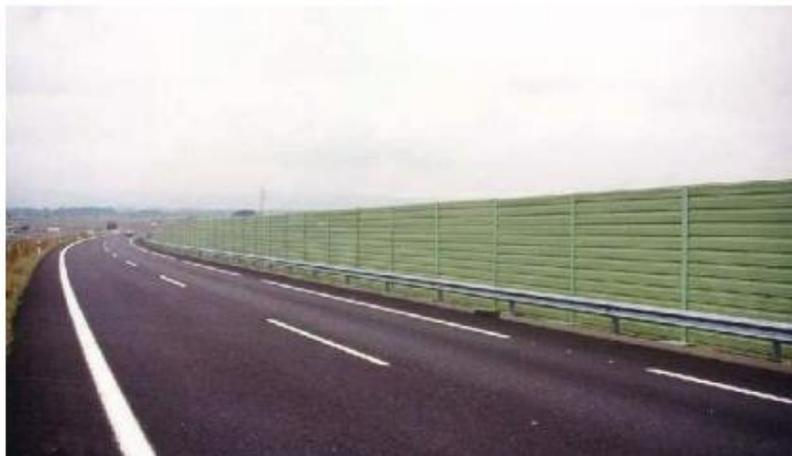
*Ilustración 32. Pantallas realizadas con módulos metálicos, tipo "sándwich". Tomada de [Estudio de la tipología de las pantallas acústicas. normativa y estado del arte]*
