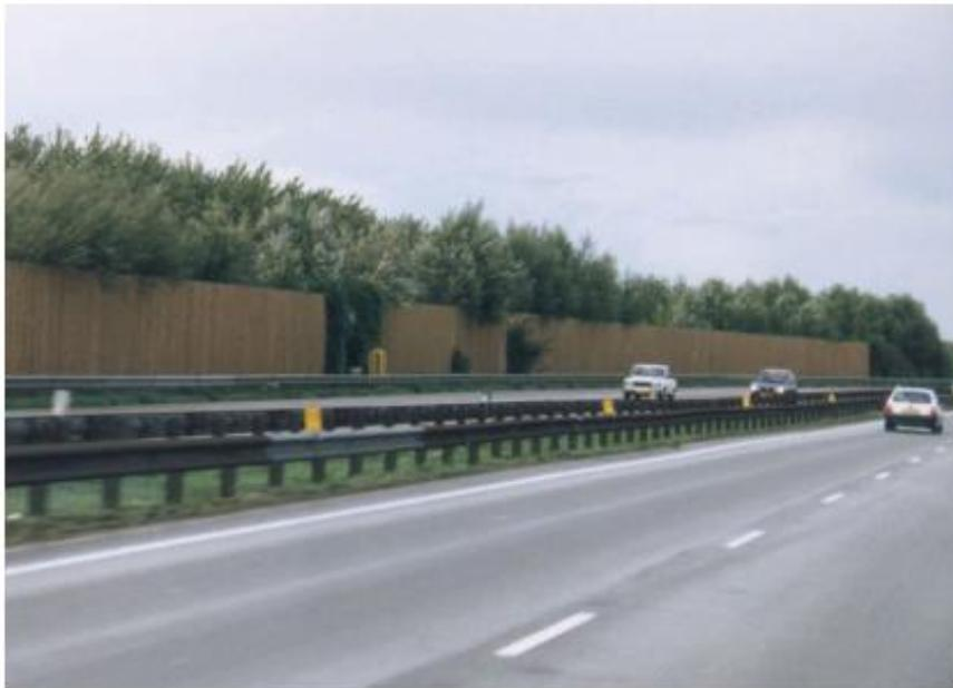
*Ilustración 33. Pantallas realizadas con módulos de madera. Tomada de [Estudio de la tipología de las pantallas acústicas. normativa y estado del arte]*
