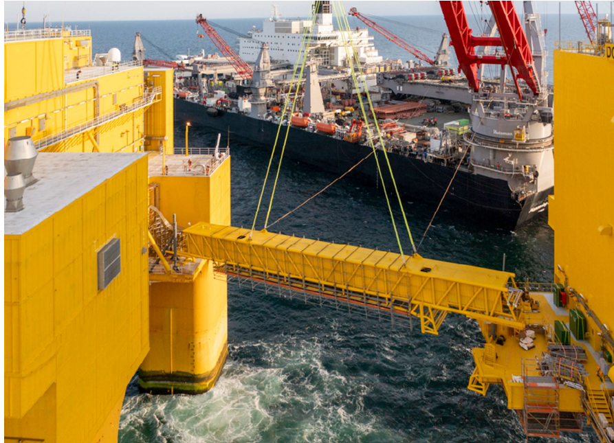
Figura 3.5: Puente para conexión entre las plataformas DolWin 6 y DolWin 2
