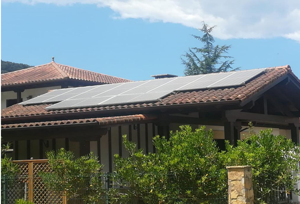
Figura 9. Instalación de paneles solares de Liendo
