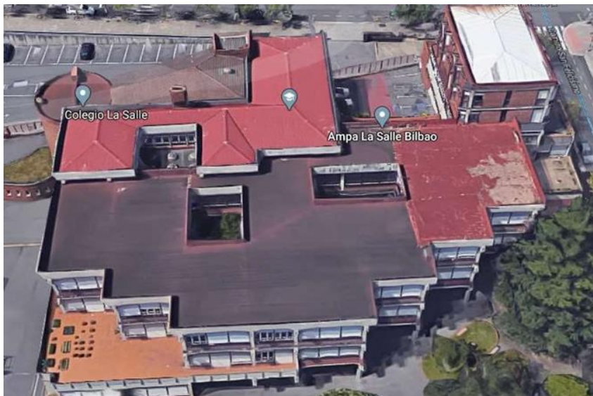
Figura 3. Vista de la cubierta donde se realizará la instalación fotovoltaica
