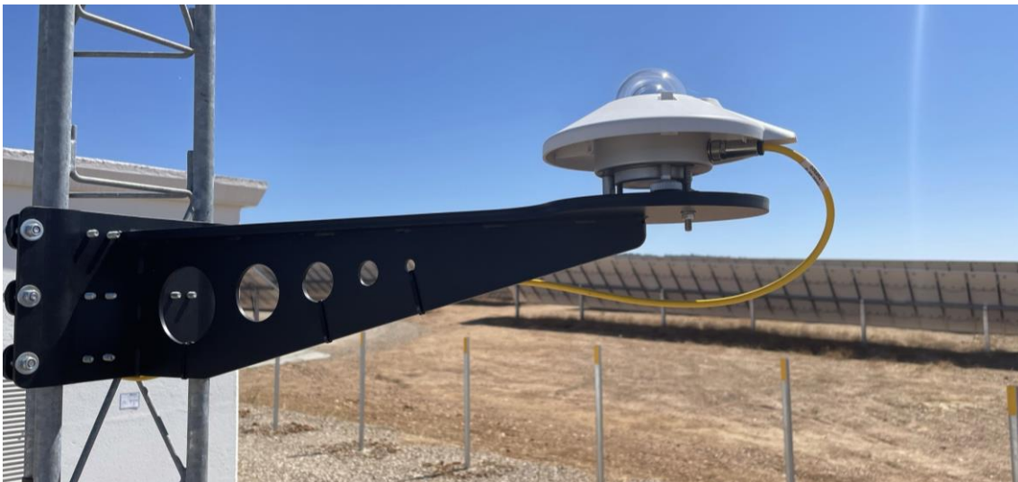
Figura 30. Piranómetro de la estación meteorológica.
