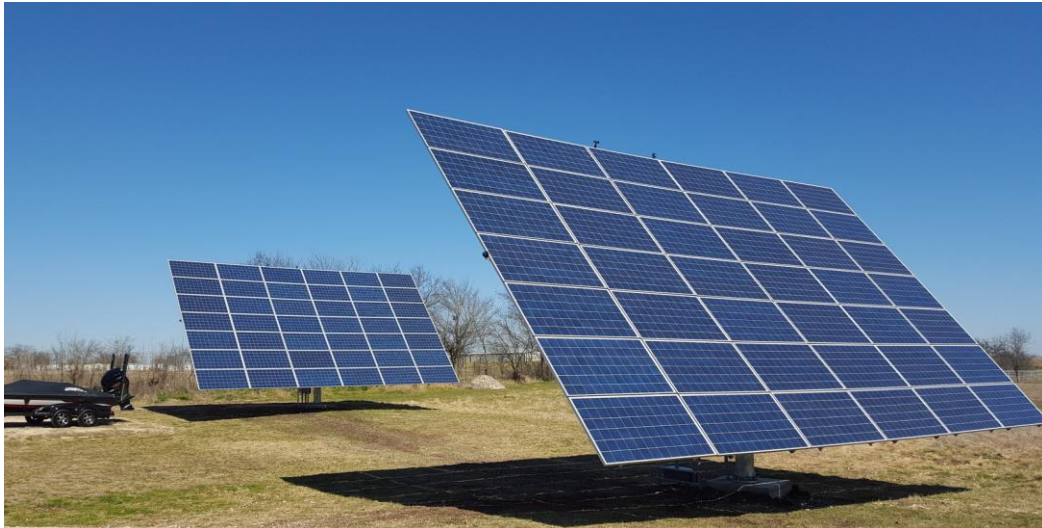
Figura 17. Seguidor de dos ejes. Fuente: [21].
