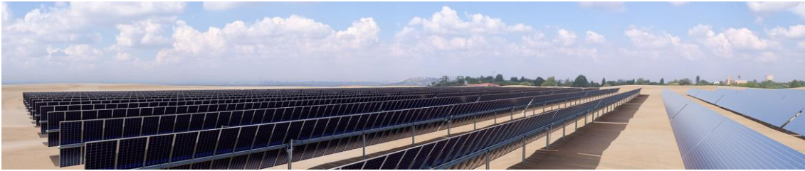
Figura 19. Dos filas de módulos en vertical en Trina Tracker Vanguard 2P.
