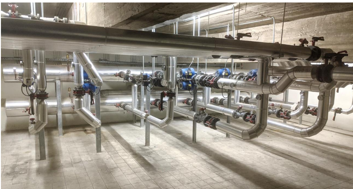
Figura 5 Circuito de distribución en sótano
