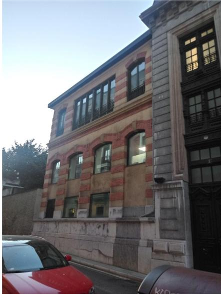
Figura 41. Vista del anexo del pabellón de oficinas añadido en 1910. Nótese los bloques de piedra oscura, que posiblemente están cegando el acceso a la construcción. Fotografía del autor.
