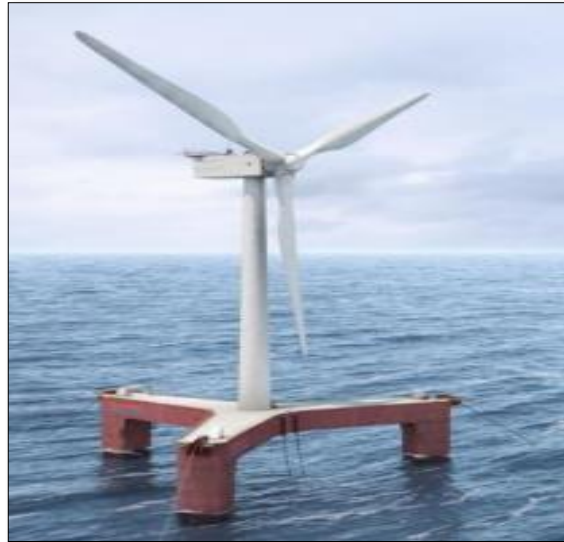
Ilustración 15: Representación de la estructura 'tri-floater'. (Fuente: GustoMSC).
