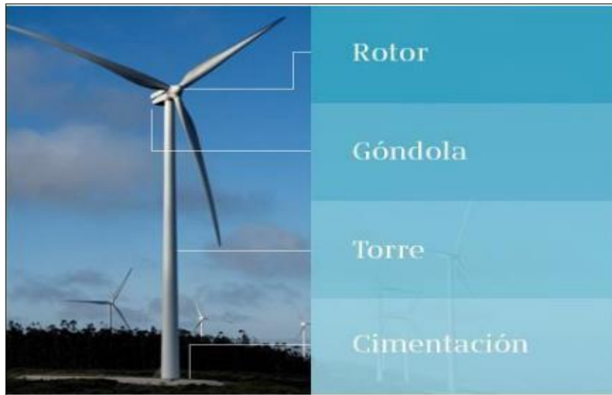
Ilustración 4:Partes de un aerogenerador.
