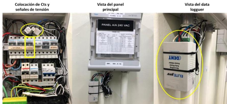
Figura 34: Vista de la instalación de sensores en la edificación tipo de la zona C - Provincia San José de Ocoa
