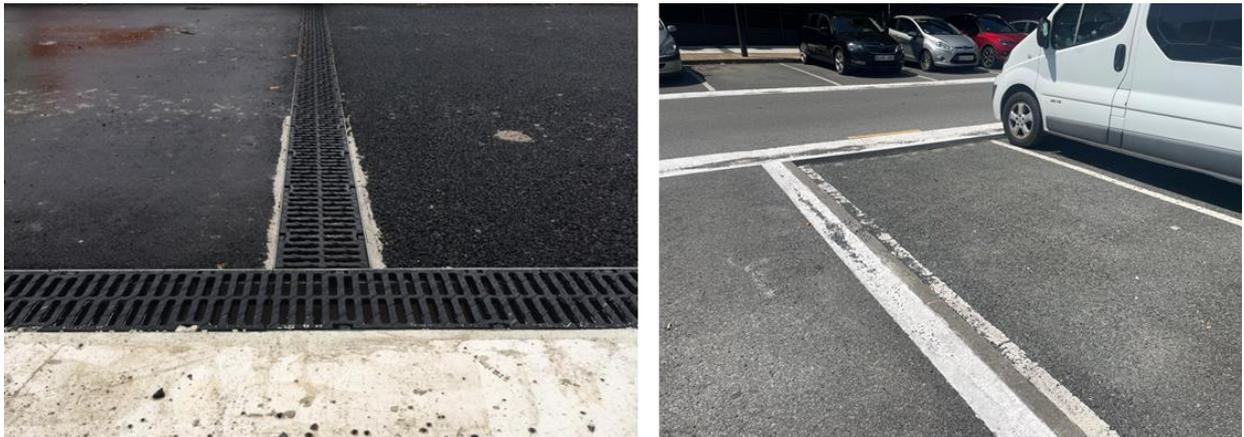
Figura 13. Pavimento acabado convencional y poroso. Fuente: Elaboración propia
