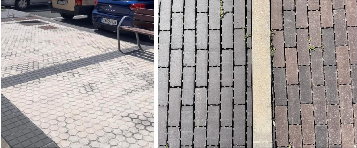
Figura 12. De izquierda a derecha: baldosa hexagonal, adoquín permeable Z1 y adoquín permeable Z2. Fuente: elaboración propia
