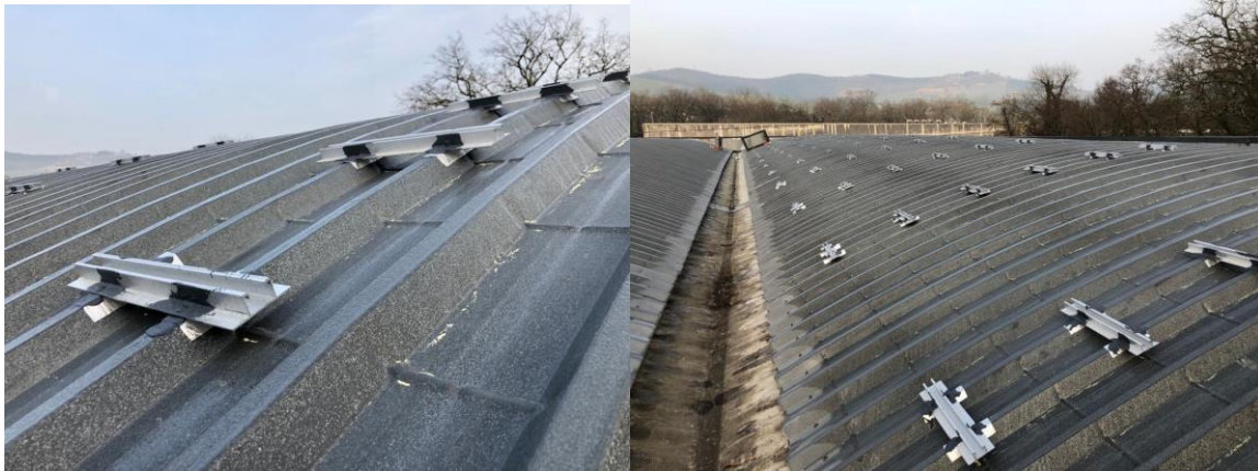
Imagen 57. Instalación de la estructura
