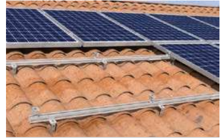
Detalle: Posicionamiento de las abrazaderas
