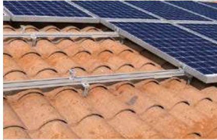
Detalle: Posicionamiento de las abrazaderas
