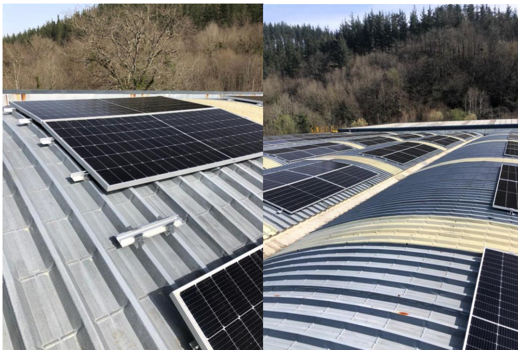
Imagen 59. Instalación de los módulos fotovoltaicos
