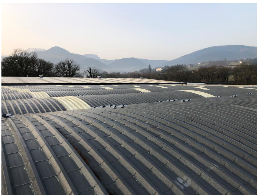
Imagen 30. Cubierta abovedada de chapa trapezoidal de la nave
