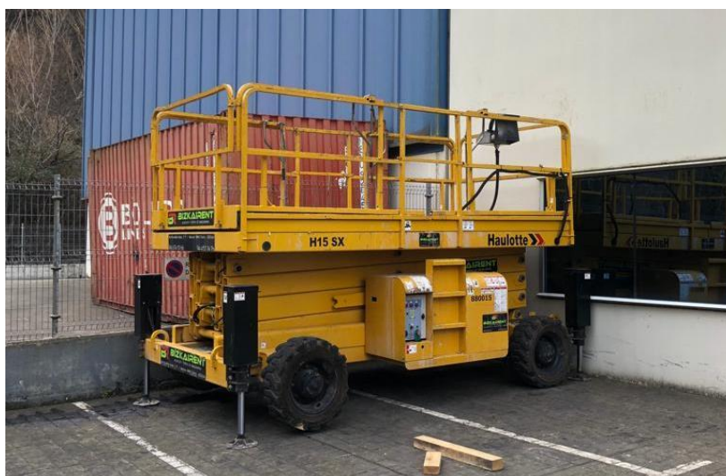
Imagen 61. Plataforma elevadora utilizada
