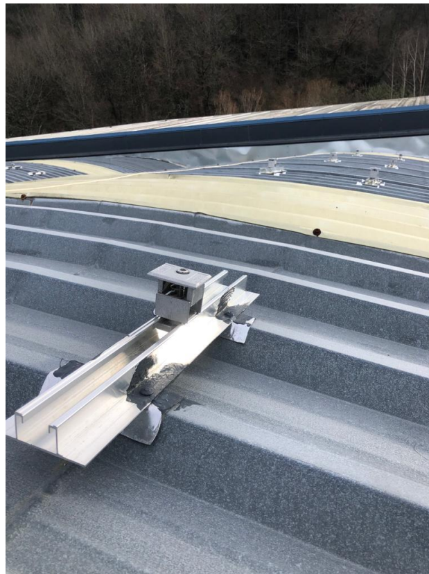
Imagen 58. Colocación de cabeceras
