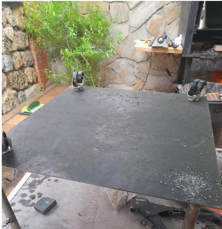
Ilustración 8 Colocación de las ruedas en la estructura inferior
