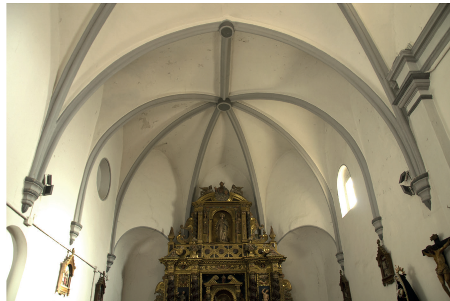
Fig. 3: Bóveda poligonal mediante trompas de la cabecera de la iglesia de Santa María de Bulbuentte. (Fotografía del autor)
