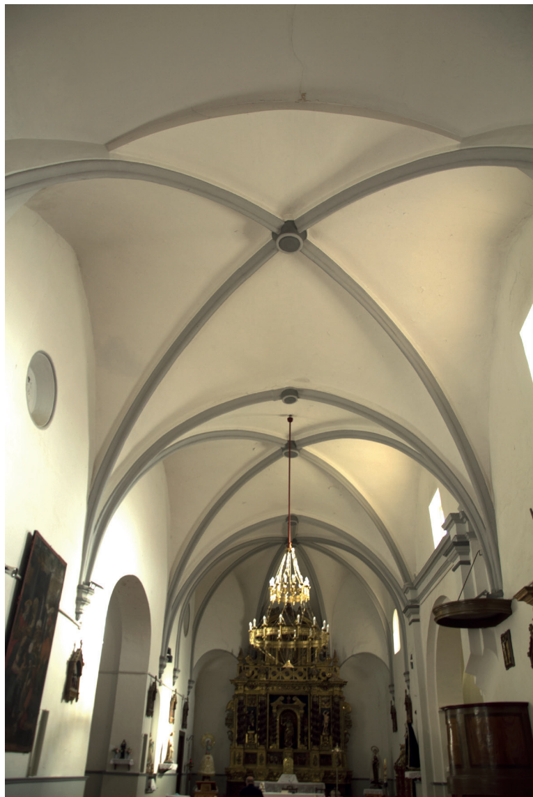
Fig. 2: Bóvedas de la nave central de la iglesia de Santa María de Bulbuentte. (Fotografía del autor)
