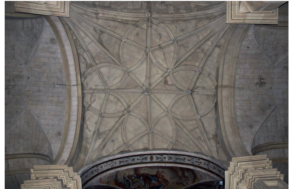
Fig. 4: Bóveda de la iglesia de San Andrés de Calahorra perteneciente a la antigua capilla mayor, hoy incorporada dentro de la nave central. (Fotografía del autor)
