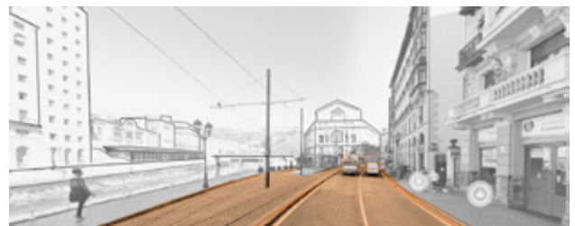
Figura 206. Calle de la Ribera, predominantemente vehicular, impermeable y sin vegetación de sombra. Fuente: elaboración propia
