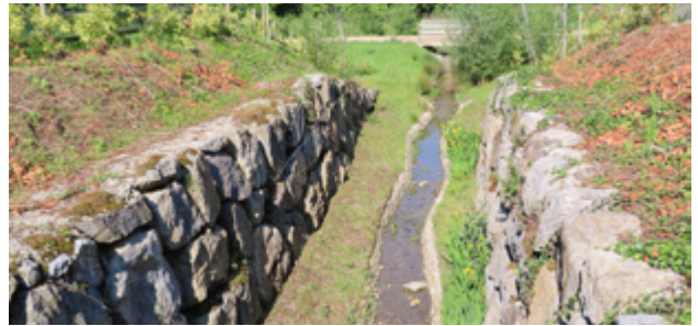
Figura 75. Arroyo descubierto. Fuente: elaboración propia
