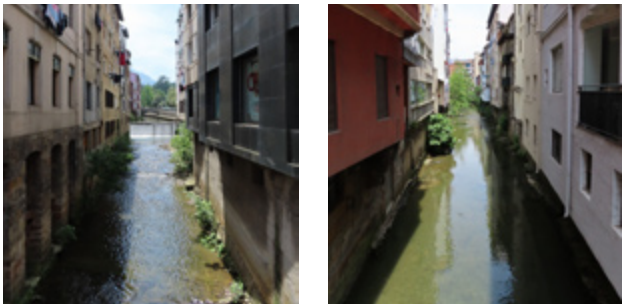
Figura 132. Vistas desde el puente de Andra Mari, hacia un lado y otro del río a su paso por el Centro Histórico de Durango. Fuente: elaboración propia
