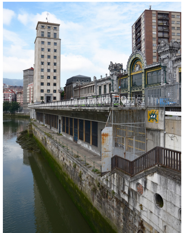
Figura 203. Antigua estación de la Naja. Fuente: elaboración propia
