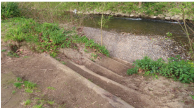
Figura 38. Formalización del acceso al cauce. Fuente: elaboración propia
