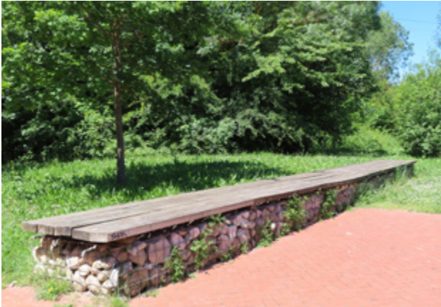
Figura 259. Banco de láminas de madera sobre estructura de gaviones. Fuente: elaboración propia
