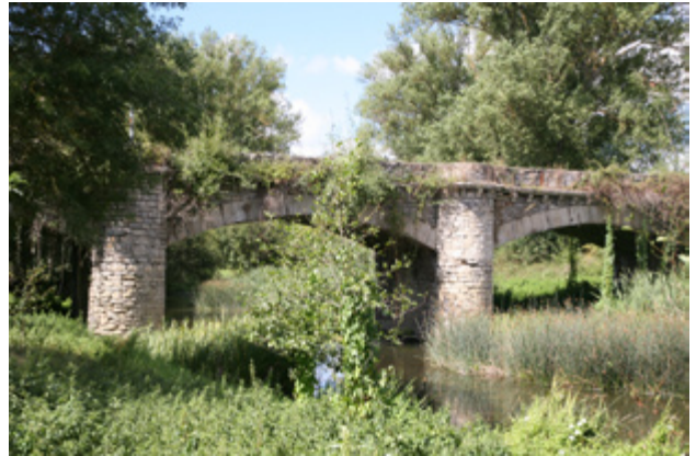
Figuras 247. Vistas del puente de Asteguieta (siglo XIX). Nivel de Protección Media, Gobierno Vasco. Fuente: elaboración propia
