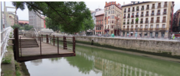
Figura 205. Pasarela peatonal en voladizo. Ejemplo de intervención mínima que vincula la trama urbana con la ría. Fuente: elaboración propia
