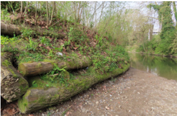
Figura 42. Restauración muro krainer. Fuente: elaboración propia
