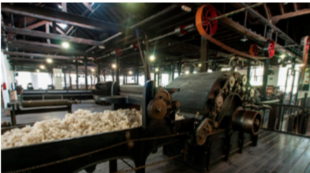
Figura 212. Detalle de la maquinaria utilizada en el proceso de producción textil (en la actualidad la fábrica ha sido reconvertida en un museo). Nivel de Protección Especial, conjunto monumental del Camino de Santiago. Fuente: página web de La Encartada
