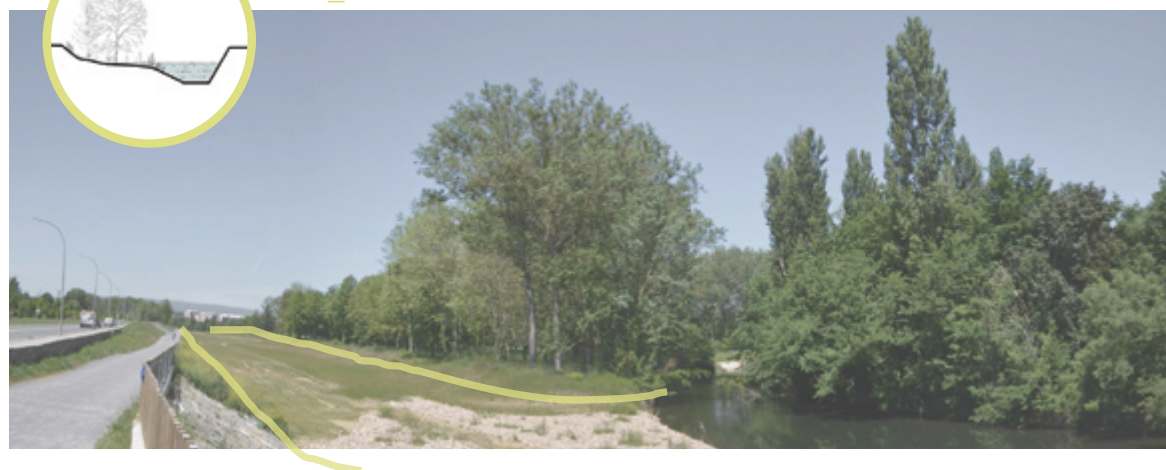
Figura 17. Comparativa gráfica de las diferentes casuísticas de tipologías de encauzamiento: CH1, río Nervión a su paso por Bilbao; CH2, río Uru-mea a su paso por el barrio Donostiarra de Martutene; CH3, río Zadorra a su paso por Vitoria-Gasteiz. Fuente: elaboración propia
