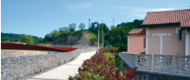
Figura 81. Nuevo acceso peatonal (rampa accesible) tras cruzar el nuevo puente. Fuente: elaboración propia
