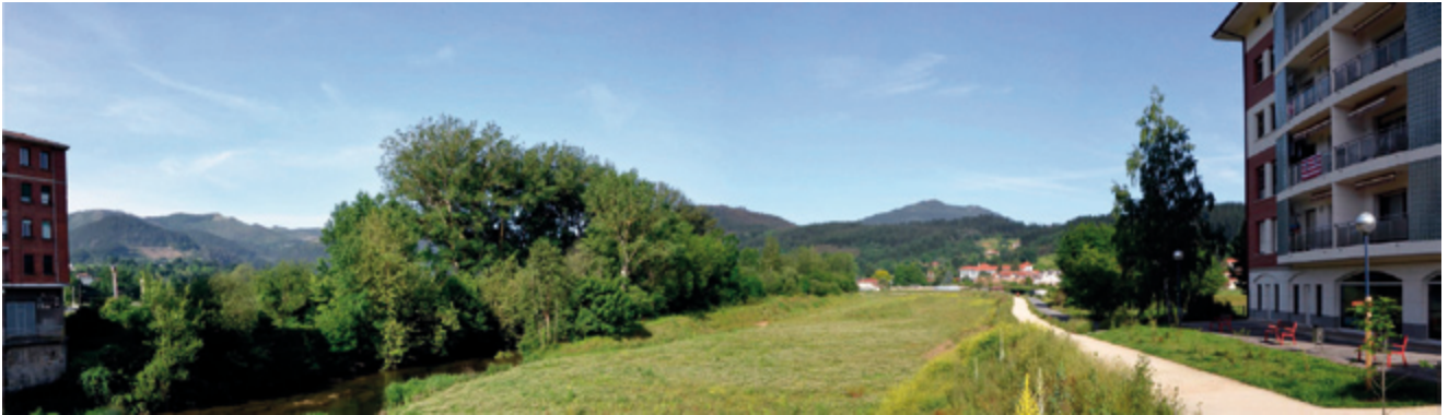
Figura 218. Panorámica de la obra hidráulica de doble encauzamiento y la trama urbana del barrio de Mimetitz. Fuente: elaboración propia
