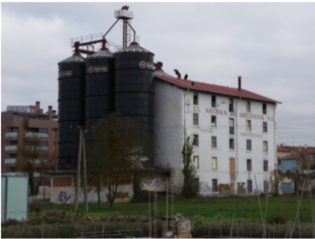
Figura 246. Áncora de Abechuko. Nivel de Protección Estructural en el Catálogo de Edificios Sometidos al Régimen Especial de Protección del PGOU de Vitoria-Gasteiz. Fuente: elaboración propia
