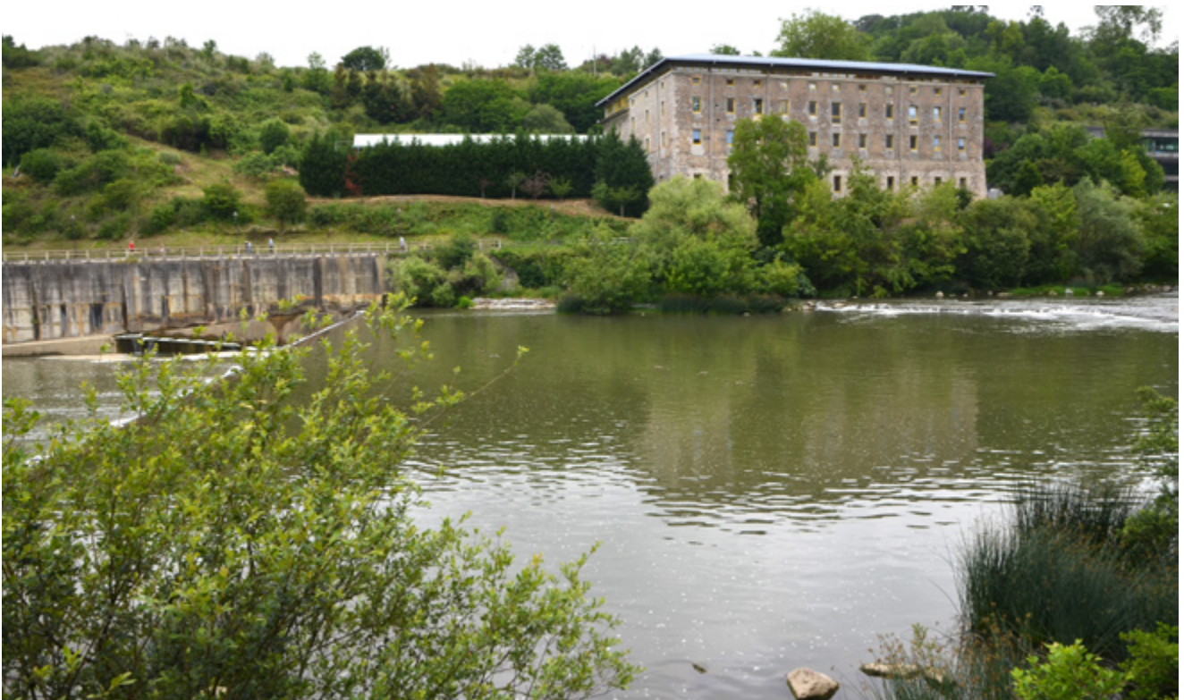
Figura 196. Continuación del Paseo de los Caños y la Ikastola Abusu (antiguo molino y panadería El Pontón). Vista desde la margen izquierda. Fuente: elaboración propia
