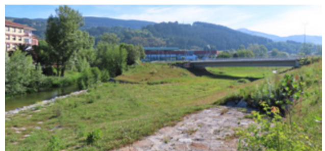
Figura 223. Ampliación del cauce de avenidas. Fuente: elaboración propia
