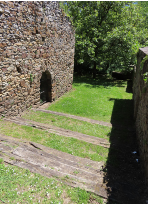
Figura 242. Escaleras de acceso al conjunto patrimonial de Bolunburu mediante traviesas de tren. Fuente: elaboración propia
