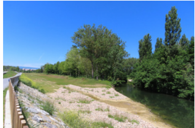
Figura 270. Encuentro entre el nuevo cauce (izqda.) y el original (dcha.). En el centro, se genera una isleta arbórea. Fuente: elaboración propia
