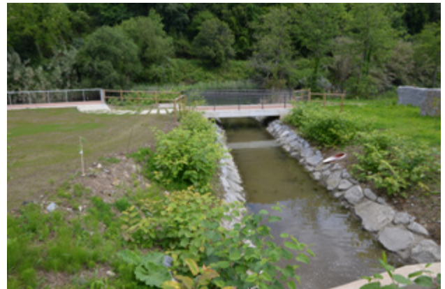
Figura 95. Canales de drenaje con taludes vegetados. Fuente: elaboración propia
