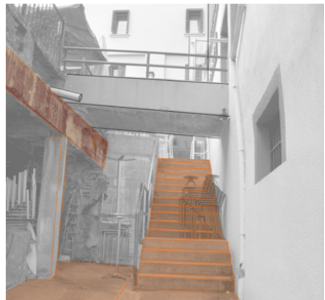
Figura 128b. Acceso actual mediante escaleras no accesibles. Fuente: elaboración propia
