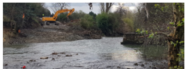
Figura 155. Obras de demolición de la presa Arripausoeta. Fuente: elaboración propia
