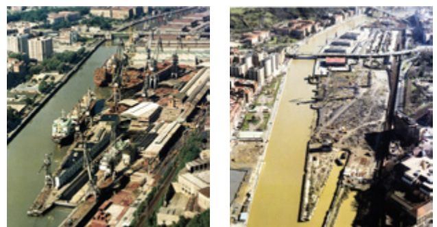
Figura 173. El Astillero Euskalduna antes de la demolición (1975) —izquierda— y después de la demolición (1995) —derecha—. Fuente: AVPIOP (2018)
