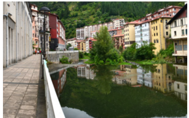
Figura 125. Panorámica del paseo público en superficie sobre el muro de encauzamiento. Fuente: elaboración propia
