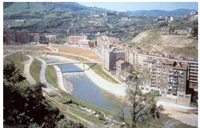
Figura 186. Defensa del barrio de La Peña contra inundaciones del río Nervión (estado previo a la izquierda). Fuente: Hispagua
