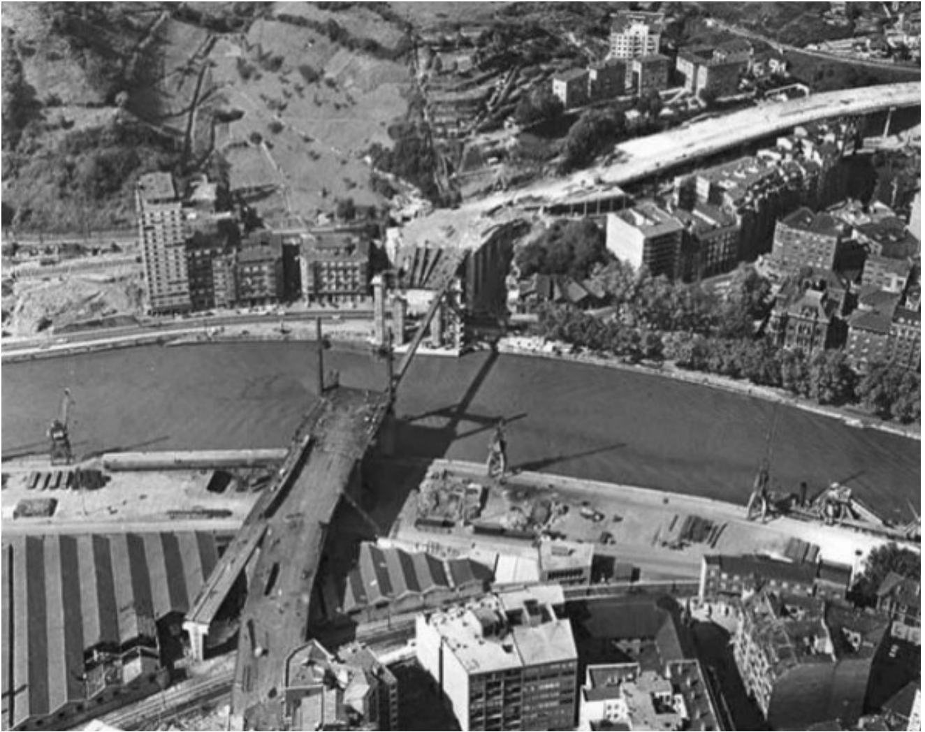
Figura 179. Construcción del puente de La Salve (año 1970). Fuente: lasalvebilbao.eus
