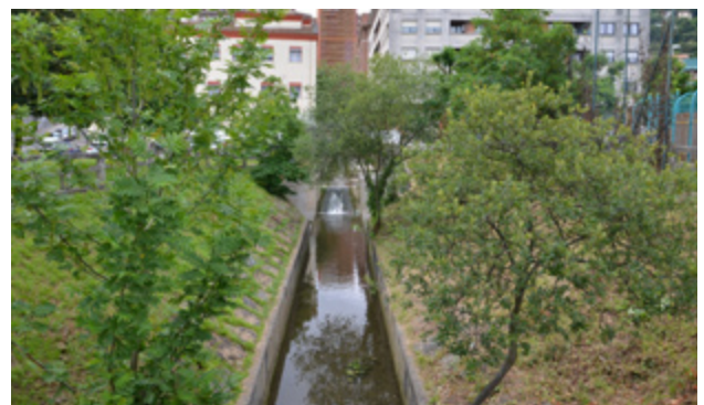
Figura 190. Encauzamiento «a cielo abierto» naturalizado del arroyo. Fuente: elaboración propia
