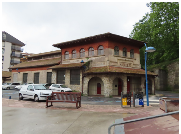
Figura 32. Vista actual del Matadero. Fuente: elaboración propia
