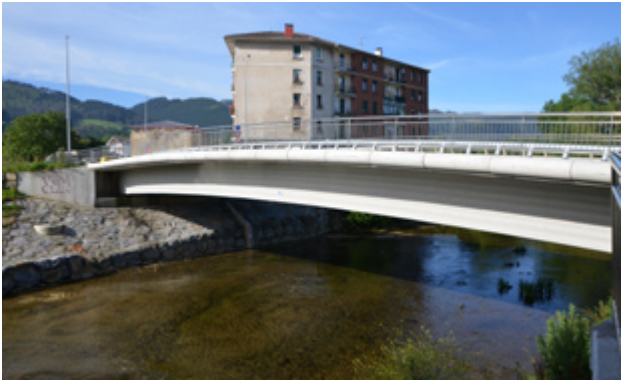
Figura 220. Nuevo puente de «El Charco». Fuente: elaboración propia
