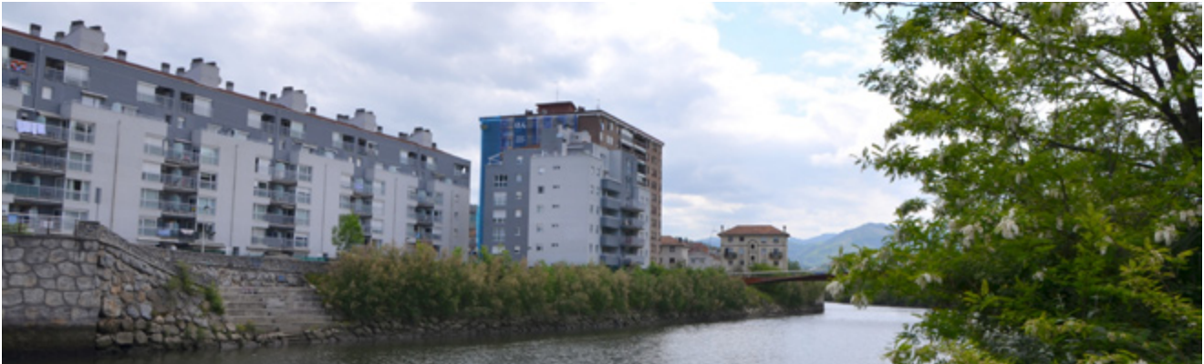
Figura 79. Panorámica del resultado de las obras de encauzamiento en el barrio de Martutene: la nueva fachada fluvial. Fuente: elaboración propia
