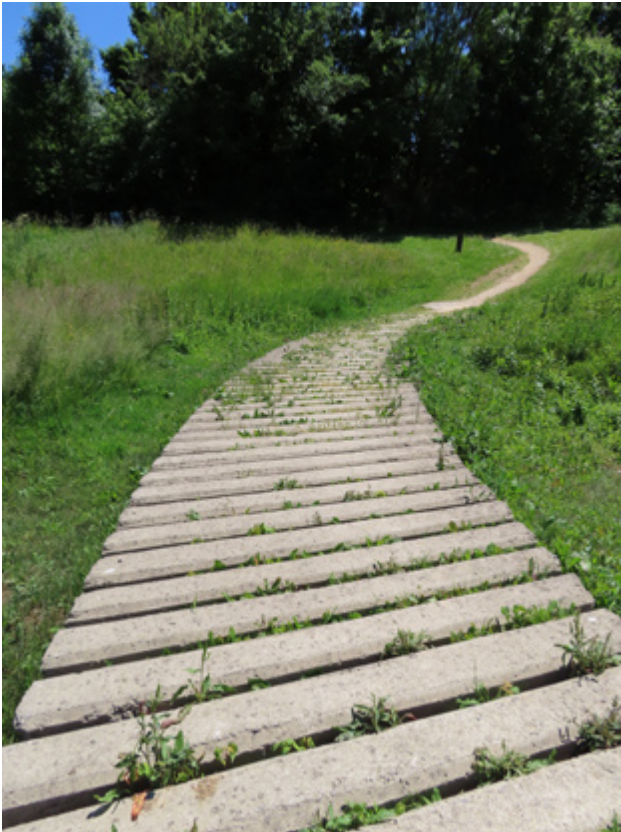
Figura 271. Pasarela permeable de losas intercaladas que cruza el cauce de avenidas. Fuente: elaboración propia
