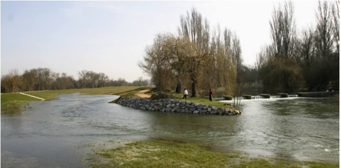
Figura 265. Integración socio-ecológica de las obras hidráulicas del río Zadorra para evitar su desbordamiento y las inundaciones en el núcleo de Gamarra. Fuente: Ayuntamiento de Vitoria-Gasteiz
