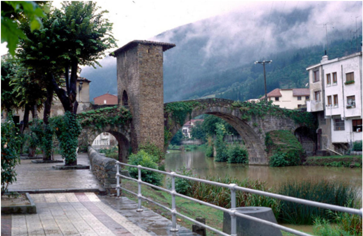
Figura 211. Puente de Zubizaharra. ARRIBA: foto antigua del puente, el río y su popularidad como zona de baño, de Luis María Monte Abad, publicada en las redes sociales de «Balmaseda y tú». ABAJO: imagen actual del puente. Nivel de Protección Especial, Conjunto monumental del centro histórico de Balmaseda. Fuente: Departamento de Cultura y Política Lingüística del Gobierno Vasco
