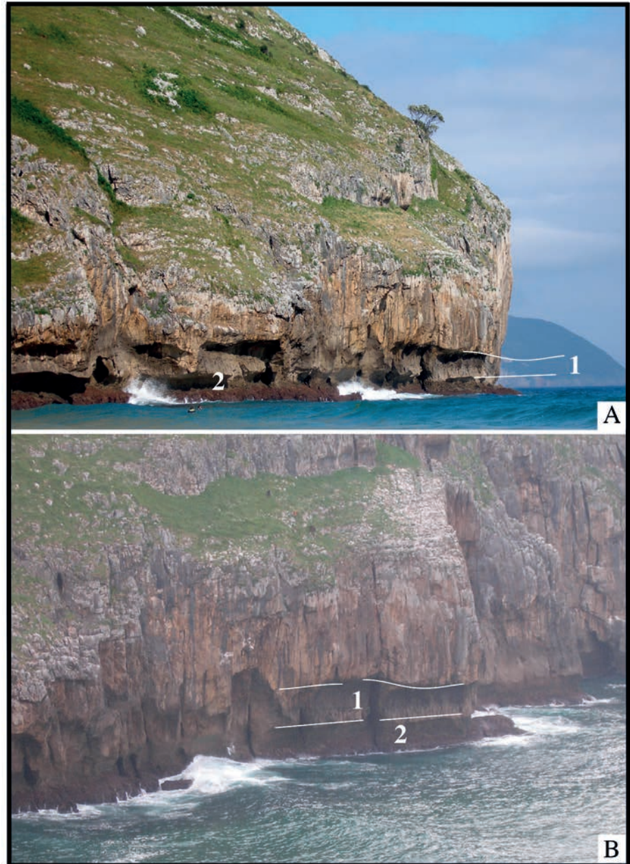
Fig. 12.- A. Aspecto general del farallón subvertical de caliza urgoniana remarcado con dos surf notches (1 y 2) en la salida occidental de la playa de Valdearenas (Sonabia). B. Detalle del surf notch 1 de mayor antigüedad, posiblemente formado durante la transgresión Flandriense y del surf notch 2 actual y/o subactual?. El acantilado presenta una densa red de fracturas subverticales y la zona no es accesible durante la bajamar.
