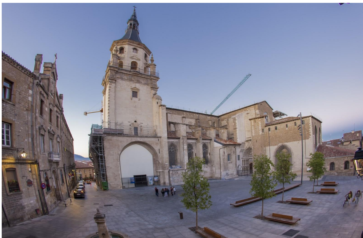
Figura I.1. Aspecto actual de la Catedral de Santa María (Vitoria-Gasteiz). Fotografía cedida por la Fundación Catedral de Santa María.
