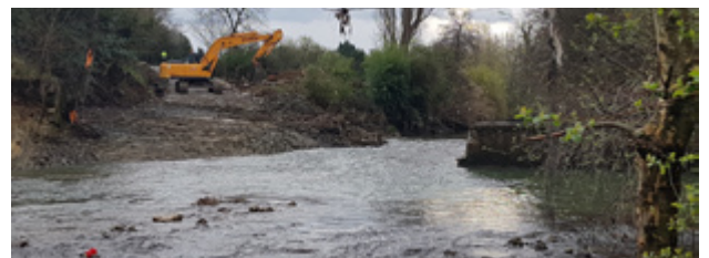
155. irudia. Arripausoeta presa eraisteko lanak. Iturria: egileak egina
