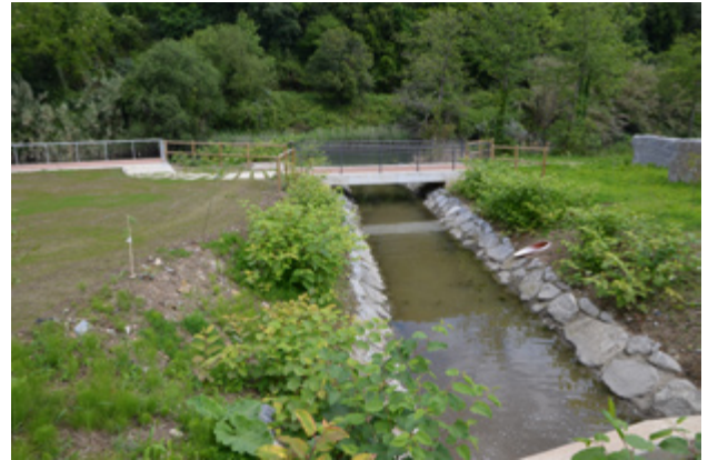
95. irudia. Ezpanda landareztatuekin egindako drainatze-kanalak. Iturria: egileak egina
