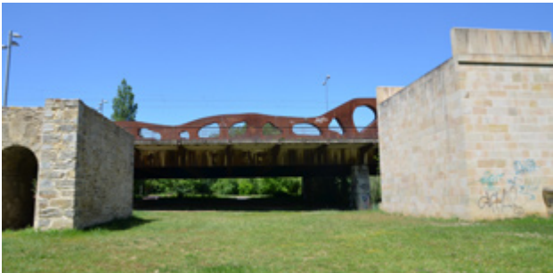
256. irudia. Zubi zaharrean irekitako zuloak bat egiten du zubi berriaren zuloarekin, eta horrek multzoaren ahalmen hidraulikoa areagotzen du. Iturria: egileak egina
