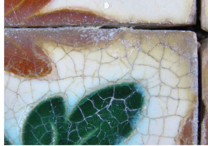
2. FISURAS (Figura 32).
