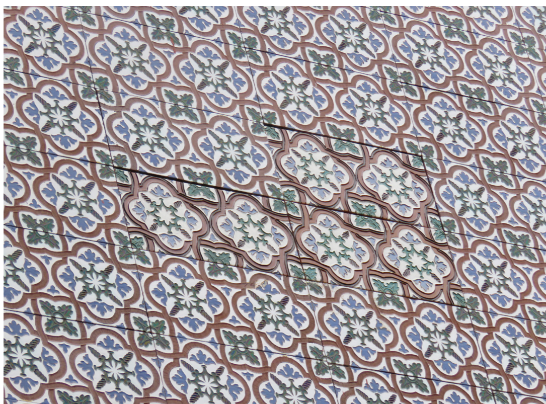
Figura 85 (arriba). Desnivelado de las piezas nuevas a modo de criterio de distinción, Mercado de la Ribera (Bilbao).
