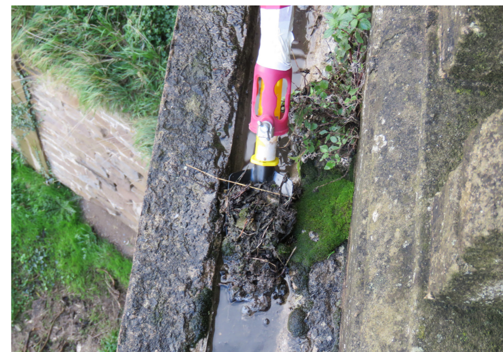
Figura 208. Desobstrucción del canalón para su correcto funcionamiento.
