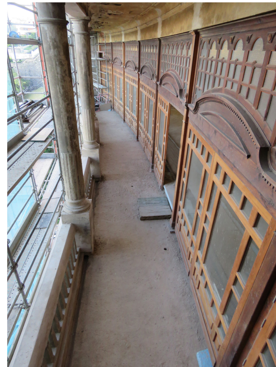
IMPERMEABILIZACIÓN DEL SUELO Y NIVELADO
