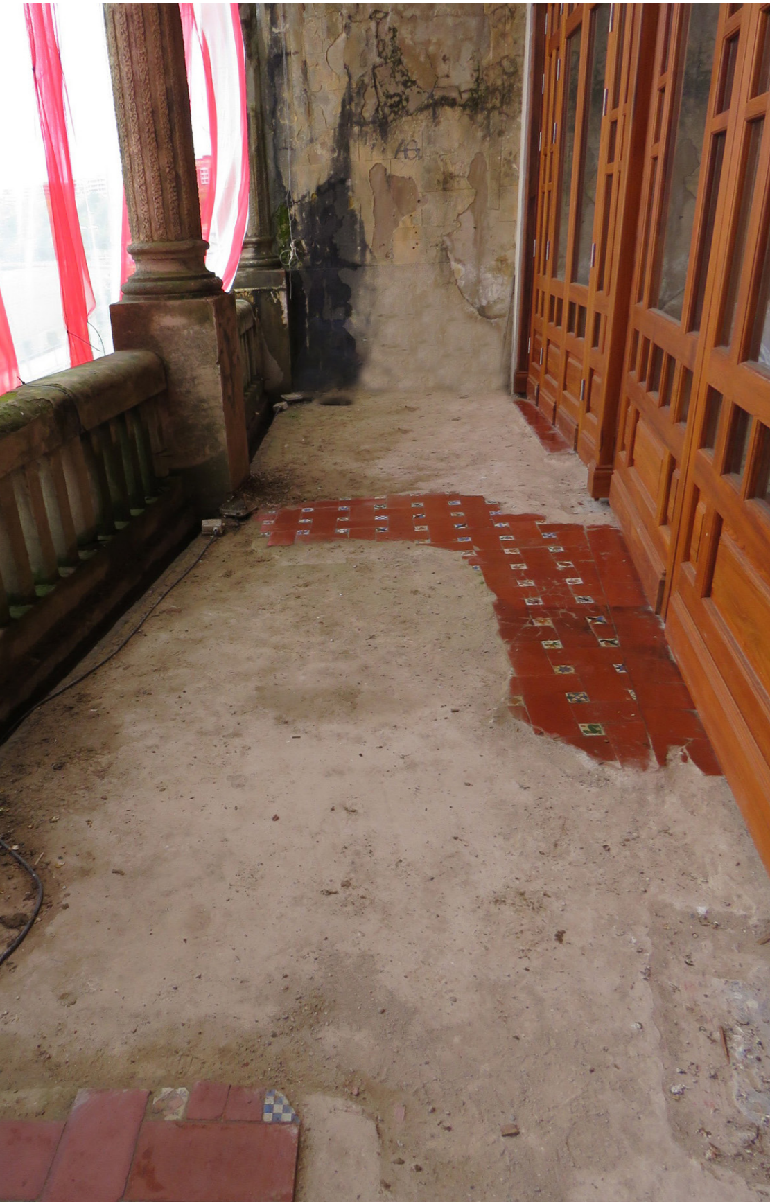
Figura 30. Suelo cerámico recuperado tras el desescombros (salón Galerías Punta Begoña).
