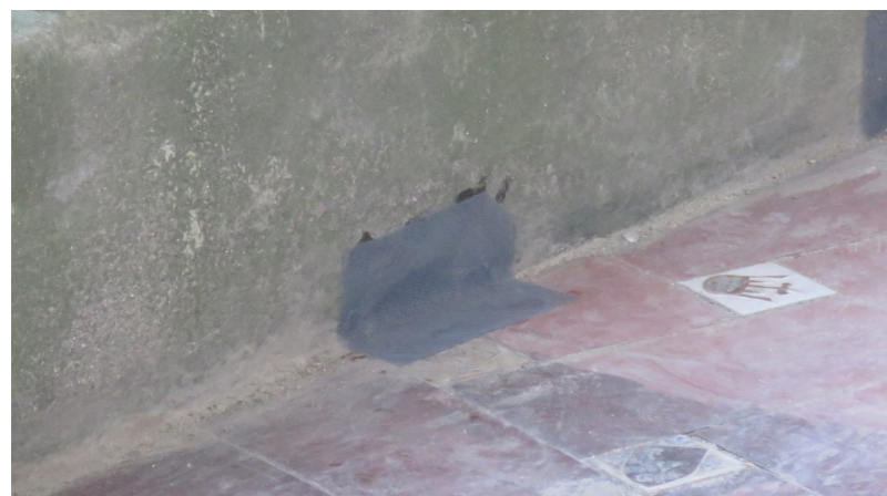
Figura 214. Instalación de rejilla, a modo de filtro, en los sumideros.
