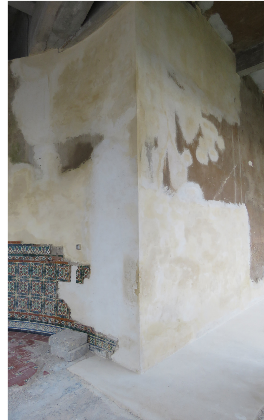
Figura 71 (dcha.). Restauración del muro tras la sustitución de los elementos deteriorados (ladrillos).
