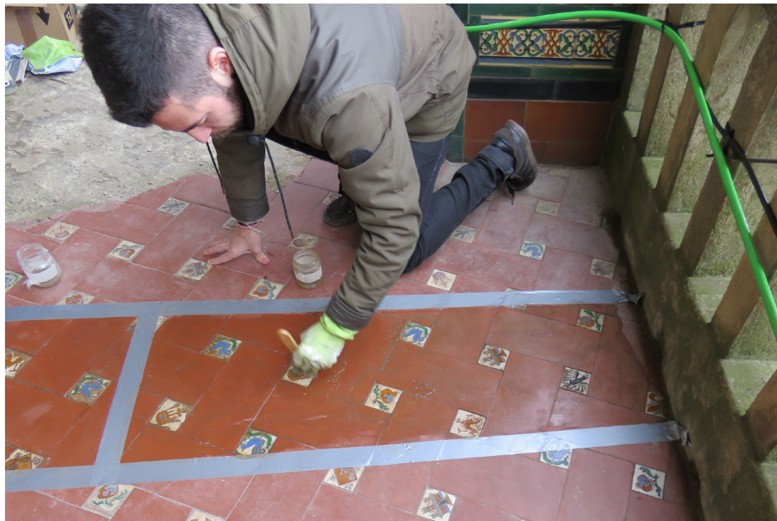
Figura 209. Aplicación del ácido en zona de pruebas del pavimento cerámico.
