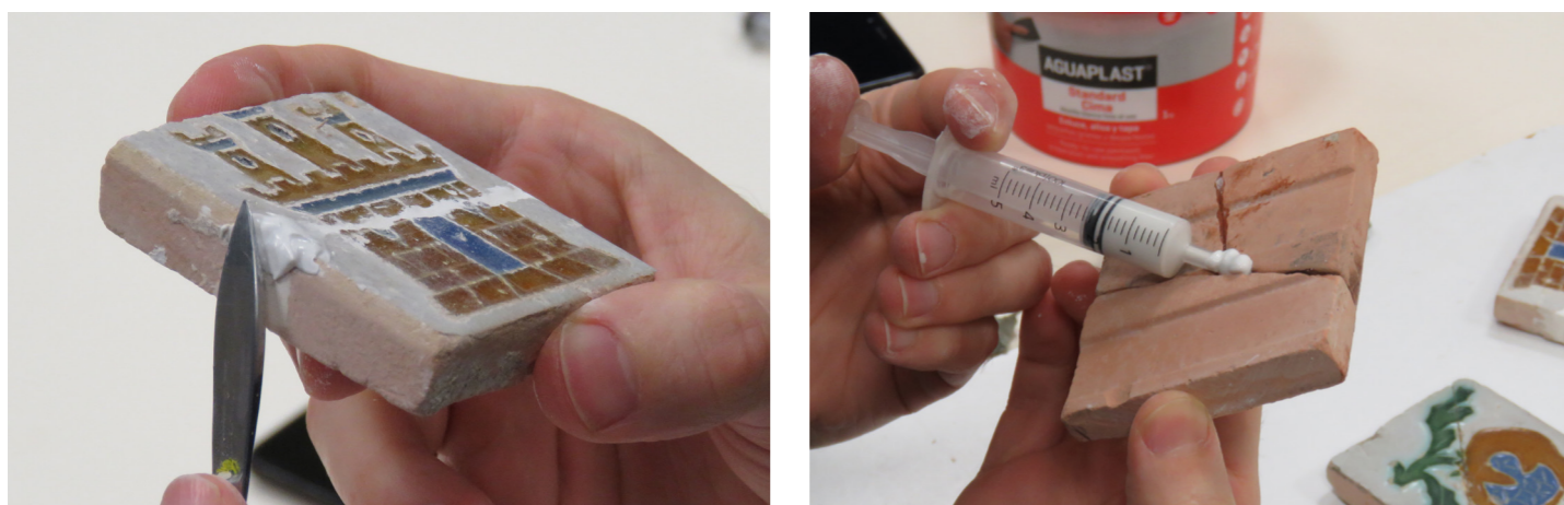
Figura 100 (izq.) Aplicación de la masilla selladora mediante escalpelo para grietas poco profundas.
