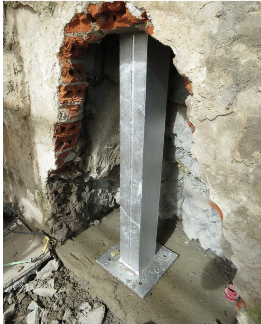
Figura 72. Instalación interna de vigas que soportarán y reforzarán el peso del muro.
