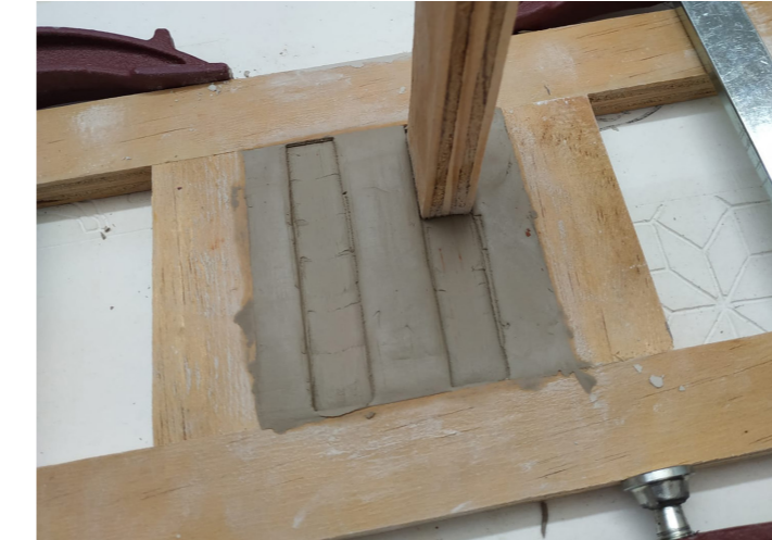
Figura 187. Realizar detalles propios del reverso de azulejos que facilitan su adherencia a la hora de colocarse.
