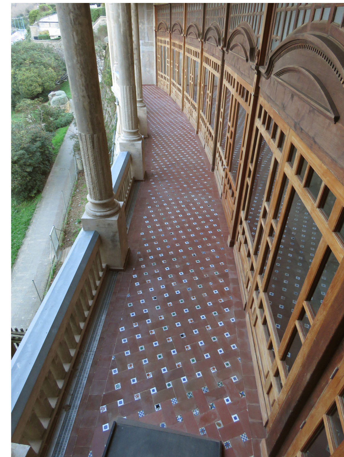
RESULTADO FINAL TRAS LA COLOCACIÓN DEL PAVIMENTO
