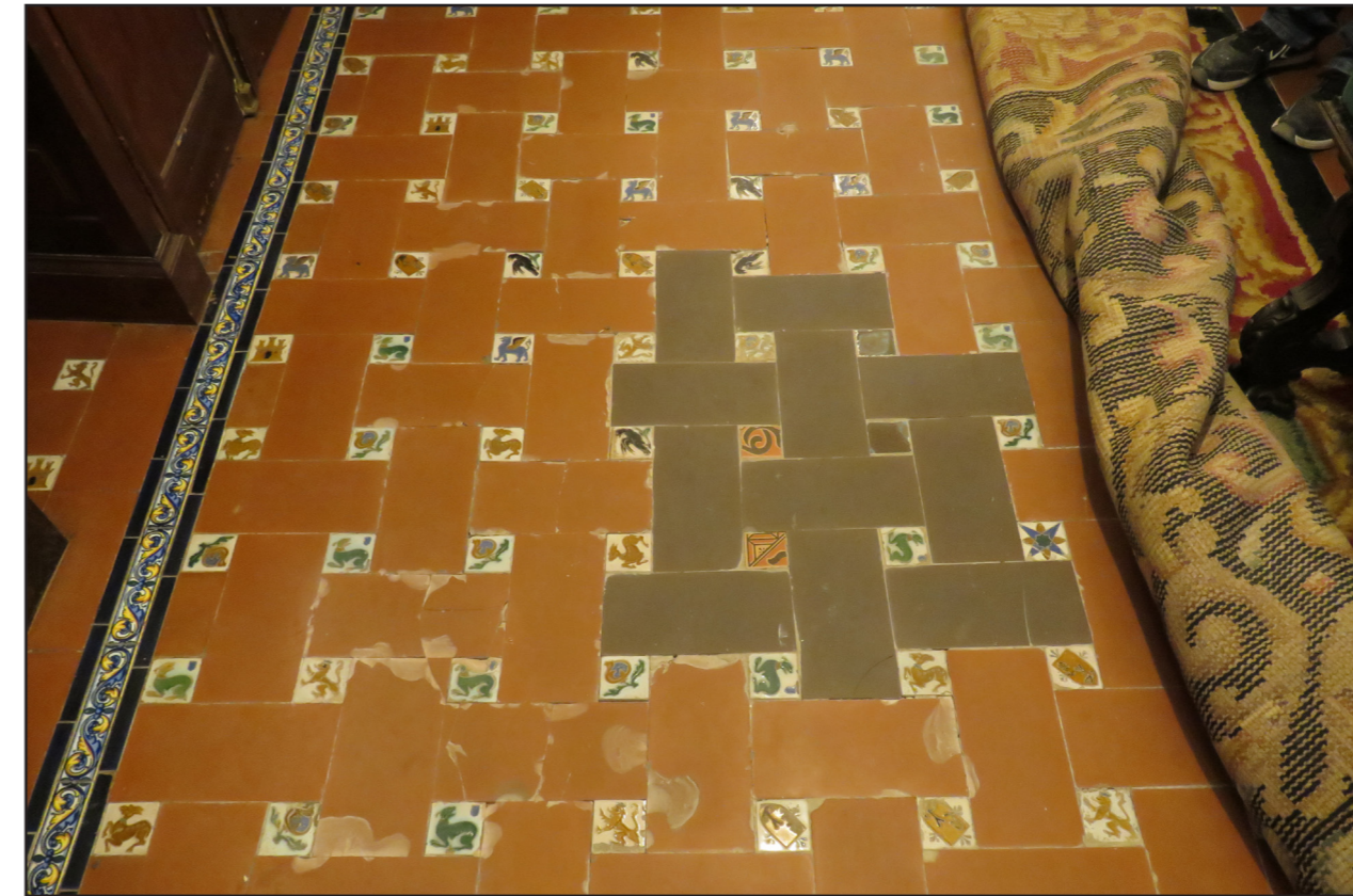
Figura 59. Recolocación incorrecta de baldosas bizcochadas y fragmentos de azulejos a forma de olambrillas (vivienda particular).
