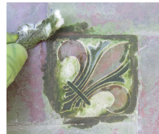
Figura 130 (abajo). Comparativa de una olambrilla antes y después de la eliminación del verdín.
