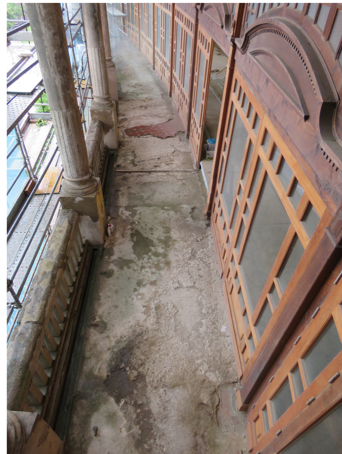
ARRANQUE DE LAS OLAMBRILLAS Y BALDOSAS
