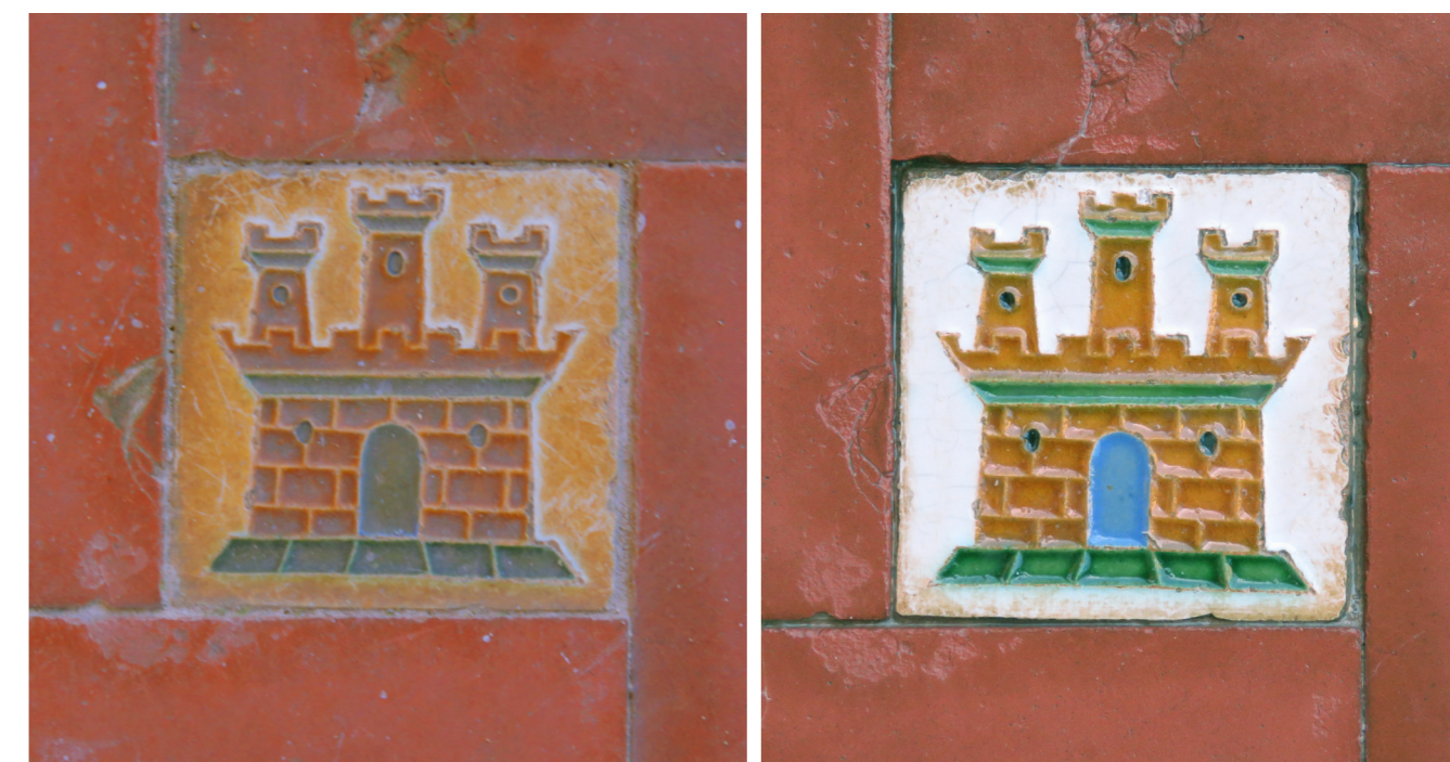
Figura 128. Comparativa de una olabrilla antes (izq.) y después (dcha.) de la eliminación de contaminantes atmosféricos artificiales.
