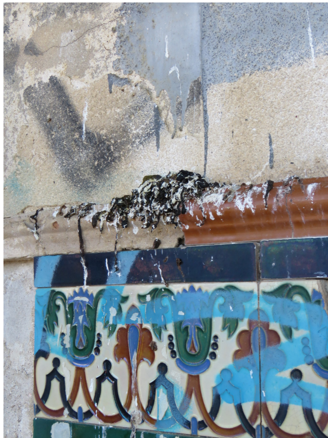
Figura 67 (izq.). Deyecciones de palomas depositadas sobre un zócalo cerámico.
