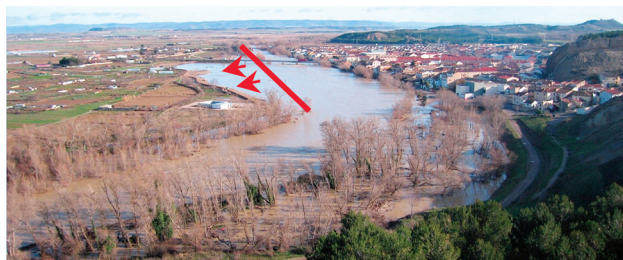
Fig. 4 – Élimination d'une digue en 2009 sur le fleuve Aragon à Caparrosa et son effet positif durant la crue de janvier 2010
