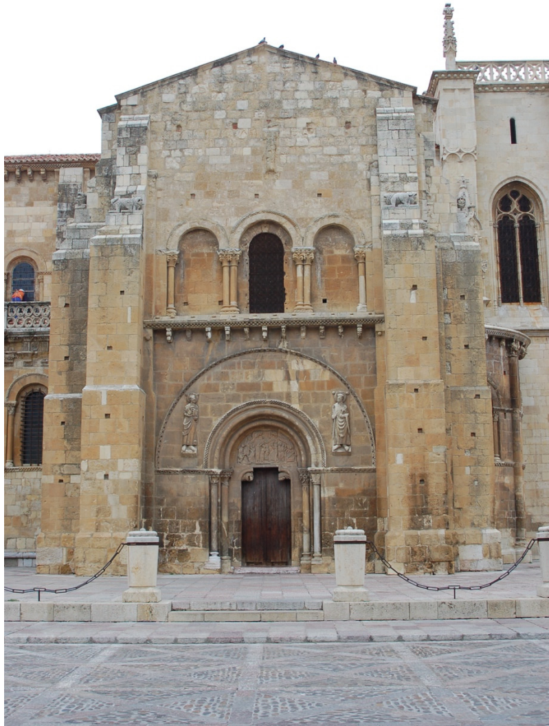
FIG. 15.2. FACHADA DEL BRAZO MERIDIONAL DEL TRANSEPTO CON LOS MECHINALES CUADRADOS DE LOS APUNTALAMIENTOS.
