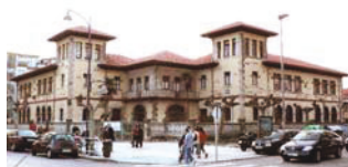
Escuelas Públicas Primo de Rivera. Situadas en Laredo, son un ejemplo claro de la arquitectura realizada por el Estado con una potente imagen que evoca la más pura tradición española como elemento a perpetuar.
