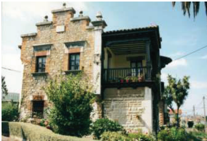
Viviendas para los maestros en Revilla de Camargo
