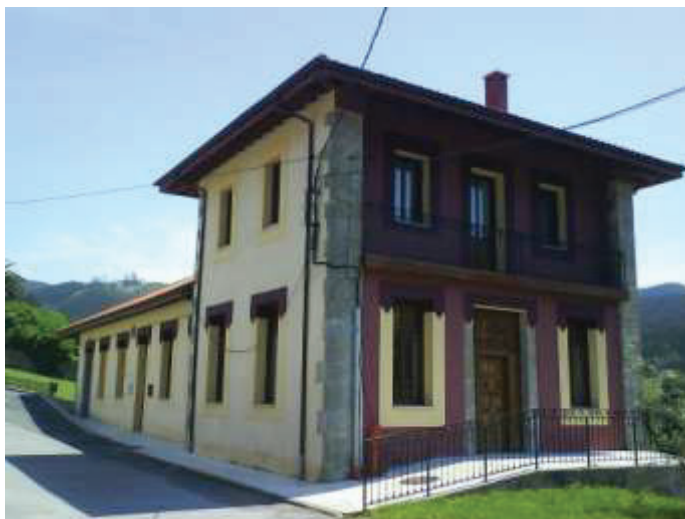
Estado actual de la escuela que acoge actividades de una asociación del barrio.
