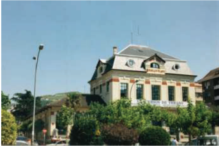
Fachada principal de las escuelas del Dr. Velasco
