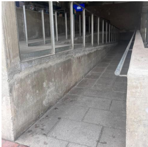
Figura 36. Rampa edificio B (Subida)
