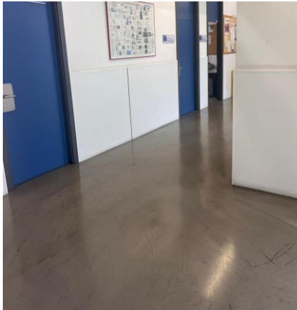
Figura 41. Línea libre columnas
