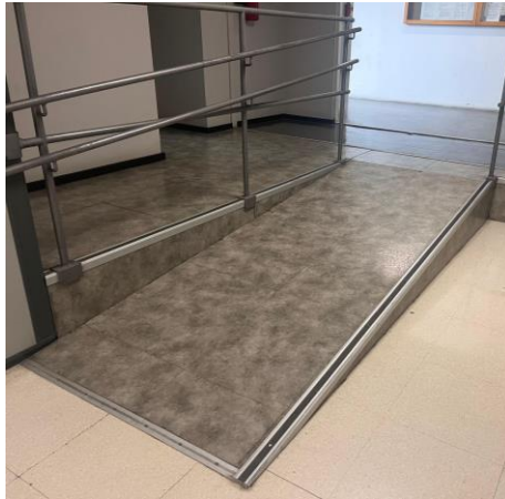
Figura 39. Rampa pasillo F
