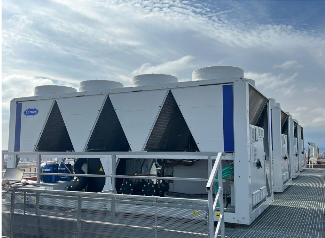
Imagen 41: Bombas de calor 30RQP520 instaladas
