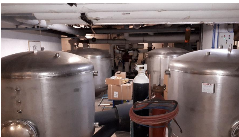
Imagen 5: Depósitos de consumo de ACS del Hotel Meliá Castilla
