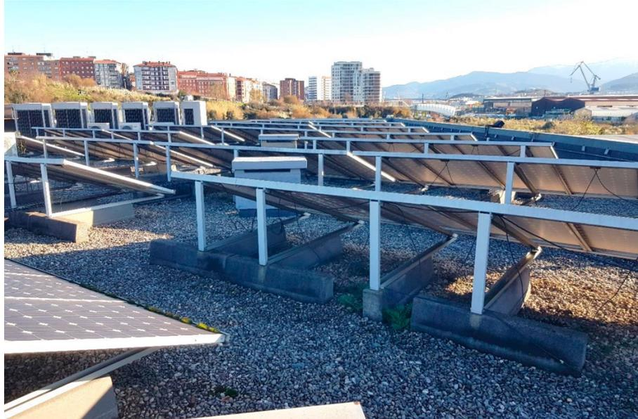
Ilustración 1: Foto de panel solar FV sobre elemento de sujeción en cubierta
