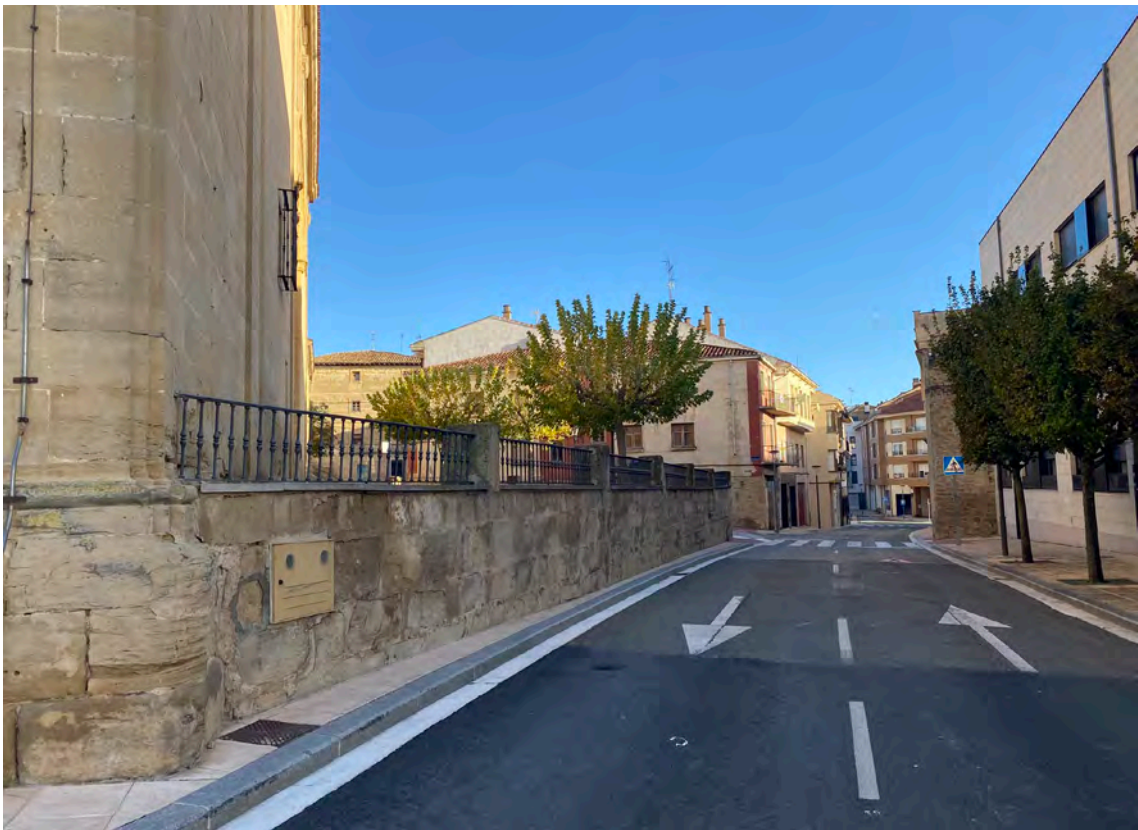
Ilustración 104: Travesía a su paso por la Iglesia parroquial de Oyón donde se aprecia el muro construido para salvar la diferencia de altura entre el pórtico y la carretera.
