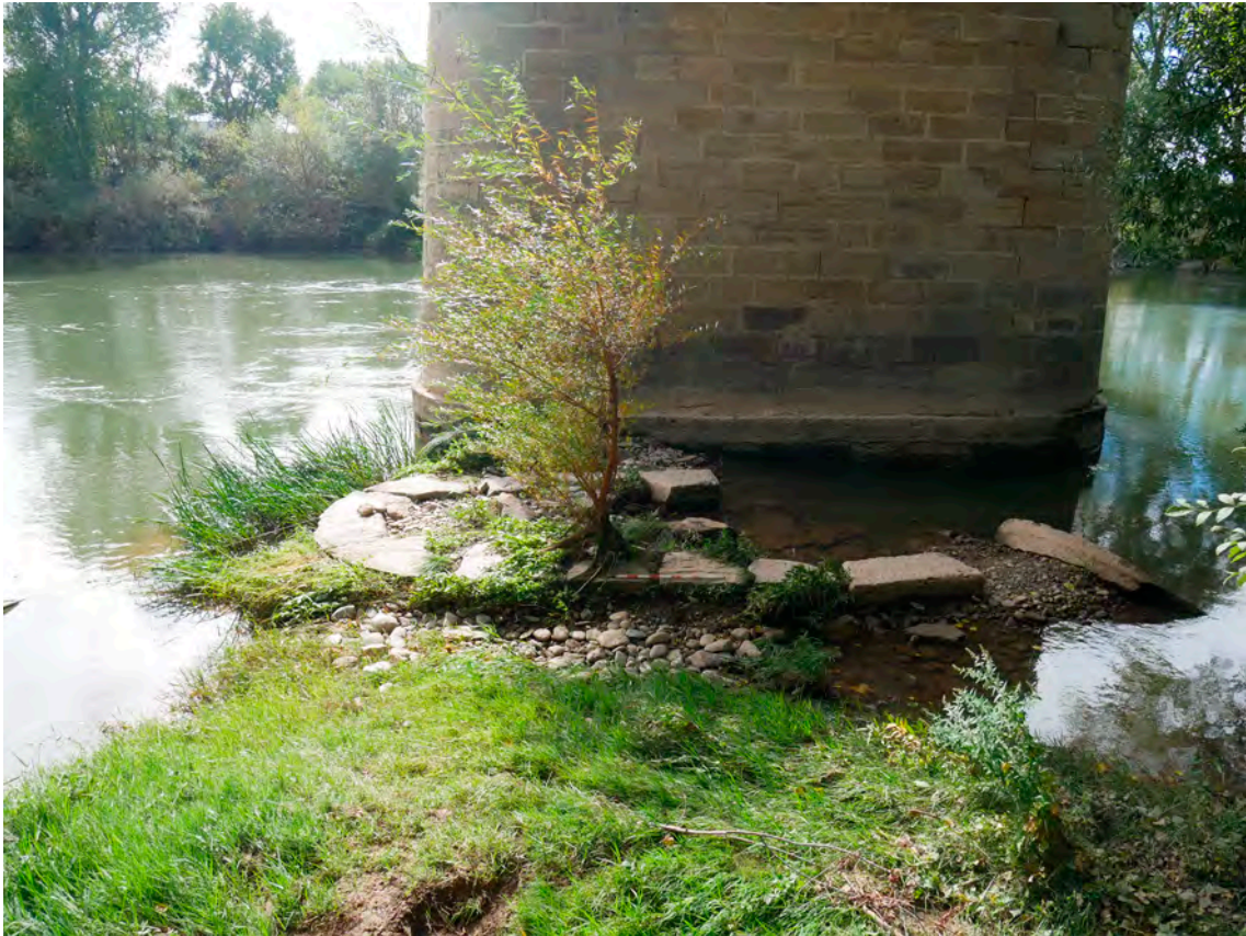
Ilustración 80: Vista parcial del puente de Elciego sobre el río Ebro con restos de la cimentación original.
