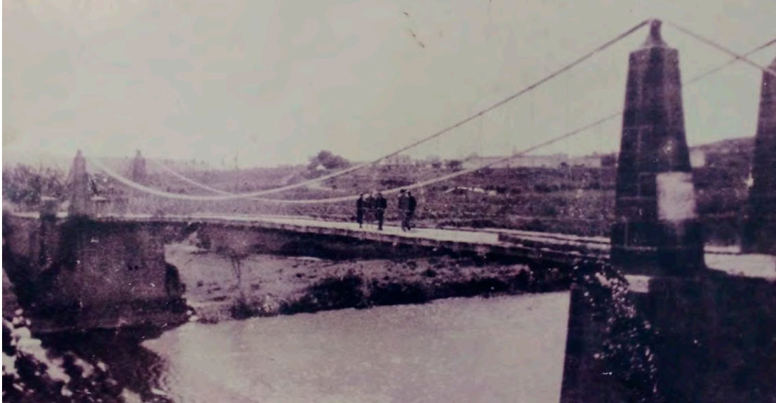
Ilustración 82: Fotografía del puente colgante de Lapuebla de Labarca. Fuente: Ayuntamiento de la Puebla de Labarca.
