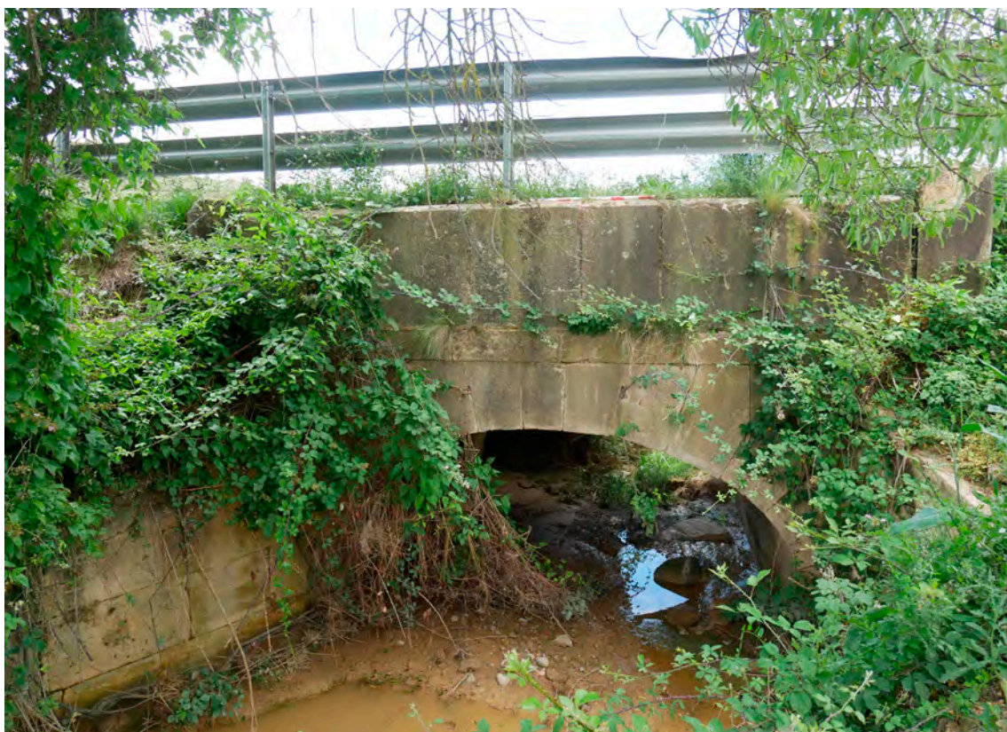
Ilustración 66: Puente sobre el barranco de Valles.
