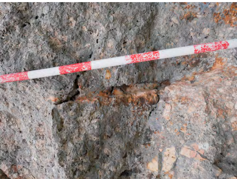
Ilustración 43: Marca de barrena en una roca junto a la carretera en el paraje de Las Canteras, junto al camino.
