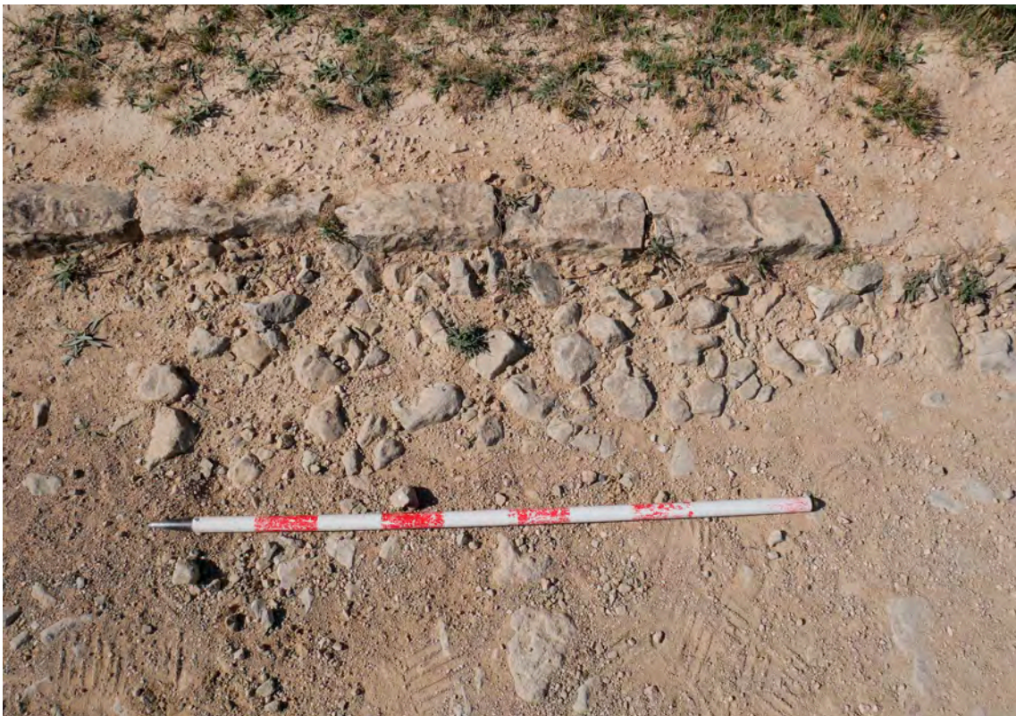
Ilustración 91: Restos del bordillo y firme del camino vecinal a Barriobusto.
