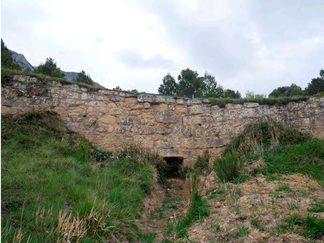
Ilustración 47: Muro y tajea en el punto kilométrico 36,260.
