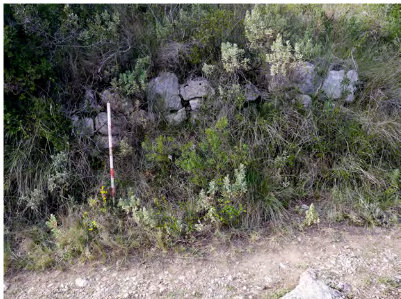
Ilustración 27: Muro de piedra seca en Chirimendo que estabiliza la ladera de un desmonte abierto a media ladera.
