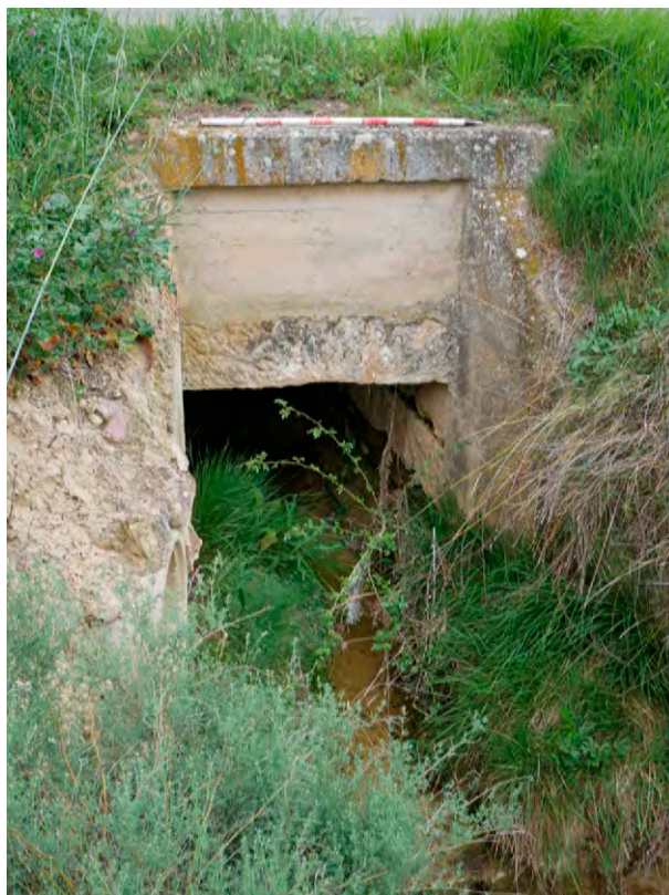
Ilustración 63: Tajea para el paso del arroyo Río Salado que preserva la estructura original de construcción. Punto kilométrico 58,500.
