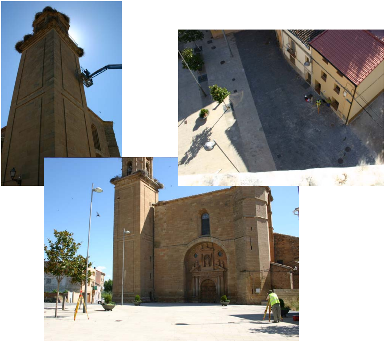
Figura 35. Imágenes de algunos de las operaciones realizadas en campo durante el proyecto de auscultación de la Iglesia de Agoncillo.
