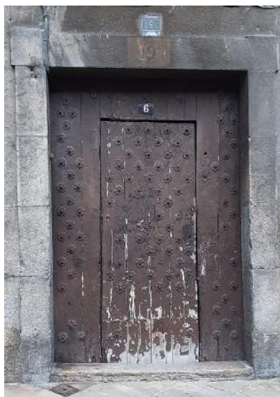
Imagen 35: puerta de acceso al edificio Galdona (elaboración propia)
