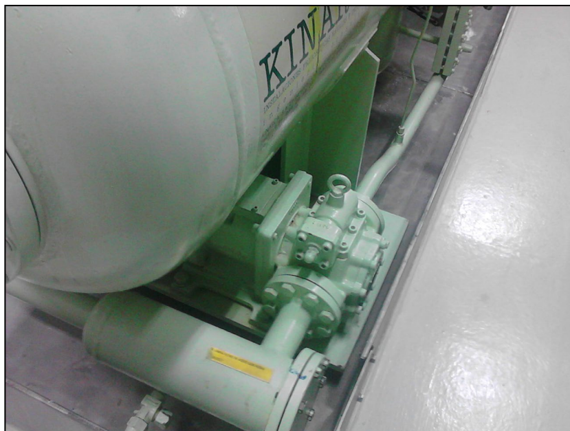
Figura 18. Pre-filtro y bomba de lubricación del compresor. (Fuente: Empresa atunera: Pesquería Vasco Montañesa) [13]
