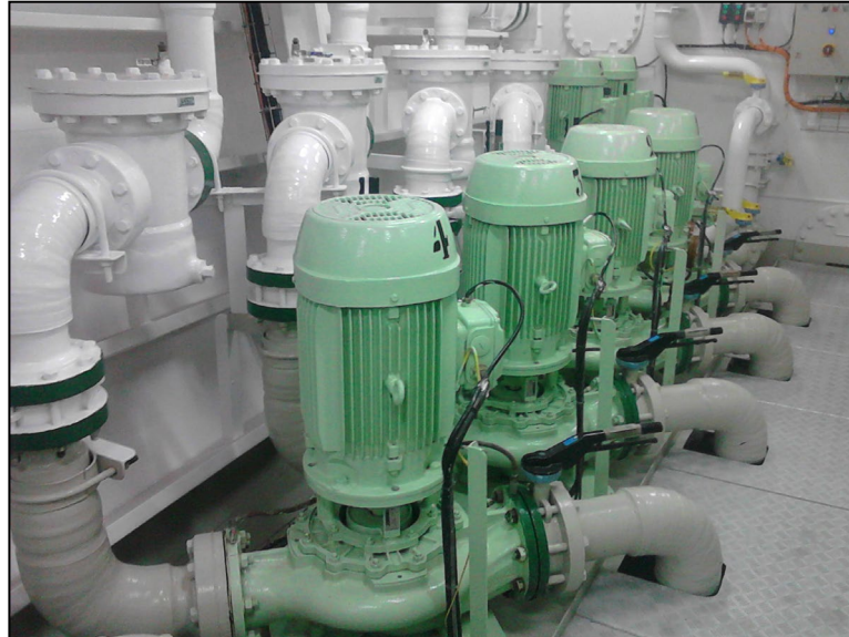
Figura 23. Bombas de agua salada para los condensadores de los compresores (Fuente: Empresa atunera: Pesquería Vasco Montañesa) [13]
