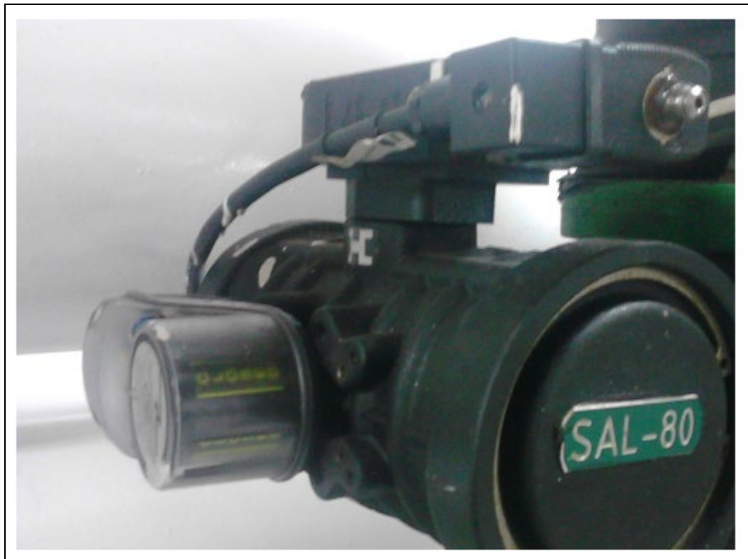
Figura 32. Electrovalvula neumática con señalización abierta/cerrada del sistema.
