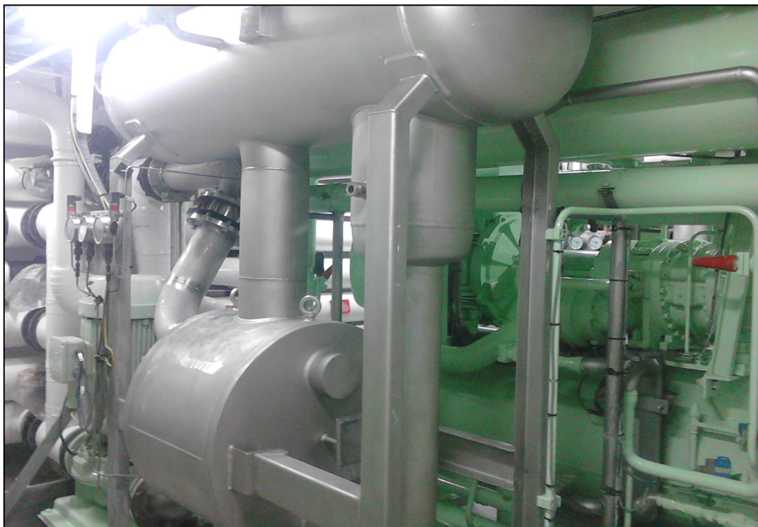
Figura 11. Separador de partículas / Intercambiador Amoniaco Cloruro Cálxico inundado
