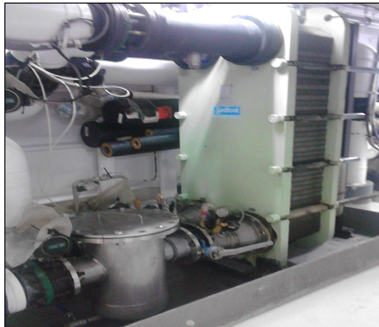
Figura 27. Armario de enfriamiento rápido / Intercambiador de Cloruro Cálxico y Salmuera. (Fuente: Empresa atunera: Pesquería Vasco Montañesa) [13]
