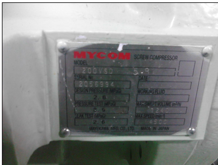
Figura 20. Placa de características del compresor. (Fuente: Empresa atunera: Pesquería Vasco Montañesa) [13]
