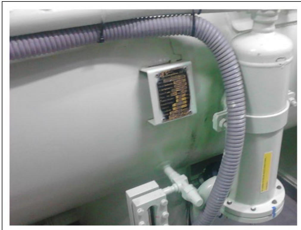
Figura 19. Visor, filtro y separador de aceite de lubricación. (Fuente: Empresa atunera: Pesquería Vasco Montañesa) [13]
