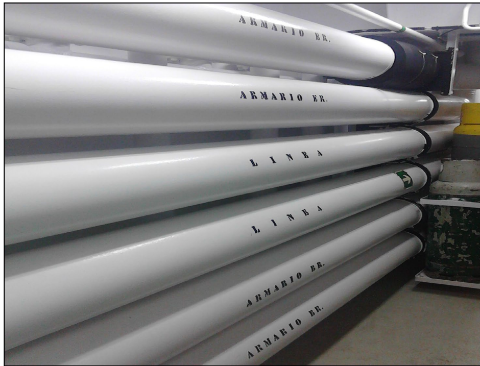
Figura 26. Líneas de distribución del Cloruro Cálxico. (Fuente: Empresa atunera: Pesquería Vasco Montañesa) [13]
