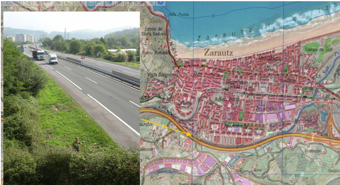
2.8. Irudia. 7. kokalekua. A-8 autopista, Zarautz.
