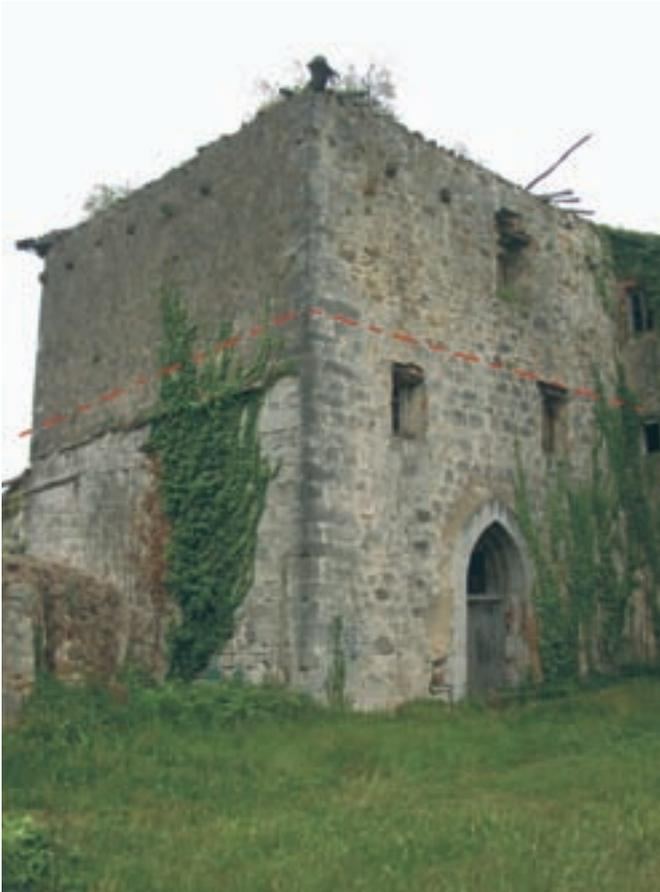
Torre de Madariaga (Busturia, Bizkaia). La línea roja discontinua marca el límite de los dos tipos de fábrica documentados: la parte de abajo corresponde a la fase más antigua del edificio y la superior a una posterior reconstrucción de la torre
