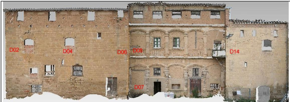
Fig. - 30 - Esquema de las dianas utilizadas en la tabla de diferencias entre la nube original y la nube coloreada. Los tres primeros puntos comenzando por la izquierda corresponden a un escaneo coloreado, los dos siguientes a otro, y el siguiente a otro.
