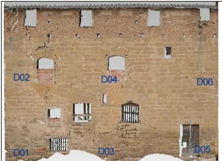
Fig. - 27 - Muestra de la distribución de las dianas en el escaneo más extremo, en el que el error es mayor por el encadenamiento.
