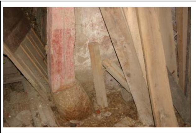
Fig. - 3 - Las vigas que sujetan la techumbre del primer se sustentan en precario equilibrio sobre sus apoyos.
