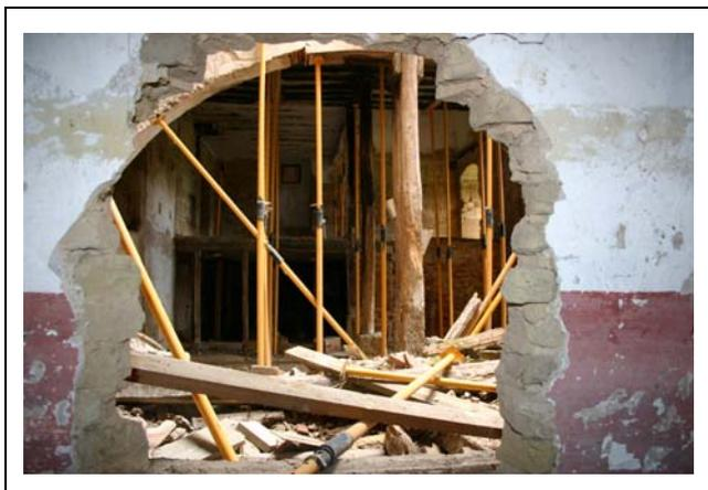
Fig. - 4 - En el piso inferior, los puntales que se habían colocado para sostener la estructura sirvieron de poco ante el avance de la ruina.
