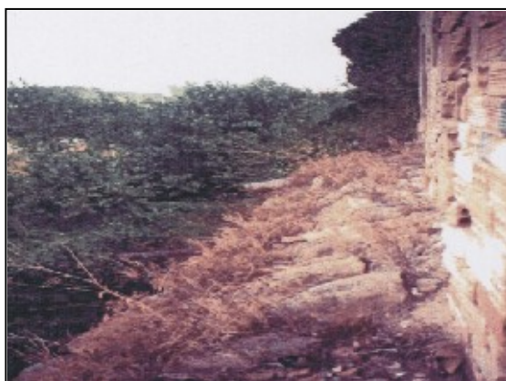
Img. 1.7. Espacio baldío entre la planta baja y la primera.
