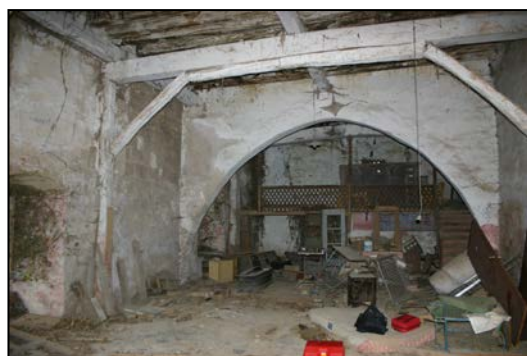
Img. 1.11. Interior de la planta baja
