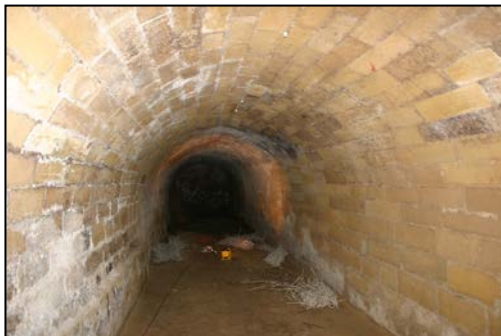
Img. 1.9. Calado Oeste del semisótano
