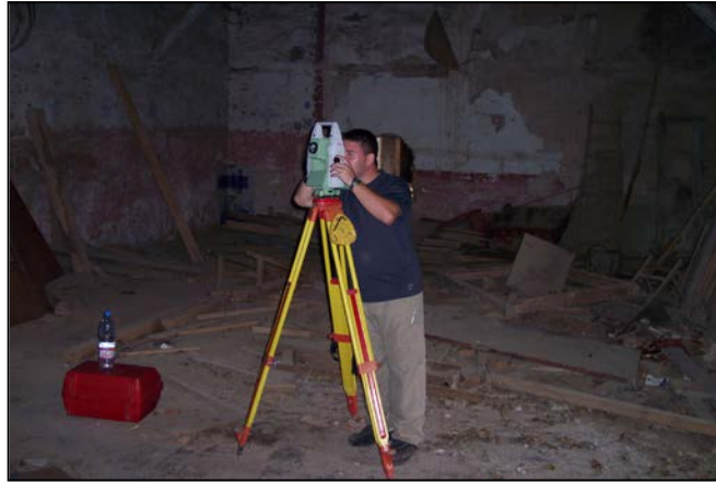
Img. 3.2. Medición de la geometría del interior del Palacio por topografía.
