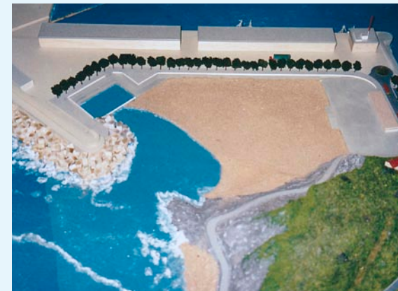
Rodeada de paredes, esta playa artificial resulta atípica al carecer de horizonte marino. Tampoco parece adecuada su ubicación al lado de la carretera (para carga y descarga) y en una zona de almacenamiento de un producto perecedero como el pescado.
