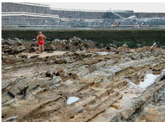
Dique con estación undimotriz incorporado, construido sobre flysch negro. Mutriku, 2011.
