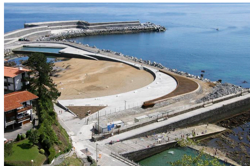
Después, verano 2012. Hay que señalar que la no ejecución del nuevo puerto exterior y sus edificios y servicios, previstos en el «Plan Especial», ha supuesto una importante liberación espacial para el recinto playero al abrirse al mar por su parte Este.
