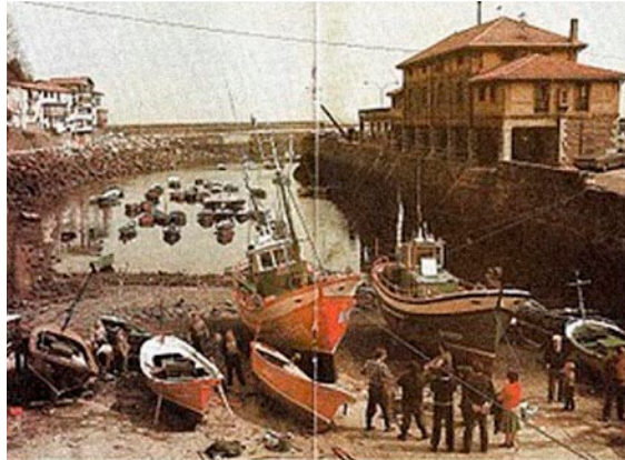
Rampa de Intxirri en uso de trabajo.
