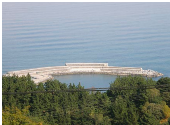
Frente costero de Mutriku, con el dique inconcluso de 300 m. de largo, al que se pretende añadir otros 150m. agosto 2013.
