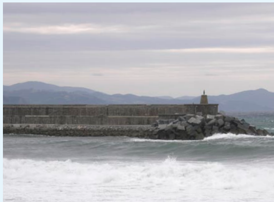
Dique de Zumaia, de parecida altura al que se construirá en Mutriku.
