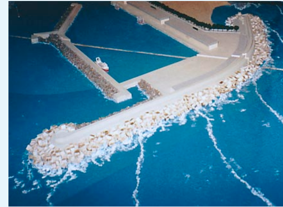
Incluso en la maqueta del proyecto la orientación del dique resulta dudosa, ya que el dique no se enfrenta al sentido del oleaje.
