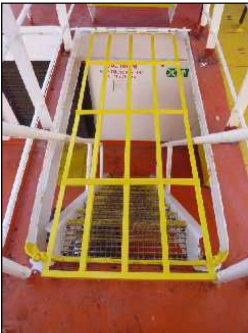
Figura 23. Enrejado de la escalera exterior
