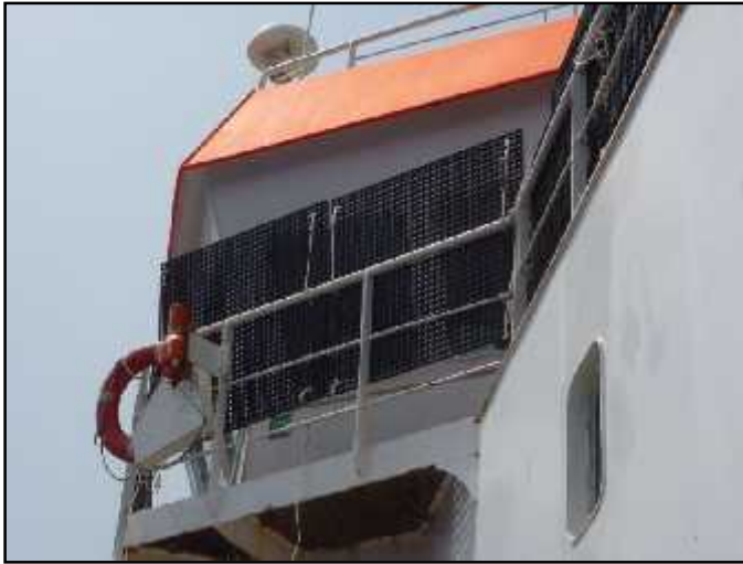
Figura 18. Protección del puente del Mar María.
