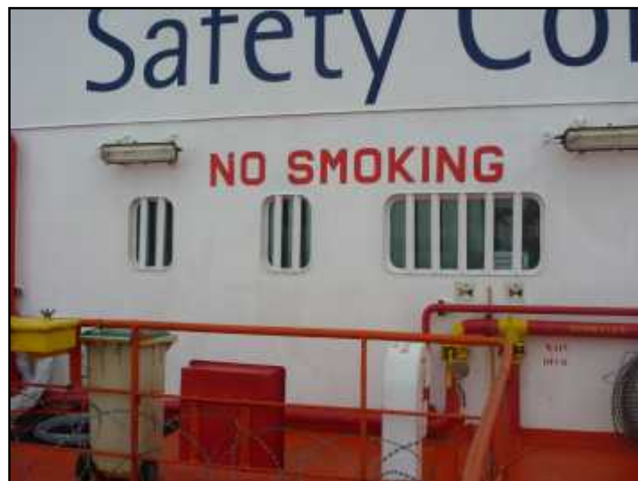
Figura 21. Portillos de la cubierta principal enrejados por angulares
