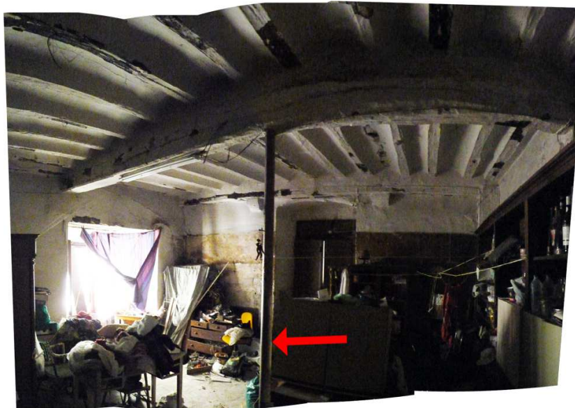
Figura 76. Apuntalamiento de una de las vigas, en la antigua tienda
