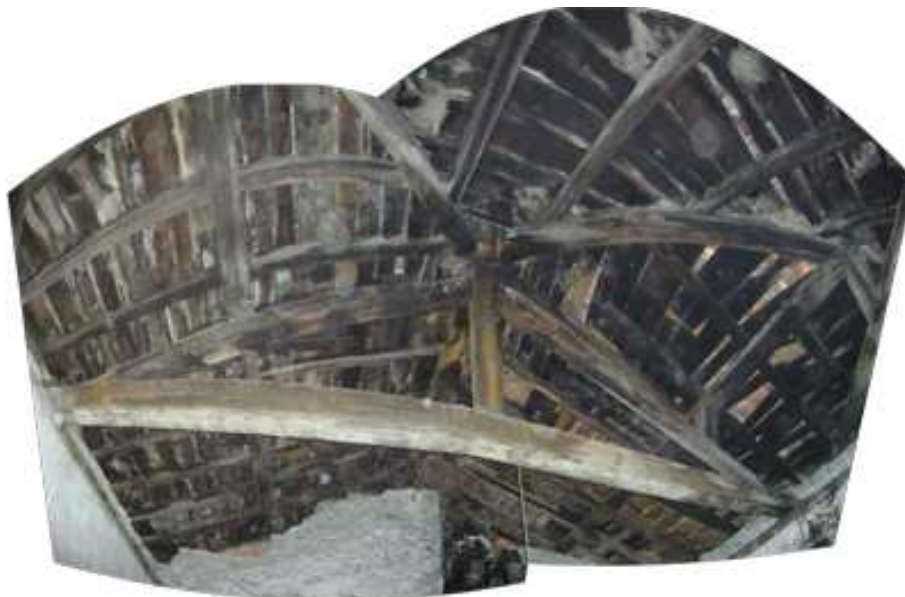
Figura 21. Cubierta de la parte septentrional
