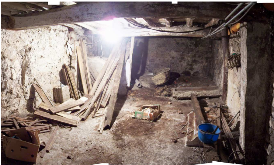
Figura 18. Sótano de la parte septentrional, forjado de dos órdenes
