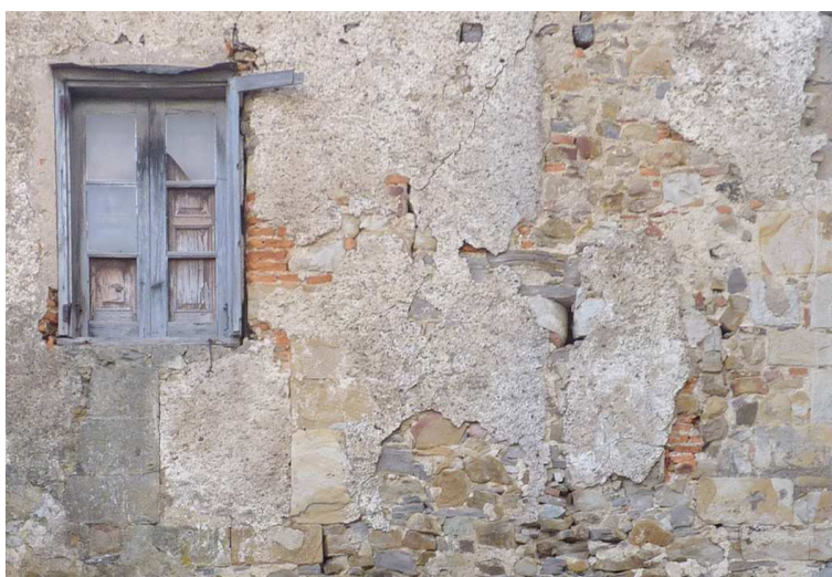
Figura 54. Fachada posterior de la parte meridional
