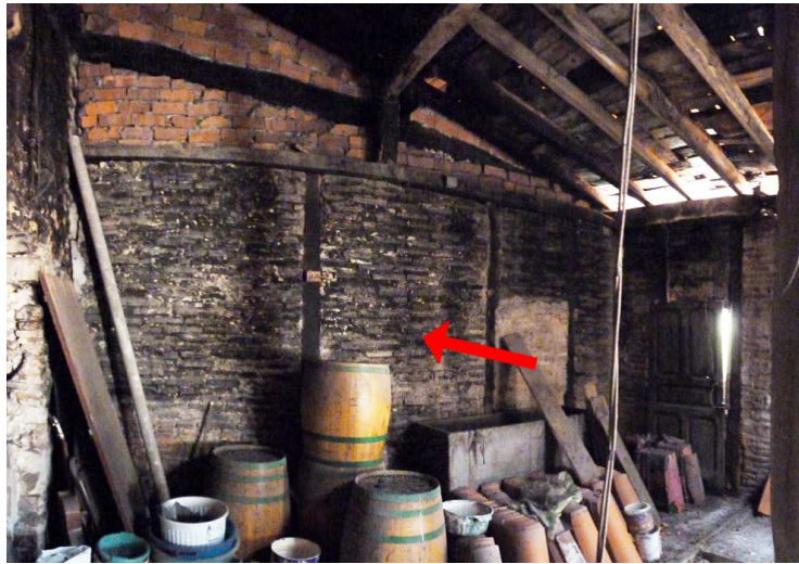
Figura 55. Tabique macizo separa la habitación de solana y la "ganbara"
