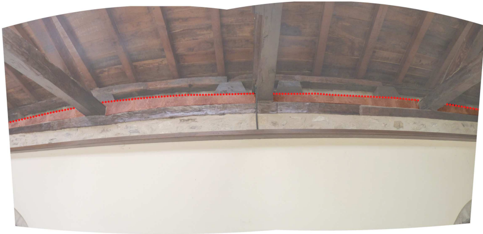
Figura 31. Antigua canalización de aguas de cubierta, Palacio Guevara
