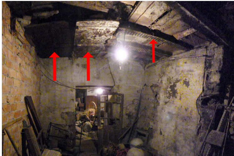
Figura 74. Forjado de los aseos, visto desde el almacén
