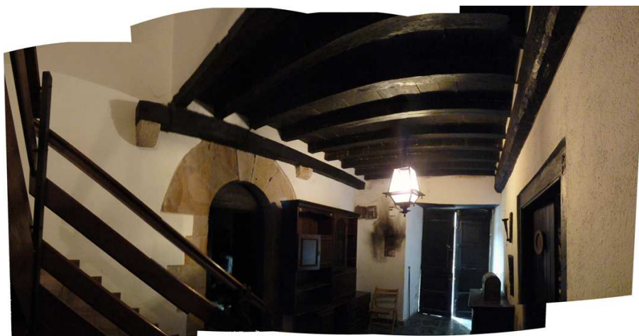
Figura 13. Entrada de la parte septentrional, forjado de dos órdenes
