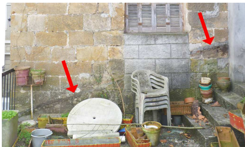
Figura 46. Marcas de la antigua cubierta inclinada del edificio anexo
