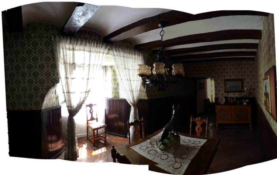
Figura 12. Comedor de la parte septentrional, forjado de un orden
