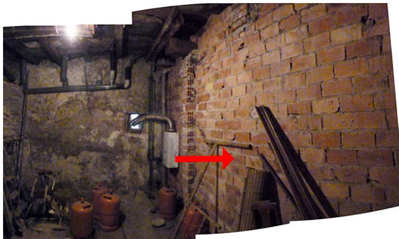
Figura 56. Tabique de ladrillo hueco doble, en el almacén
