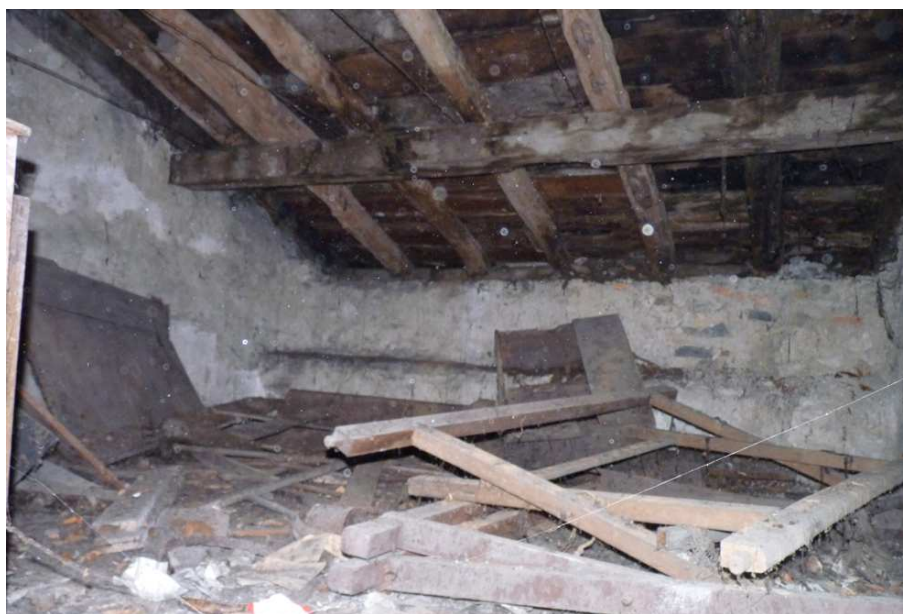
Figura 19. Cubierta de la parte meridional
