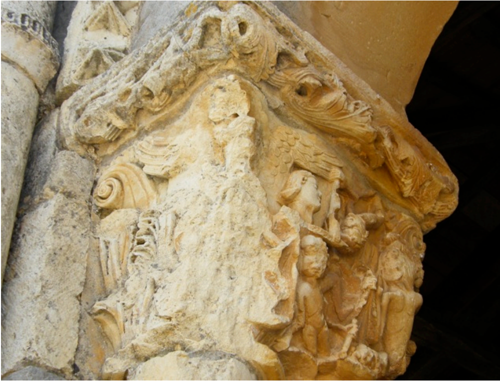
Imagen II-14: san Miguel representado en el capitel adosado a un pilar de la galería de San Julián y Santa Basilia de Rebolledo de la Torre (Burgos)
