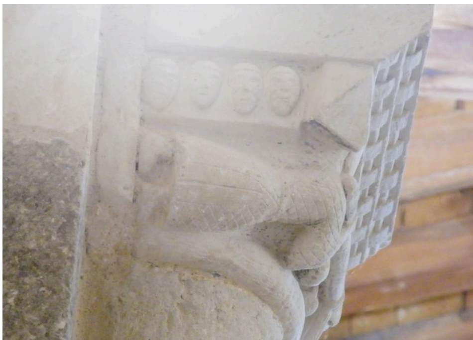
Imagen II-2: imagen de san Miguel y los elegidos en el capitel derecho de la Asunción de Nuestra Señora de Villahernando (Burgos)
