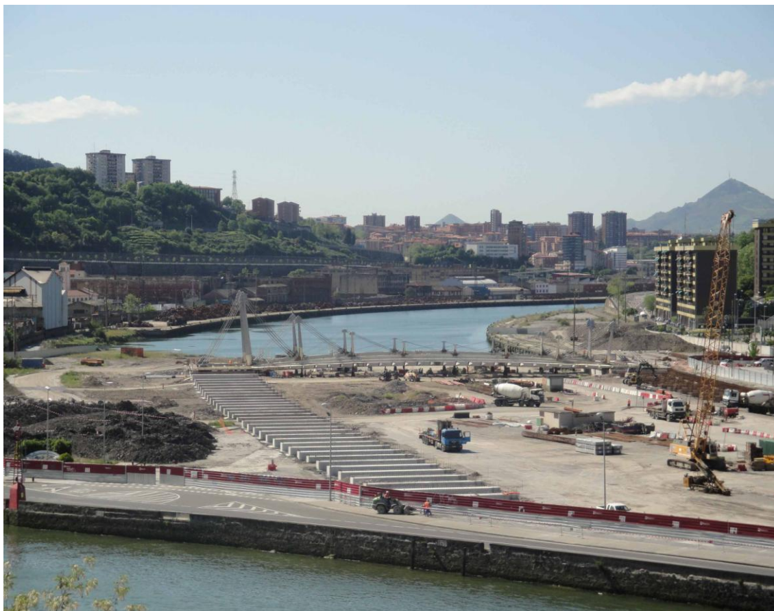
24 Obras de apertura del Canal de Deusto
