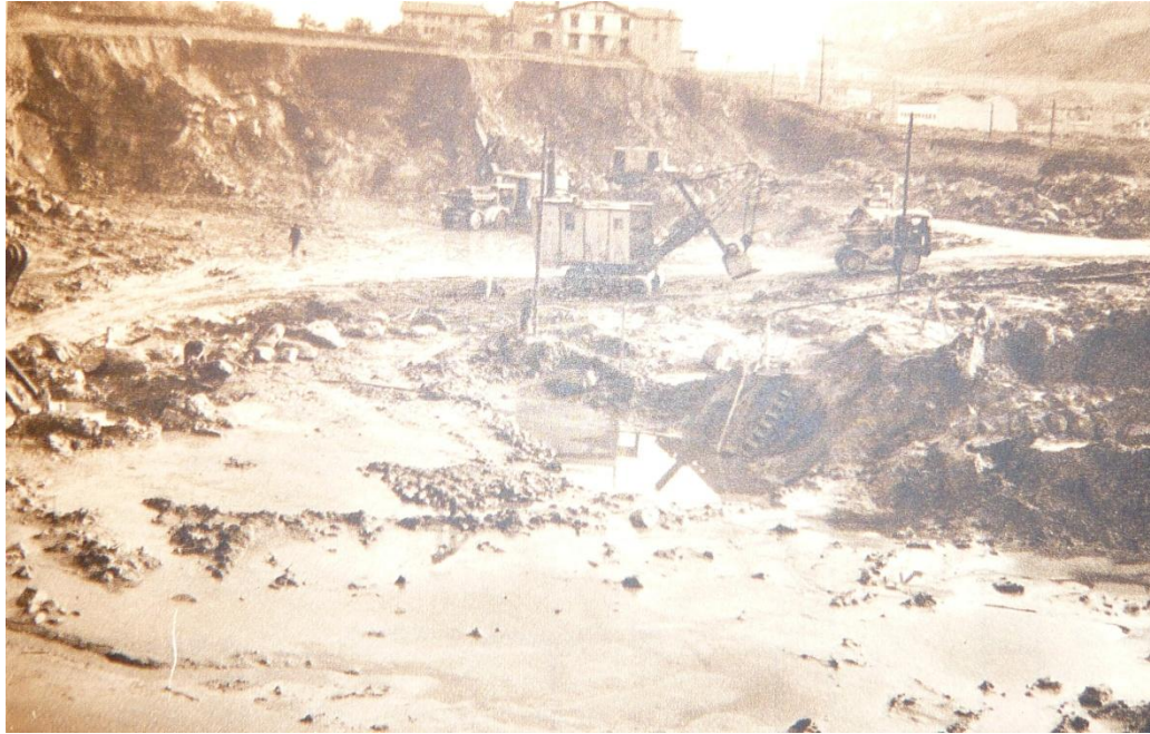
Excavaciones del 2º Trozo del Canal
