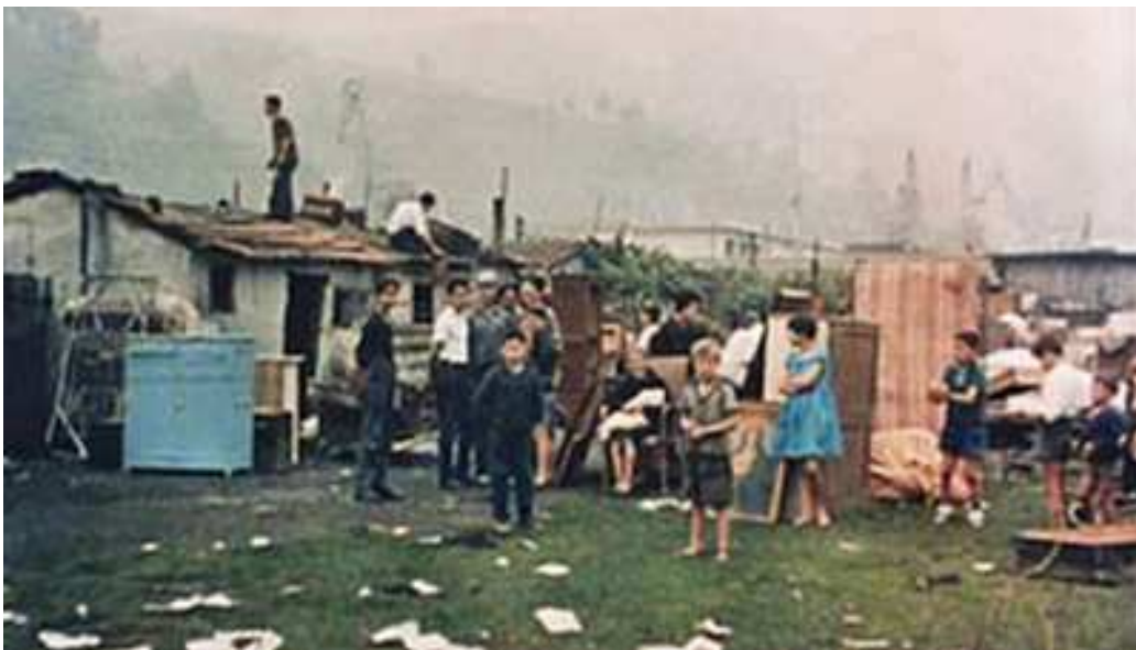
Desmantelamiento de poblado chabolista del Monte Banderas para su reubicación en Ocharcoaga
