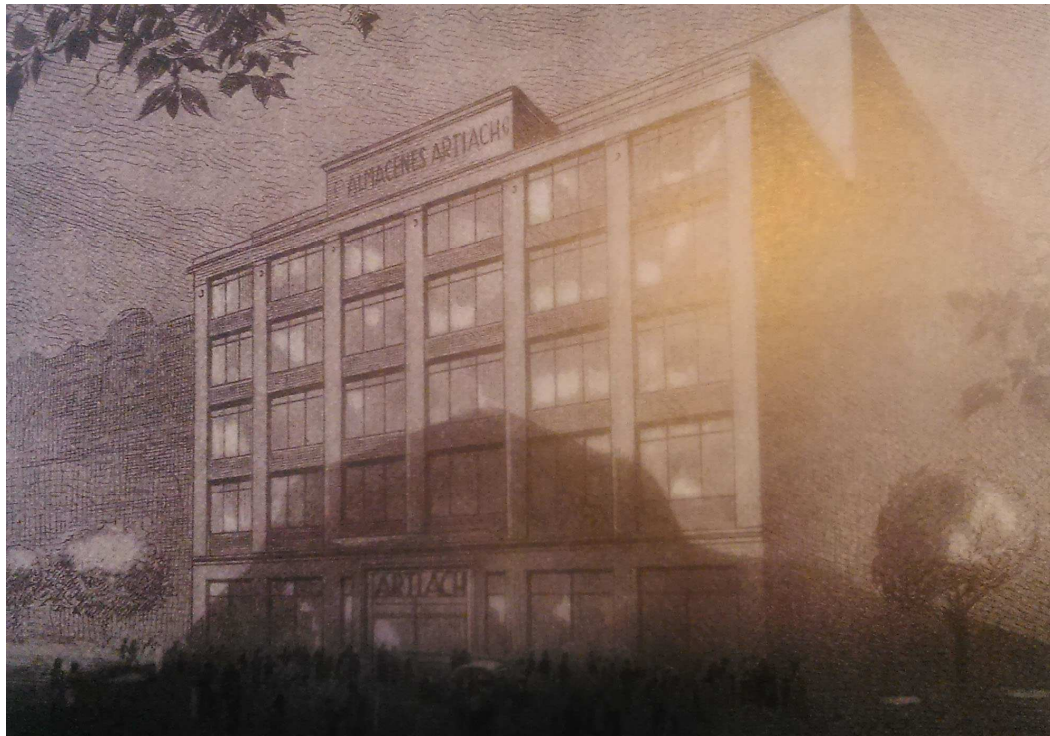
Ampliación de los almacenes de Artiach en Deusto
