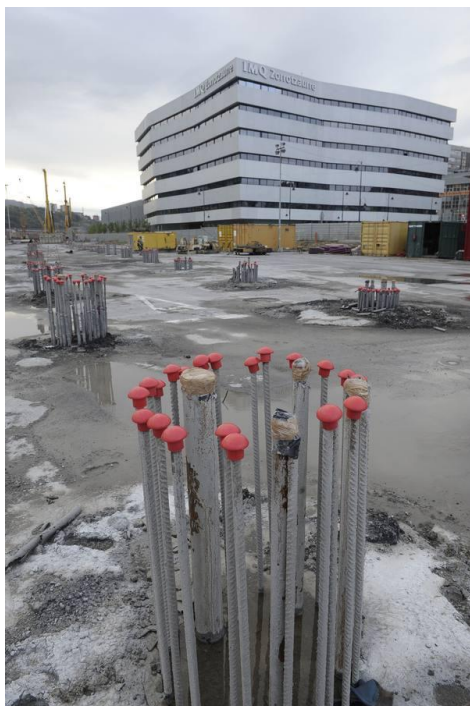
Obras del Canal
