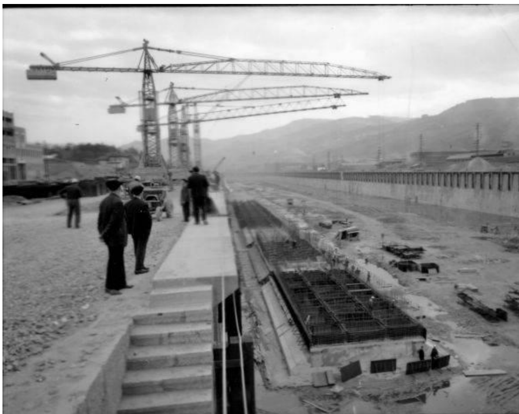
Construcción de cajones de cimentación para la obra exterior del Puerto en el Canal de Deusto. Memoria Anual 1966
