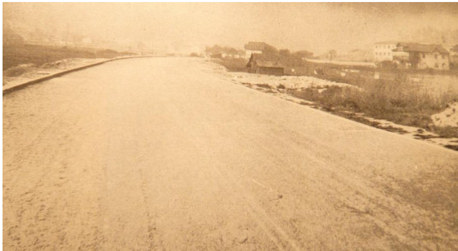
Camino en la margen derecha del Canal de Deusto entre las calles Q y P
