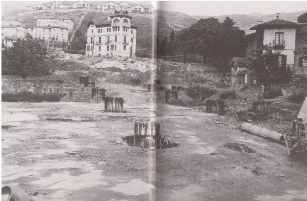
Construcción del Puente del Generalísimo (Puente de Deusto) 1933
