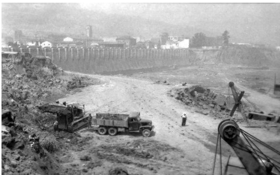
Excavaciones del Canal de Deusto. Obra del 1er Trozo.
