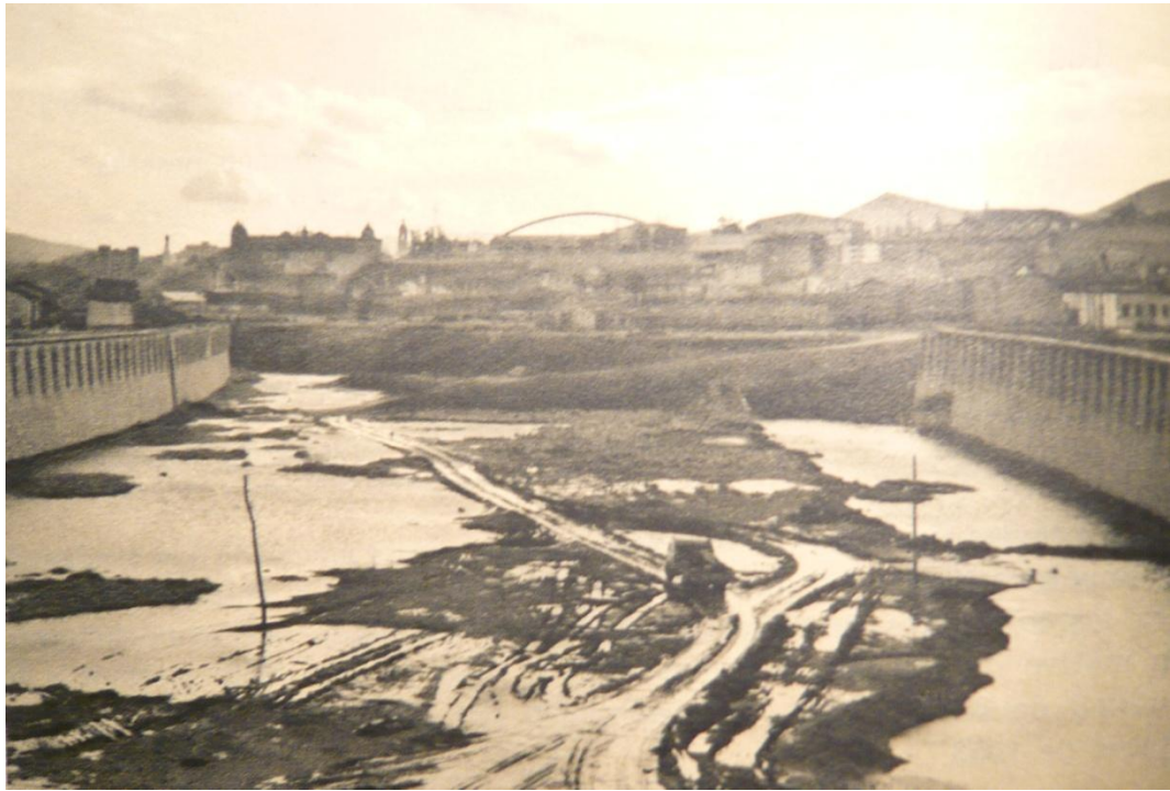
Vista del Primer tramo. Memoria Anual 1957
