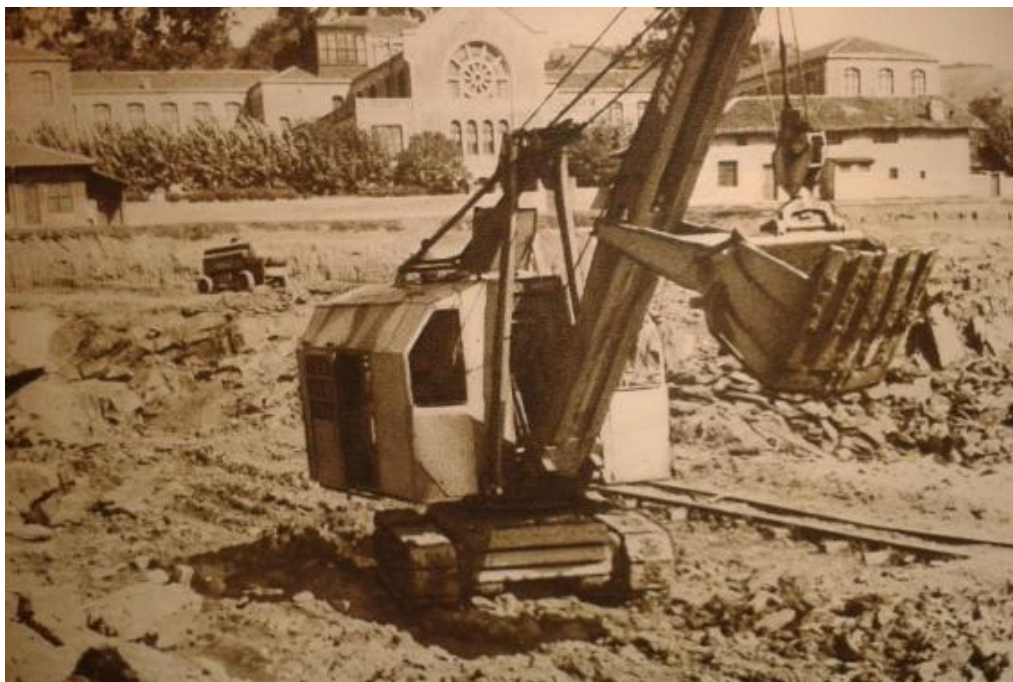
Maquinaria para excavación en roca
