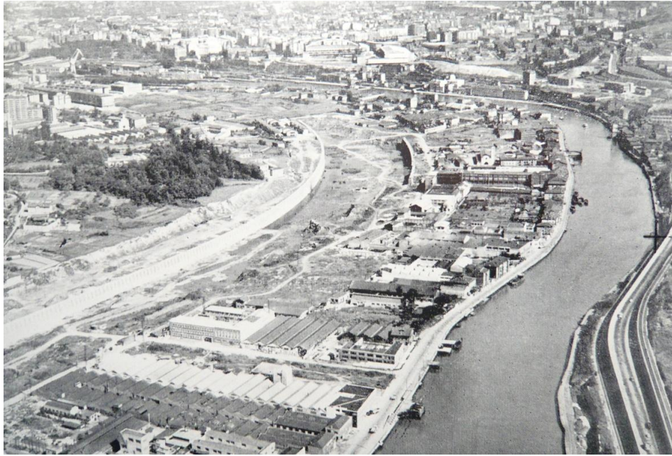
Vuelta de Olaveaga y obras del Canal. Memoria Anual 1963
