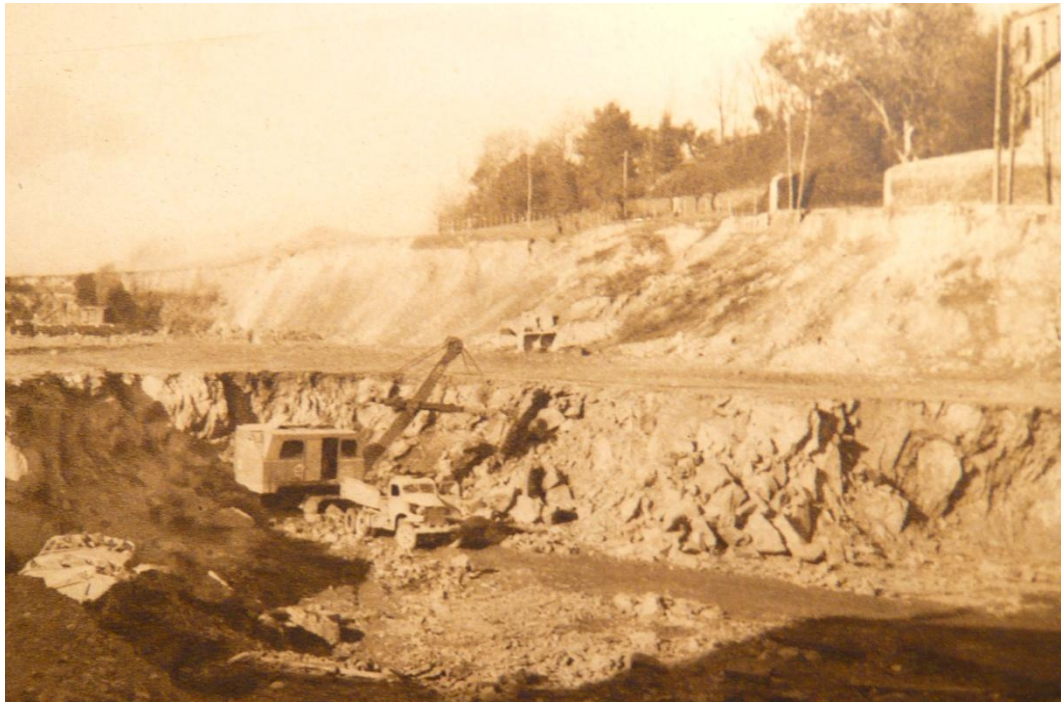
Canal de Deusto. Obra del 1er Trozo.
