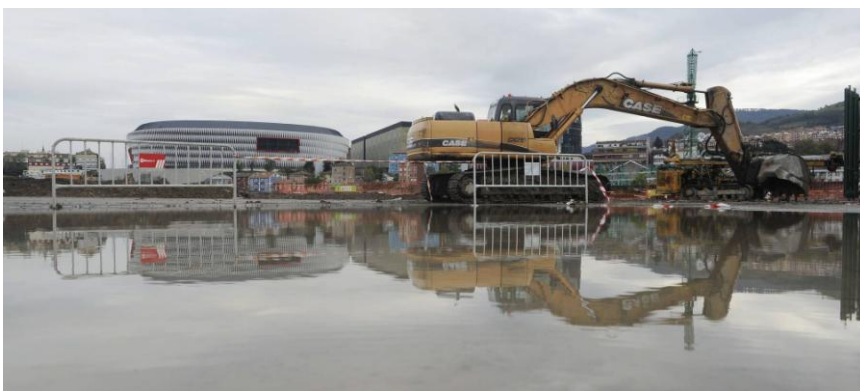
Obras del Canal
