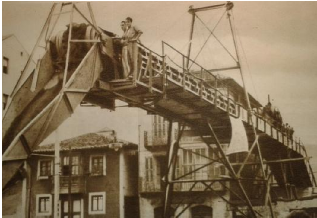
La cinta transportadora sobre la carretera de Bilbao a Las Arenas
