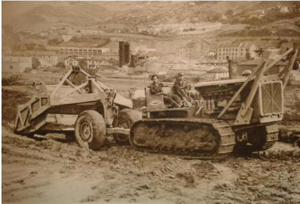
Maquinaria para excavación en tierra
