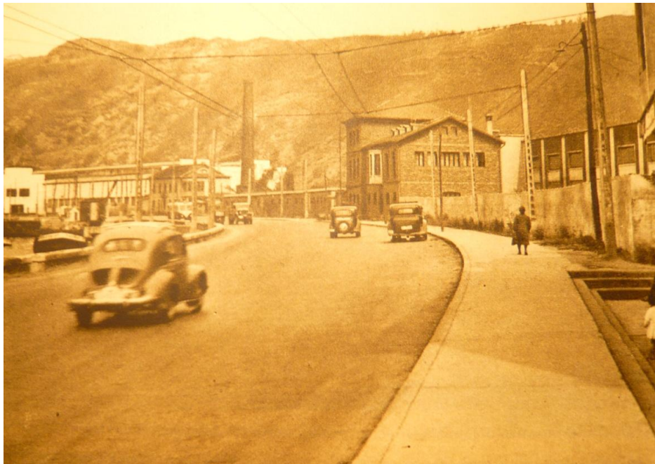
Obra de ensanche de la carretera de Las Arenas junto a la Avenida del Ejército en Deusto. Memoria Anual 1955-1956
