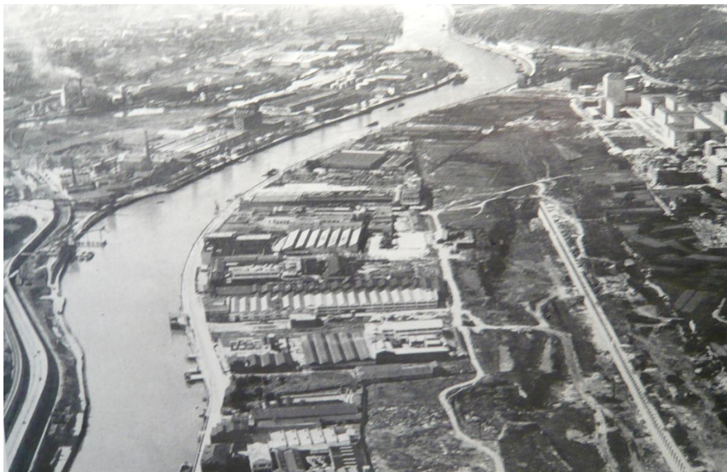
Excavaciones del 2º Trozo del Canal
