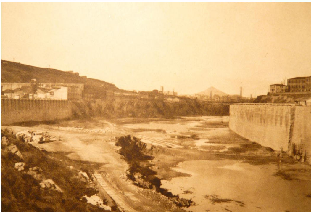
Vista del Primer tramo. Memoria Anual 1957
