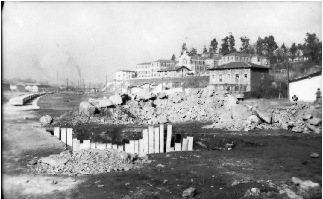
Excavaciones del Canal de Deusto. Obra del 1er Trozo.
