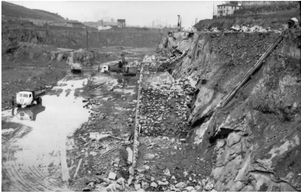
Excavaciones del 2º Trozo del Canal
