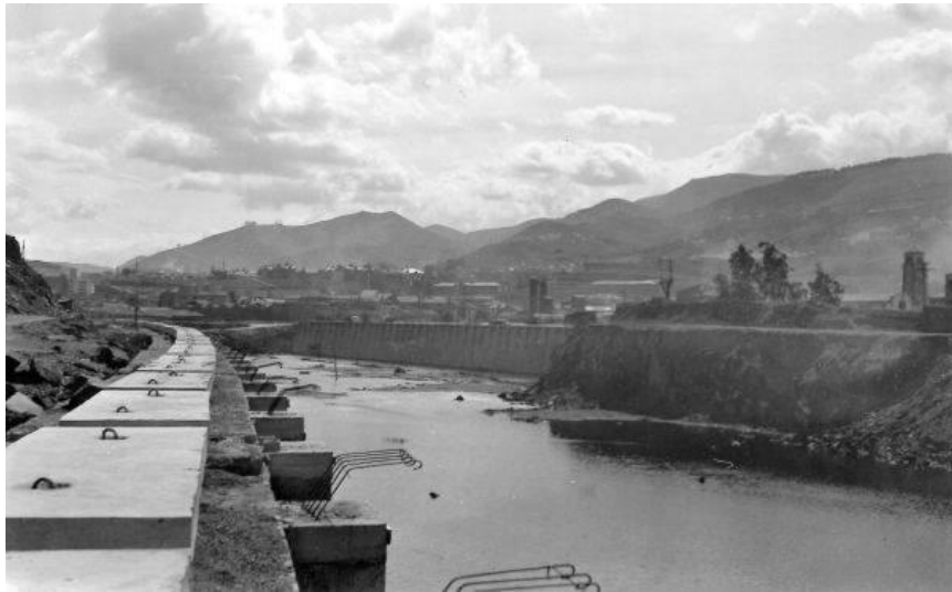
Obra del Canal.
