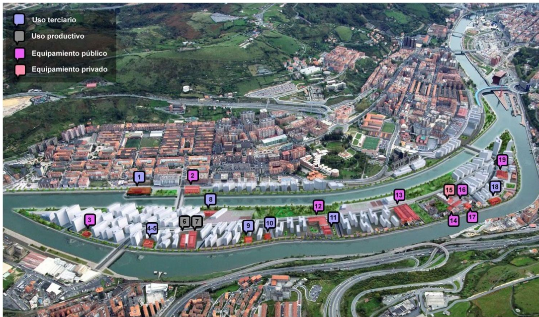
Los 19 edificios industriales de Zorrotzaurre que se conservan 131
