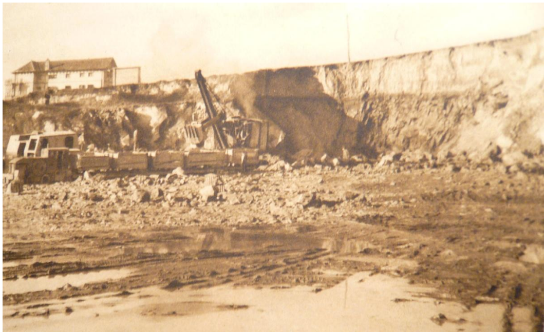
Canal de Deusto. Obra del 1er Trozo.
