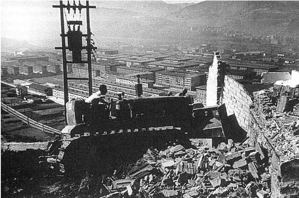
Derribo de chabolas en el Monte Banderas. 1961
