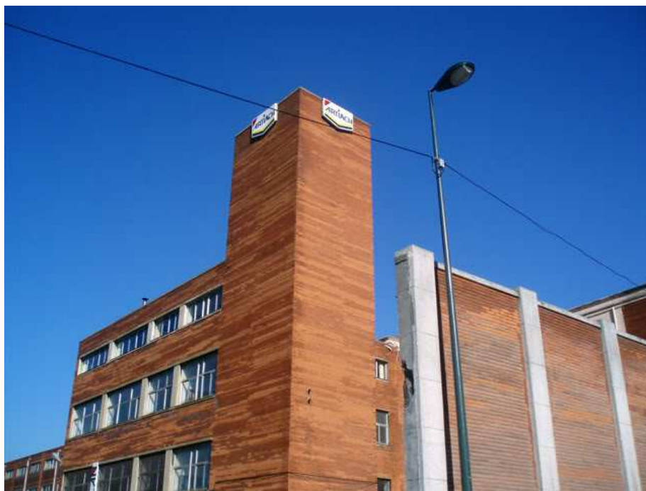
Edificio Artiach abandonado en Zorrozaurre
