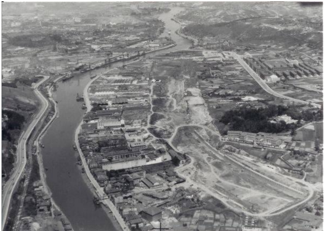
Imagen aérea de 1959 con el perfil del futuro canal y los caminos habilitados para sacar la tierra extraída con camiones
