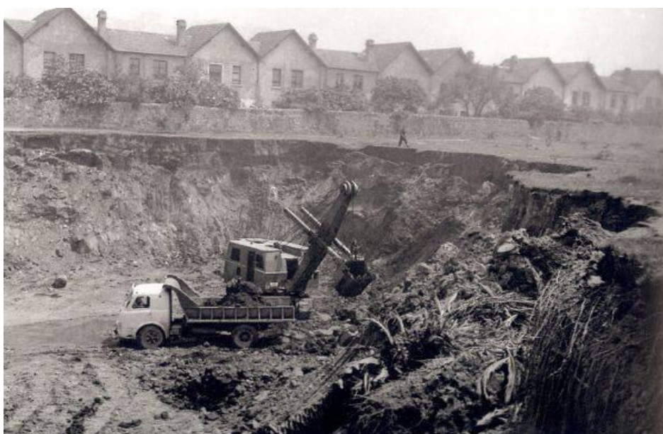
Excavaciones del Canal de Deusto. Obra del 1er Trozo.
