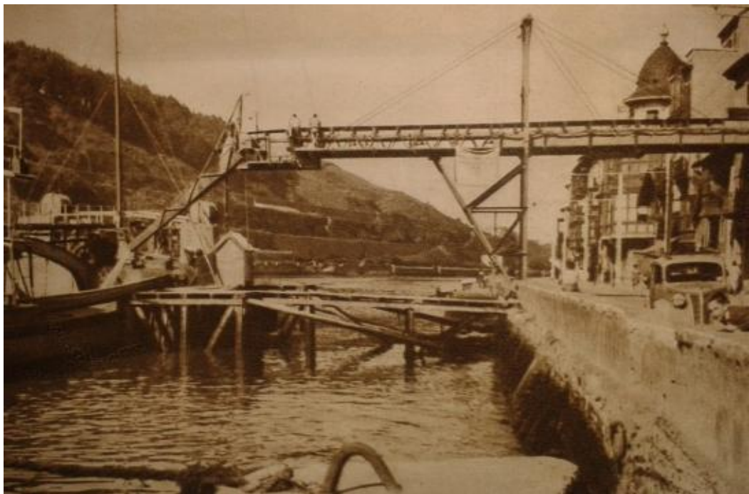
Gánguil para el vertido al mar de los productos de excavación.
