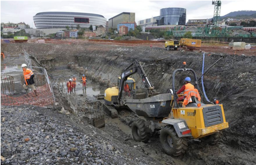
Obras de apertura del Canal de Deusto
