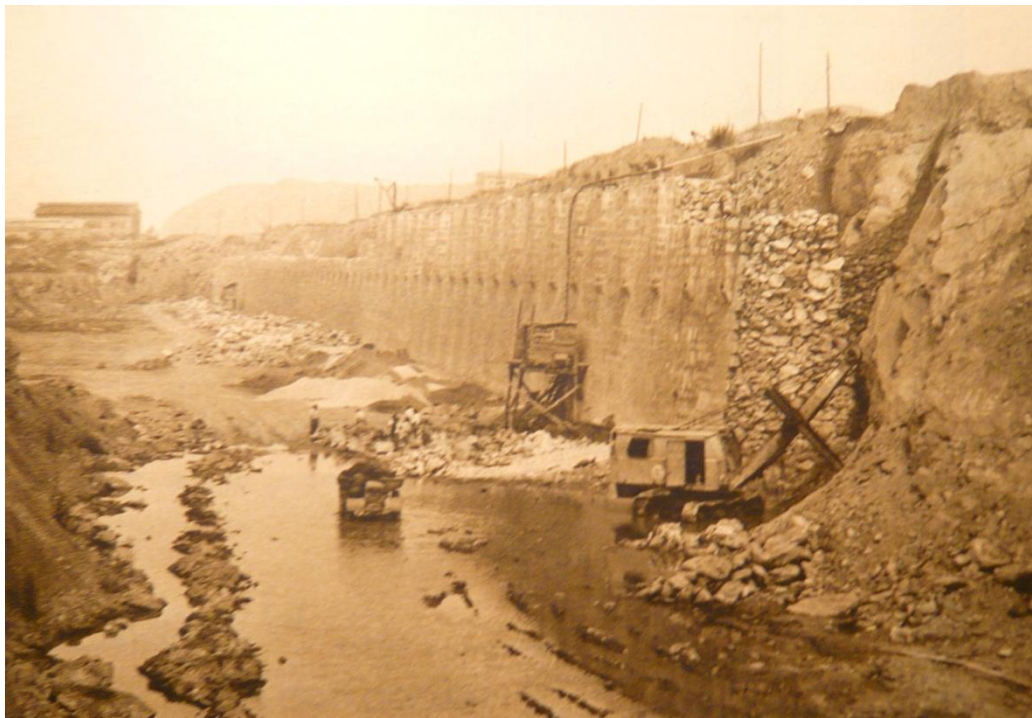
Excavaciones del 2º Trozo del Canal
