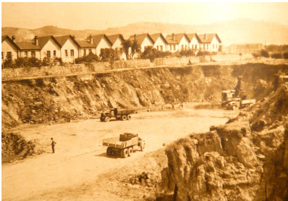
Excavaciones del Canal de Deusto. Obra del 1er Trozo.
