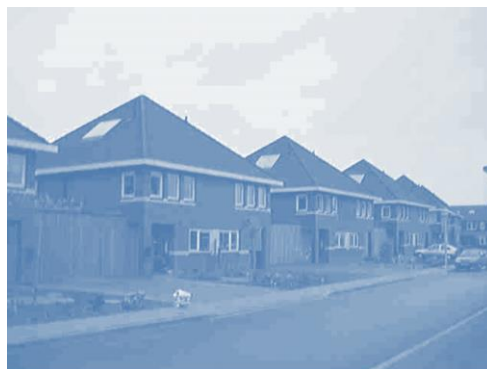
Ilustración 8: viviendas adosadas ecológicas “Amboise” [2]
