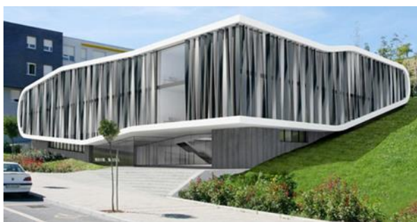
Ilustración 10: vista desde la Avenida Campazar de los accesos del edificio.
