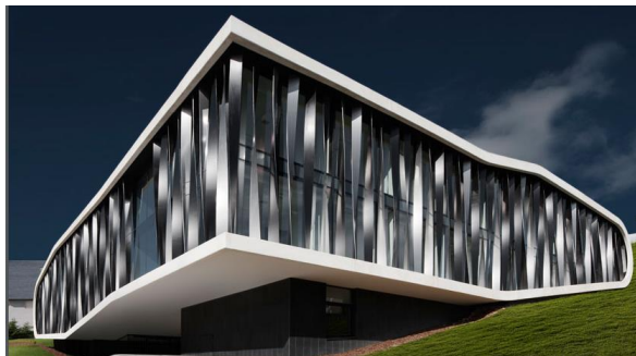
Ilustración 9: vista de las fachadas acristaladas y las lamas metálicas del edificio.
