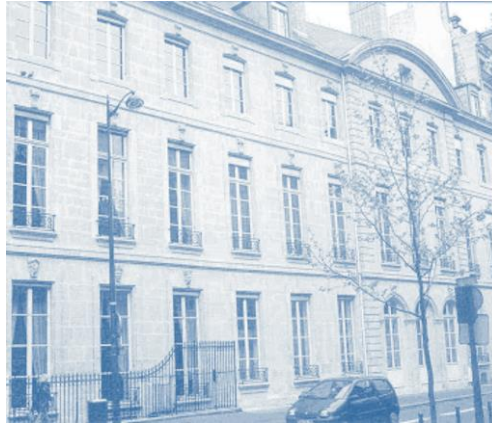
Ilustración 6: fachada del Hotel de Croy [2]
