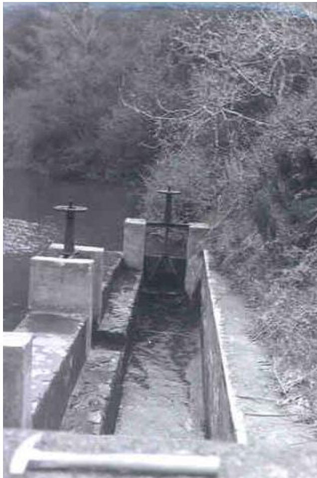
Ilustración 26: Sistema de evacuación de la presa de Zollo
