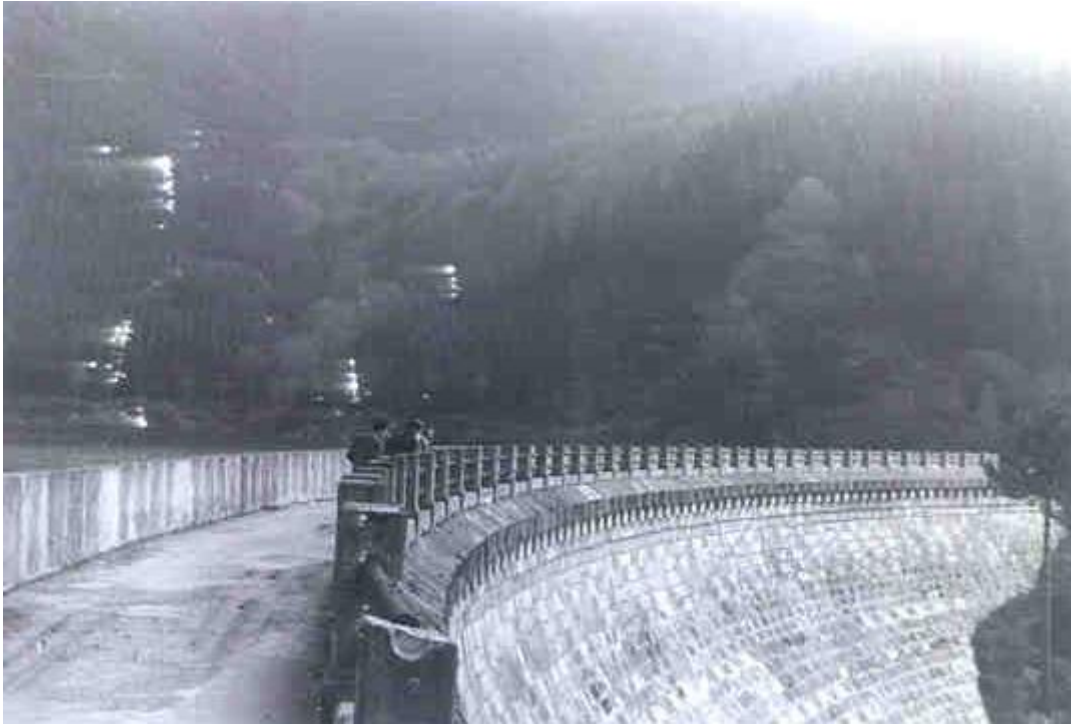
Ilustración 25: Presa de Zollo
