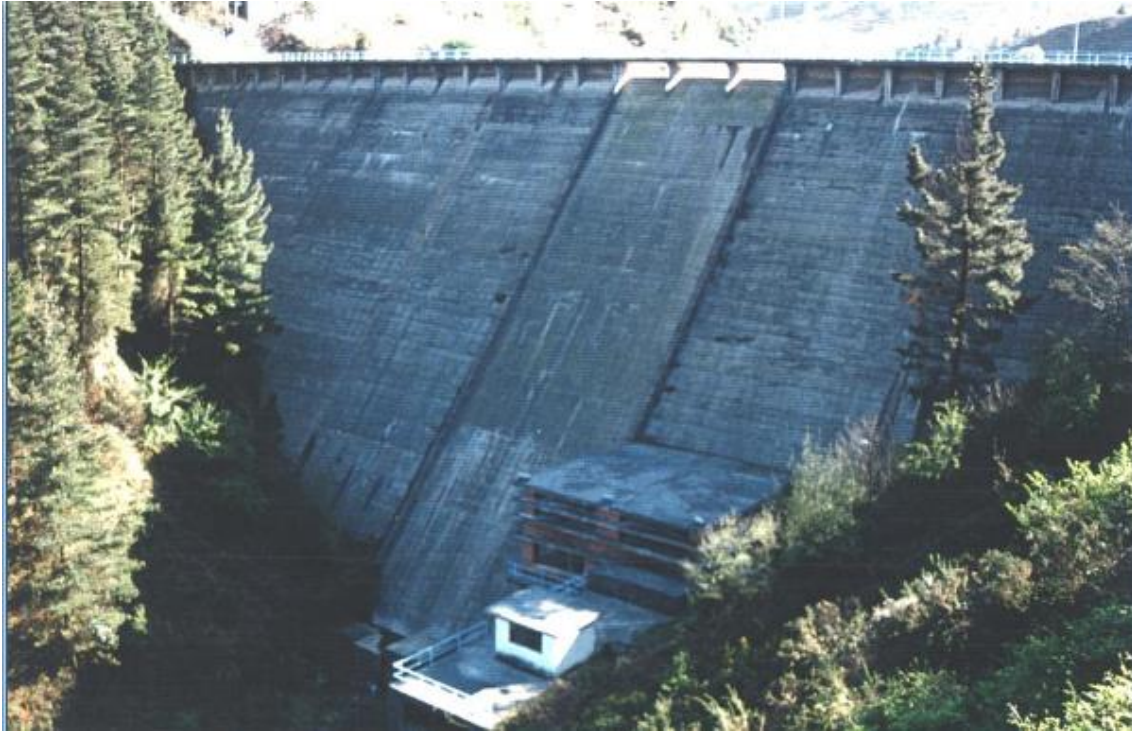
Ilustración 14: Presa de Artiba
