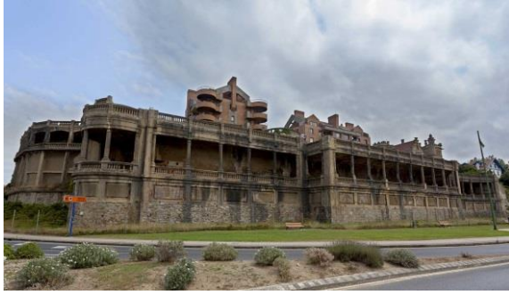
Figura 14. Galerías de Punta Begoña
