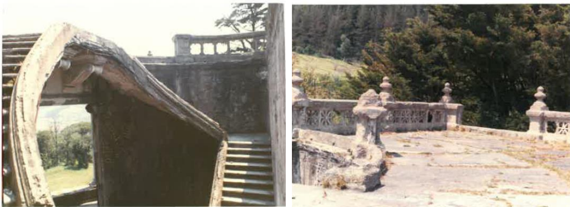
Figura 61. Vista de las escaleras y cubierta
