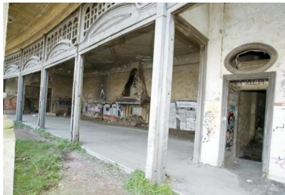
Figura 41. Tramo 3 de la galería
