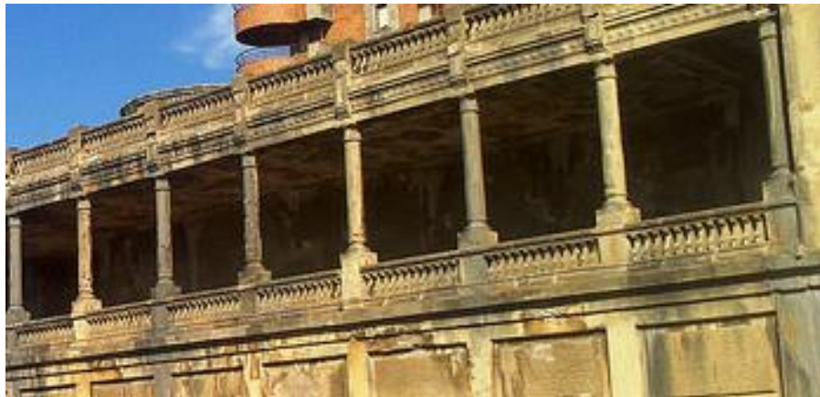
Figura 37. Detalle de la fachada suroeste
