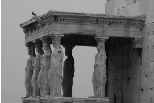
Figura 3. Pórtico del templo griego del Erecteión (Acrópolis de Atenas)
