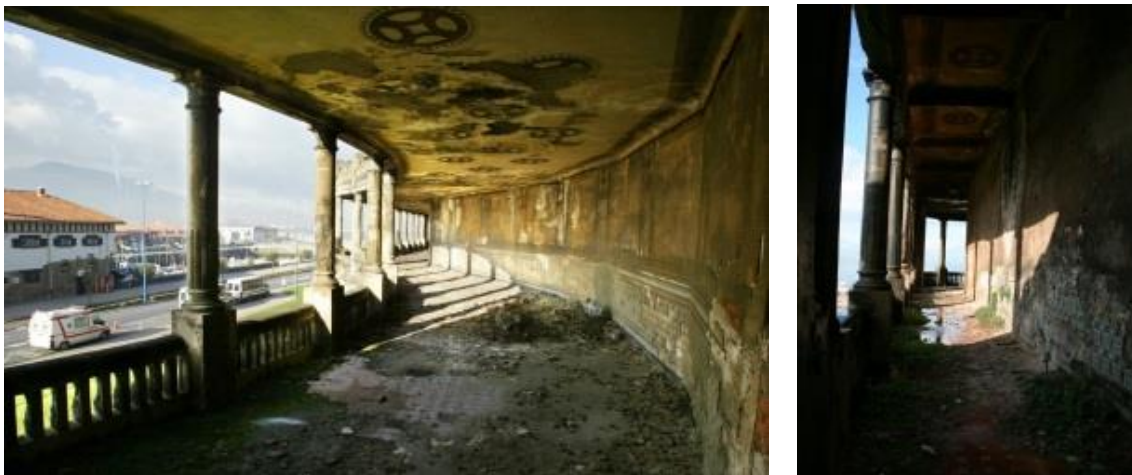
Figura 38. Pasillo suroeste, tramo 1 de la galería
