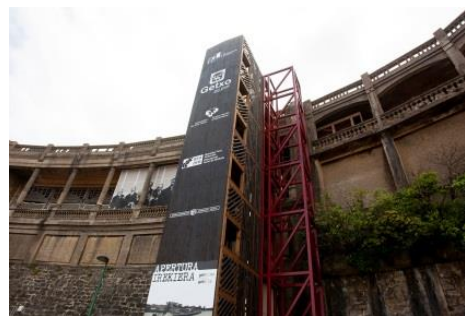
Figura 42. Escalera montada para la rehabilitación de las galerías
