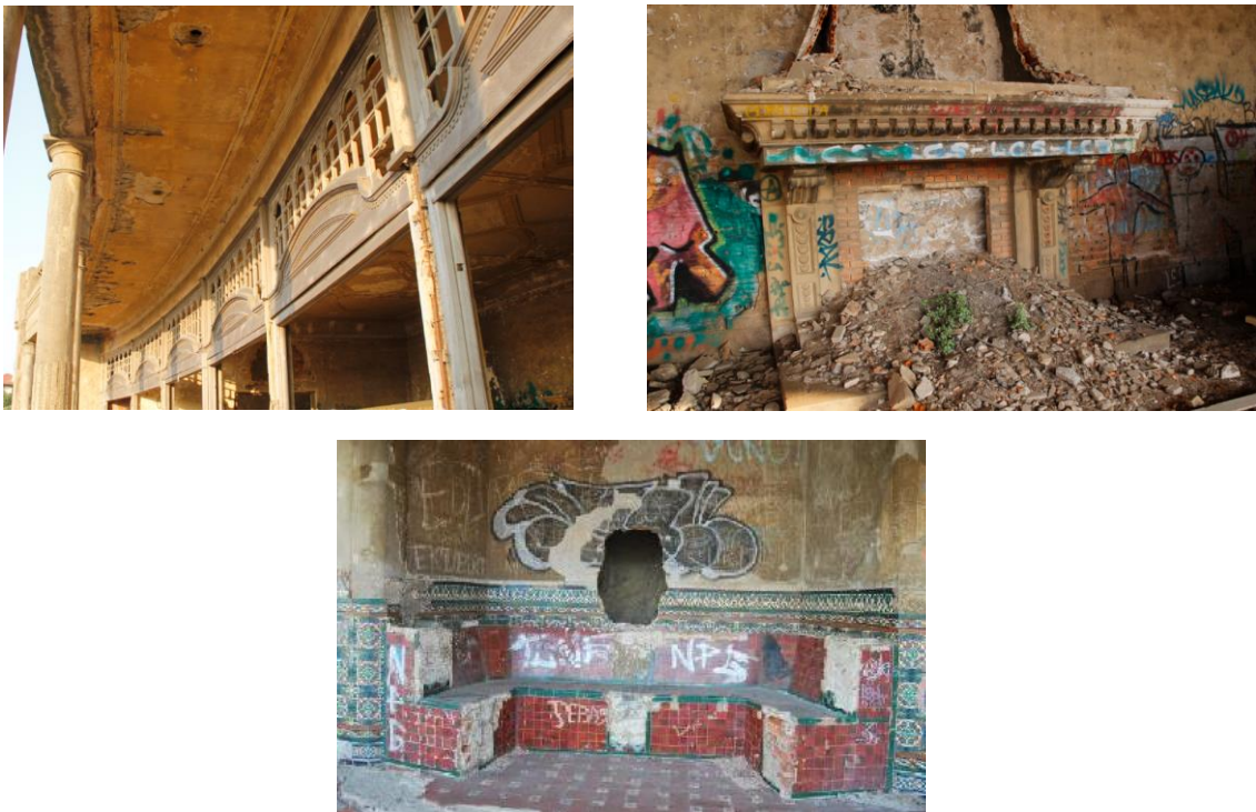
Figura 46. Estado actual de la carpintería, la chimenea y un banco exterior
