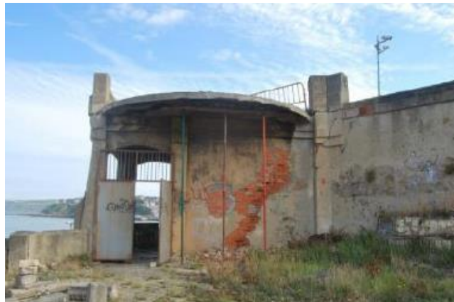
Figura 44. Estado actual de las cubiertas
