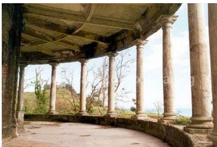
Figura 64. Galería del Torreón de Vista Alegre
