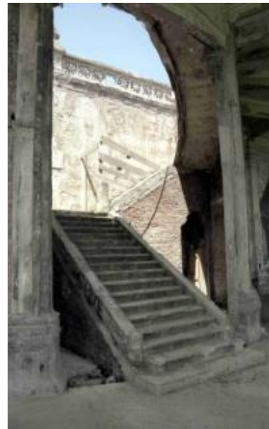
Figura 70. Escalera de la planta baja
