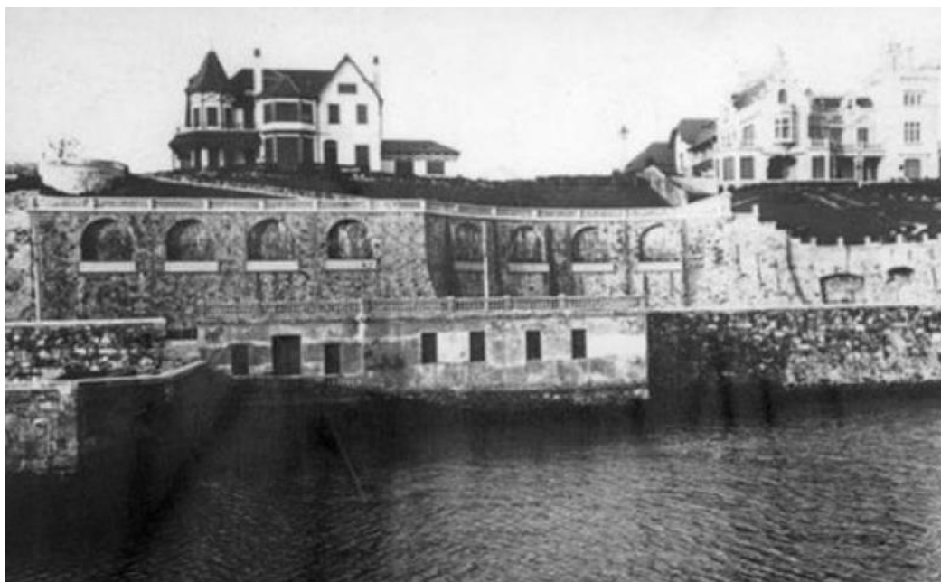
Figura 26. Muro existente previo a las galerías.
