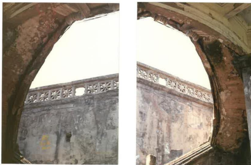
Figura 65. Espacio de la rampa de la escalera
