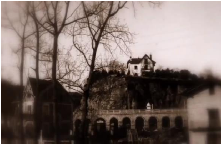
Figura 85. Arkaitz Artekooa antes de la construcción de la galería
