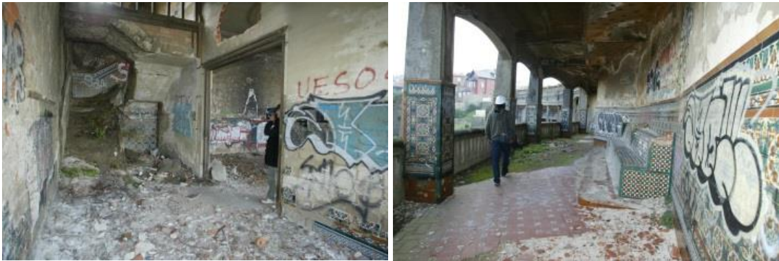
Figura 39. Tramo 2 de la galería
