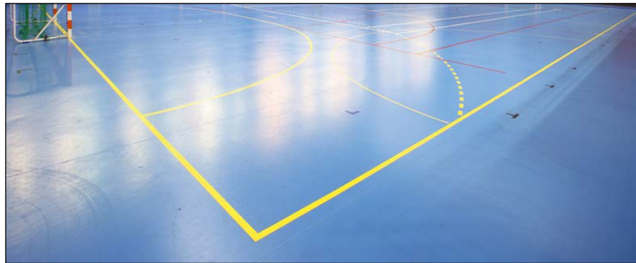
Figura 34. Pintura de las líneas sobre el pavimento.
