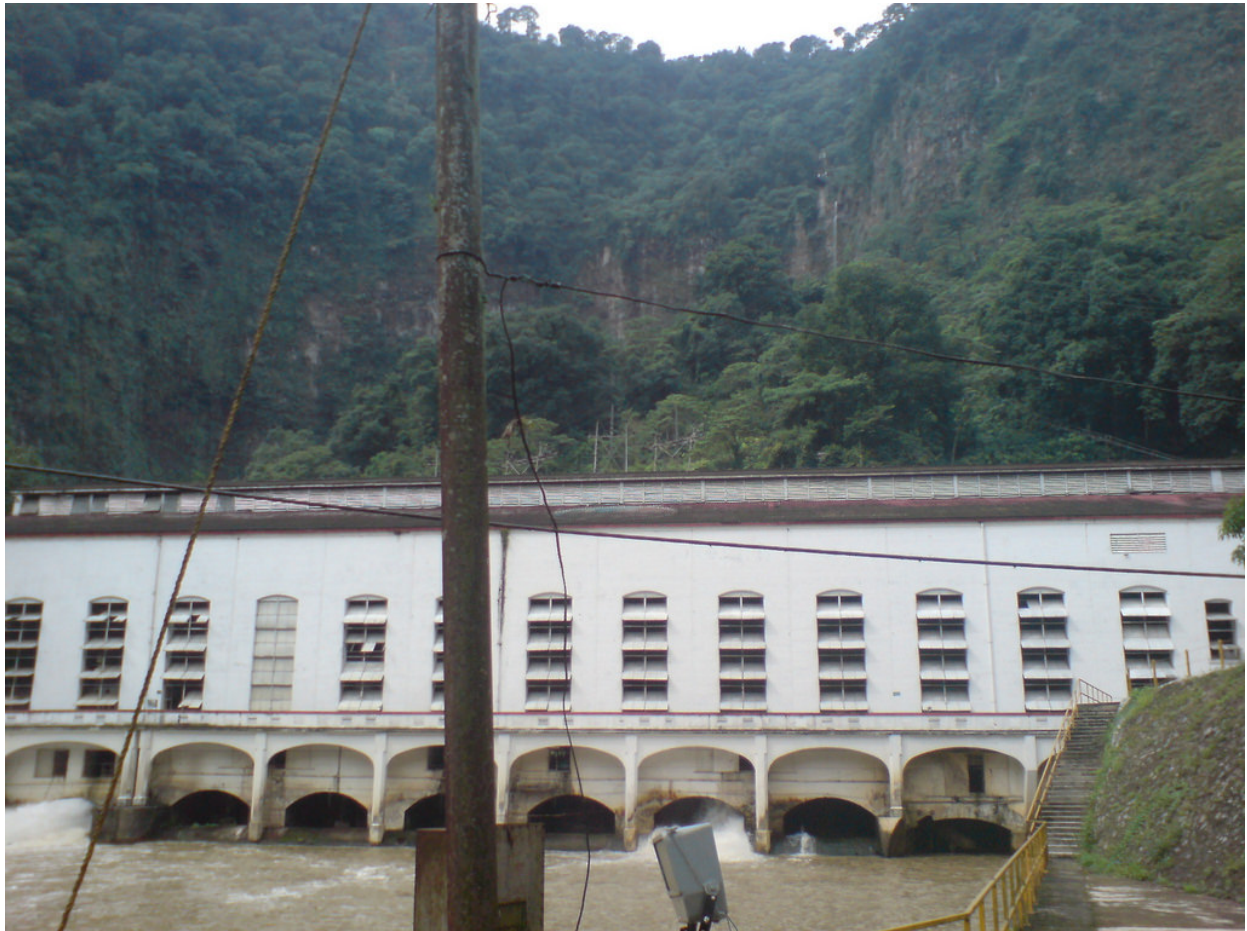
Salida de las tuberías de desfogue de la Casa de máquinas de Necaxa
