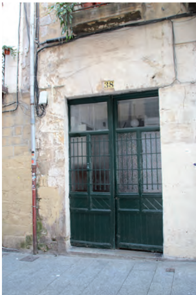
FIGURA A10. 33. PUERTA DE ACCESO A PORTAL
