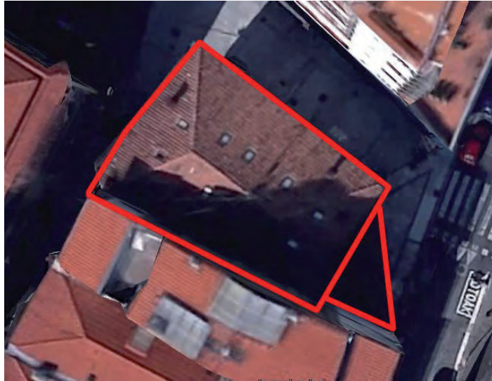
FIGURA A17. 19. CUBIERTA DE ANDRE KALE Nº 46. FOTO AÉREA 5
