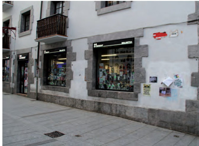
FIGURA A5. 35. FACHADA LATERAL
