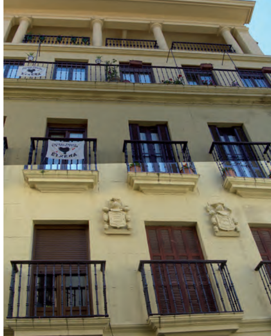
FIGURA A20. 4. FACHADA PRINCIPAL
