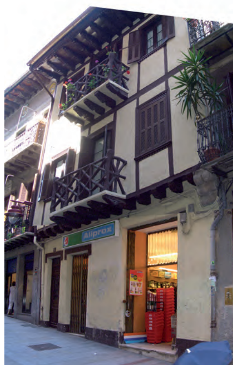
FIGURA A8. 3. FACHADA PRINCIPAL
