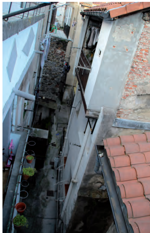
FIGURA A10. 6. FACHADA TRASERA Y CARCAVA
