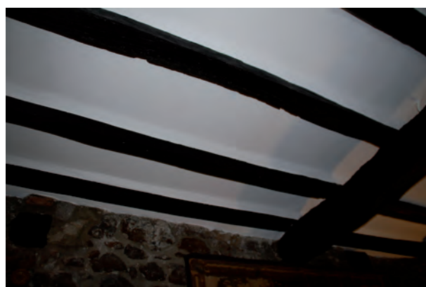
FIGURA A4. 22. FORJADO CON ENTREVIGADO CERÁMICO
