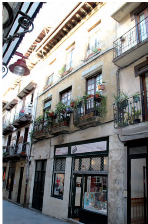
FIGURA A10. 4. FACHADA PRINCIPAL
