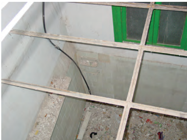
FIGURA A20. 49. ANTIGUO ASEO UBICADO DEBAJO DE PATIO
