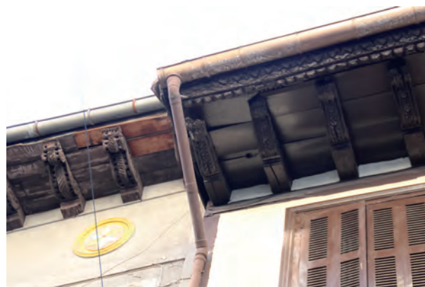
FIGURA A8. 36. CONDUCCIONES DE PLUVIALES EN FACHADA TRASERA
