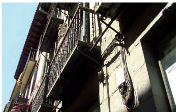
FIGURA A12. 26. FACHADA PRINCIPAL. CABLES
