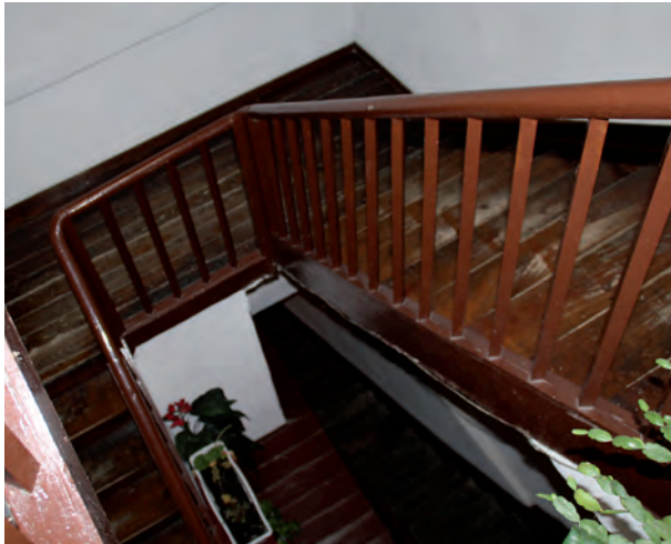
FIGURA A10. 35. CAJA DE ESCALERA
