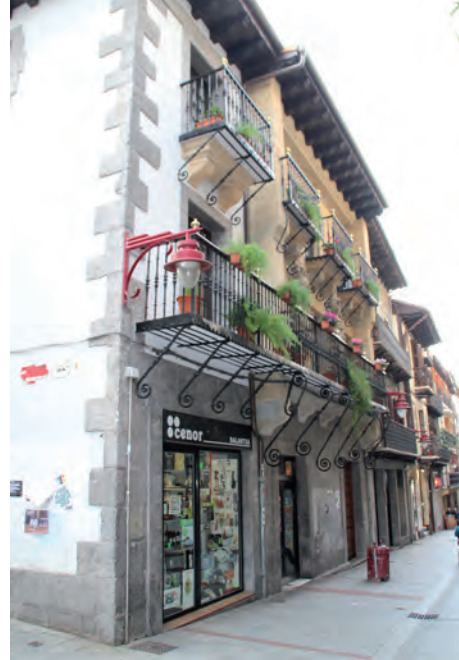
FIGURA A5. 5. FOTOGRAFÍA FACHADA A KALE NAGUSIA
