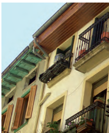
FIGURA A16. 21. CANALÓN Y BAJANTES DE FACHADA PRINCIPAL
