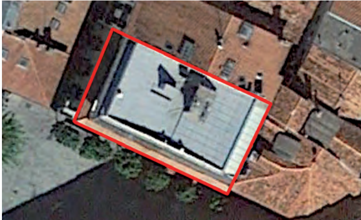
FIGURA A1. 17. CUBIERTA DE C/ MAYOR Nº 2. FOTO AÉREA 10
