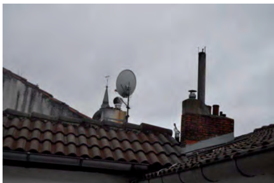
FIGURA A3. 50. VISTA PARCIAL DE LA CUBIERTA DE TEJA DE HORMIGÓN 13
