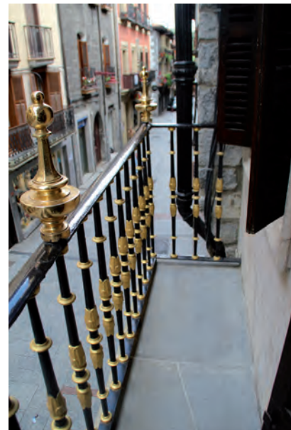
FIGURA A4. 33. PARTE SUPERIOR DE BALCONES
