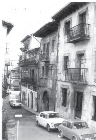
FIGURA A6. 16. 1973. FOTOGRAFÍA DE LA FACHADA TRASERA
