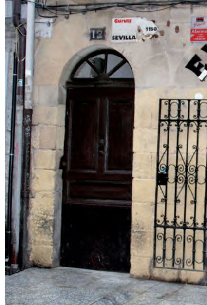
FIGURA A15. 35. PUERTA DE ACCESO
