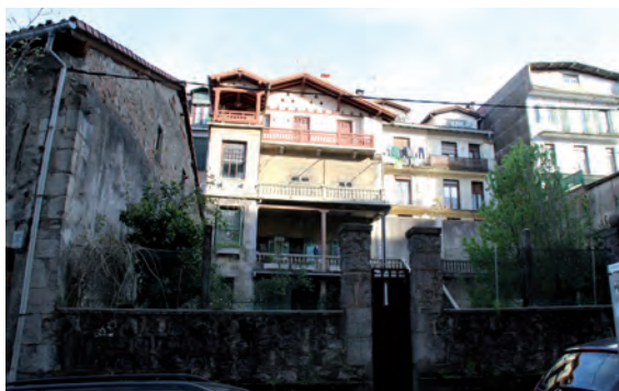
FIGURA A12. 28. MURO EXTERIOR Y FACHADA TRASERA
