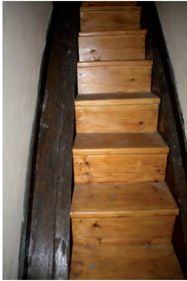
FIGURA A1. 41. ESCALERAS DE ACCESO A CUBIERTA
