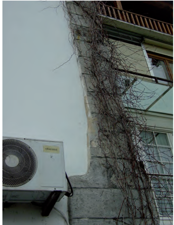
FIGURA A18. 24. FRENTE DE MURO MEDIANERO
