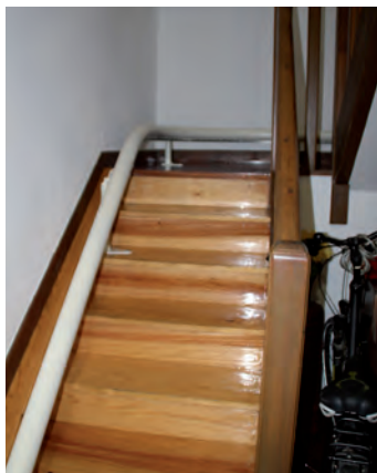
FIGURA A8. 23. ACCESO A MESETA DE ESCALERA
