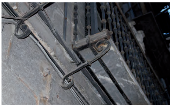
FIGURA A12. 30. BALCÓN EN FACHADA PRINCIPAL
