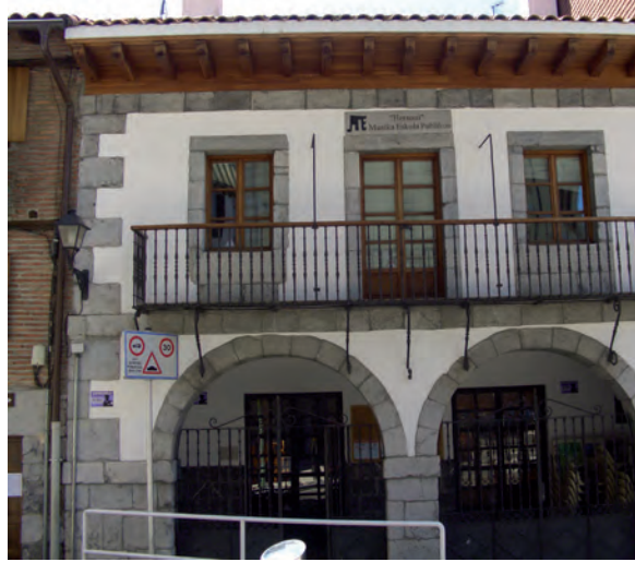
FIGURA A18. 4. FACHADA PRINCIPAL
