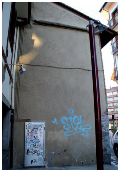
FIGURA A19. 33. FACHADA LATERAL
