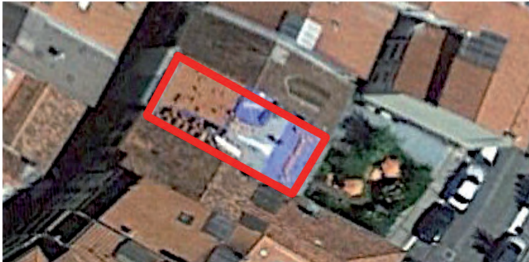
FIGURA A14. 12. CUBIERTA DE ANDRE KALE Nº 10. FOTO AÉREA 4
