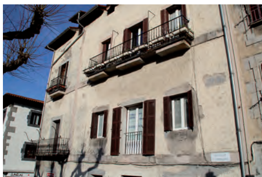
FIGURA A3. 24. FOTOGRAFÍA FACHADA TRASERA
