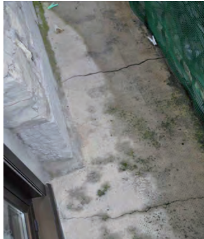
FIGURA A9. 50. BALCON 3º DERECHA DE FACHADA PRINCIPAL
