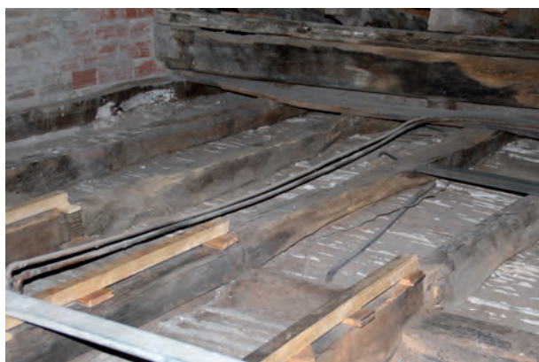
FIGURA A15. 20.FORJADO EN PLANTA BAJOCUBIERTA
