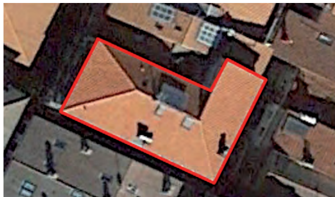
FIGURA A9. 19. CUBIERTA DE C/ MAYOR N° 32. FOTO AÉREA 4
