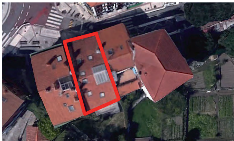
FIGURA A18. 14. CUBIERTA DE C/ ATZIETA Nº 4. FOTO AÉREA 5
