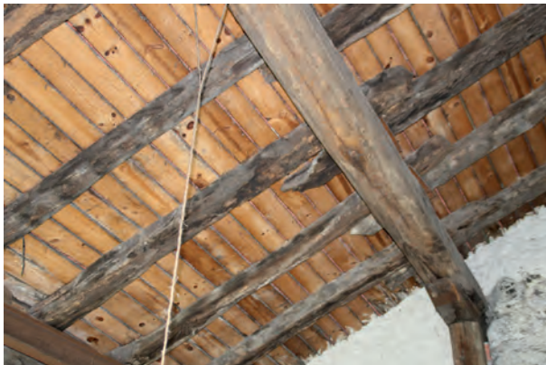
FIGURA A6. 41. ESTRUCTURA DE CUBIERTA
