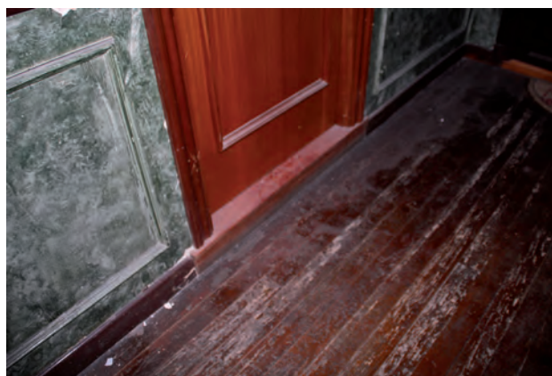
FIGURA A13. 54. ESCALÓN DE ACCESO A VIVIENDA
