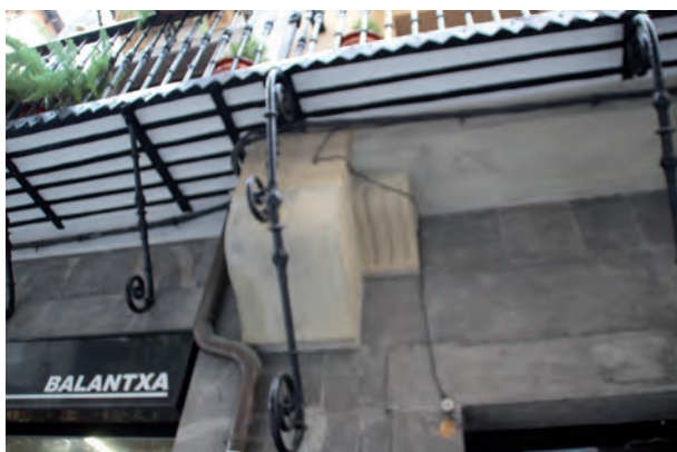
FIGURA A5. 30. MEDIANERA EN FACHADA PRINCIPAL
