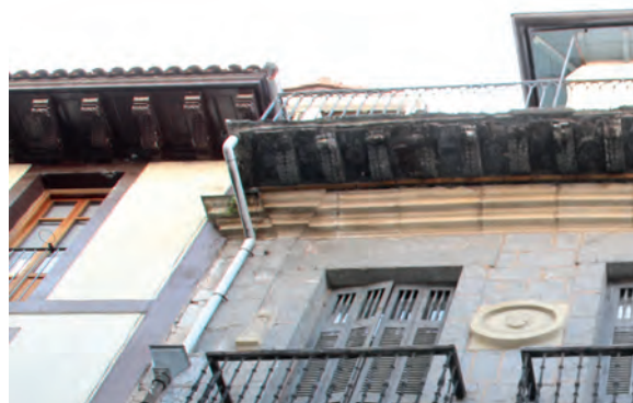
FIGURA A12. 35. BAJANTES EN FACHADA PRINCIPAL
