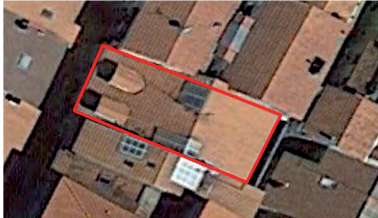
FIGURA A10. 12. CUBIERTA DE C/ MAYOR Nº 38. FOTO AÉREA 5
