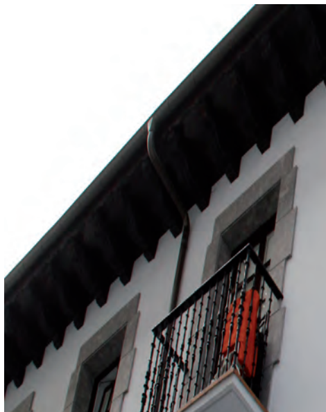
FIGURA A5. 43. BAJANTES POR FACHADA
