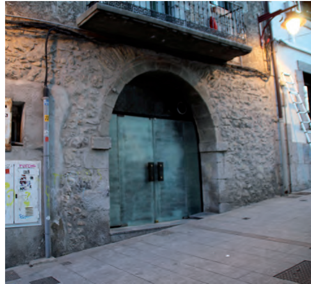
FIGURA A6. 36. PLANTA BAJA FACHADA TRASERA
