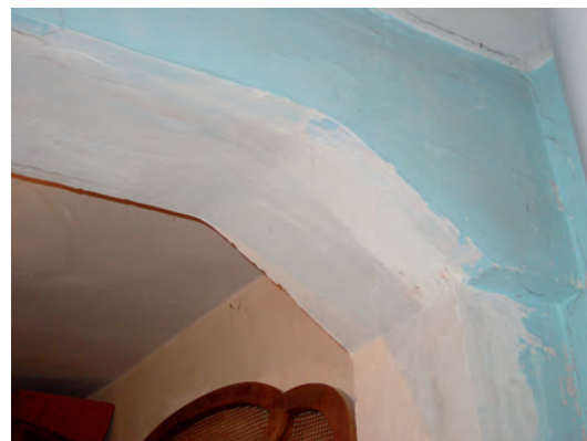
FIGURA A3. 19. FOTOGRAFÍA DE ENCUENTRO DE VIGA CON PILAR
