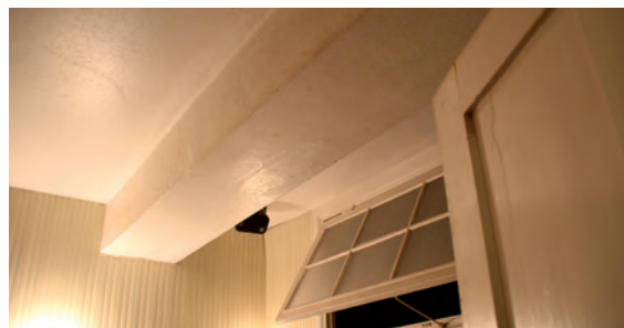
FIGURA A12. 23. VIGA CUBIERTA EN PLANTA BAJA
