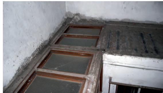
FIGURA A8. 22. PATIO CUBIERTO
