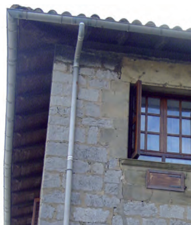
FIGURA A17. 52. CANALONES Y BAJANTES EN FACHADA PRINCIPAL
