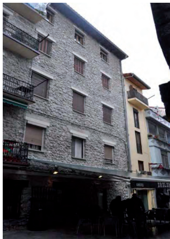
FIGURA A9. 9. FACHADA TRASERA A CÁRCAVA
