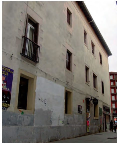
FIGURA A3. 8. FACHADA LATERAL
