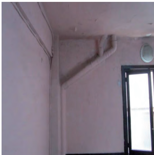
FIGURA A13. 57. BAJANTES POR CAJA DE ESCALERAS
