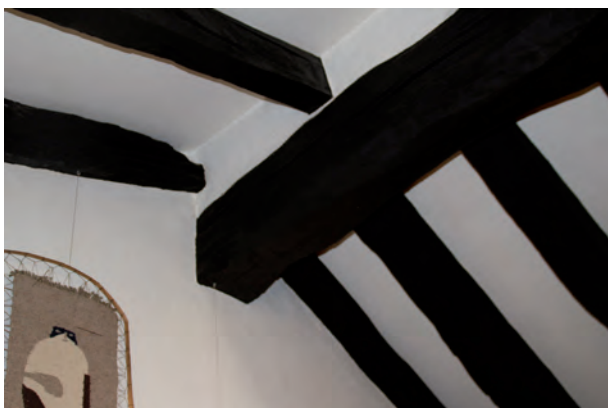
FIGURA A4. 25. UNA DE LAS CUMBRERAS DE CUBIERTA
