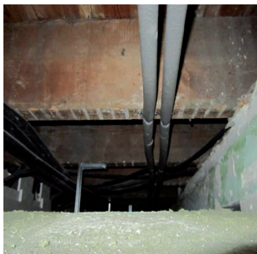
FIGURA A13. 44. SOLIVERÍA DE MADERA DE 2ª PLANTA
