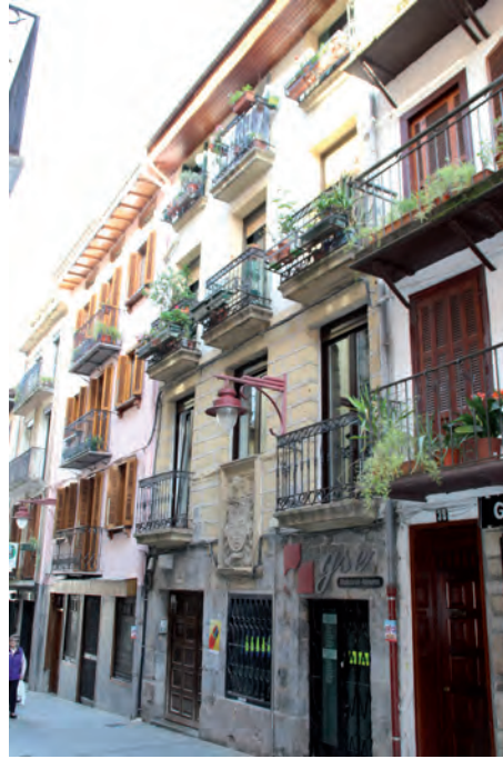
FIGURA A16. 4. FACHADA PRINCIPAL
