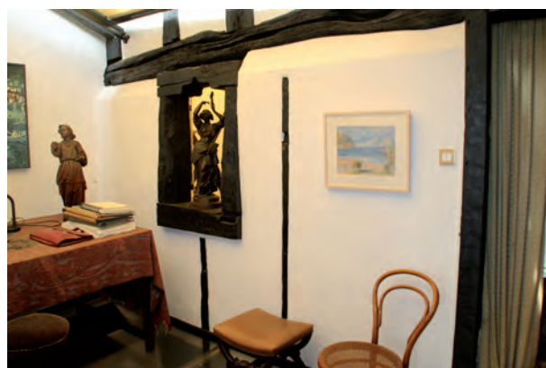
FIGURA A4. 20. ENTRAMADOS EN MUROS SEPARADORES
