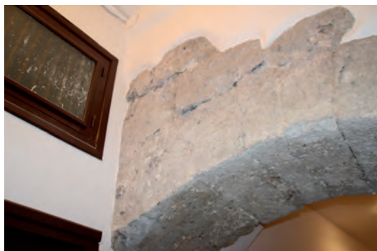
FIGURA A2. 30. ARCO EN MURO DE PLANTA BAJA
