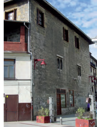
FIGURA A17. 8. FACHADA LATERAL
