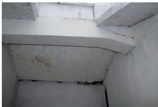
FIGURA A15. 21.ESTRUCTURA EN CUBIERTA
