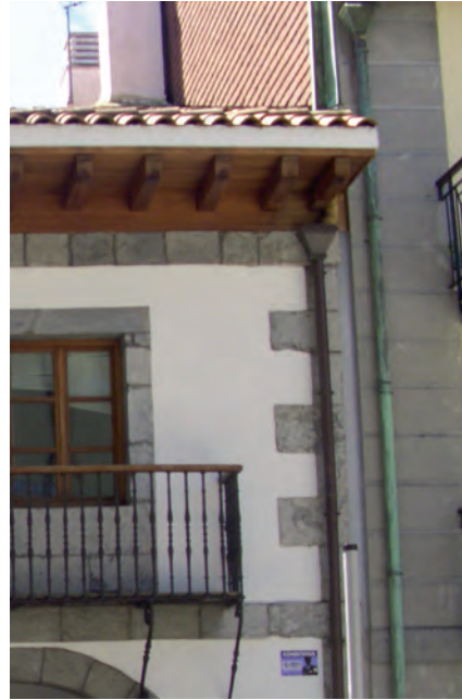
FIGURA A18. 41. BAJANTE FACHADA PRINCIPAL
