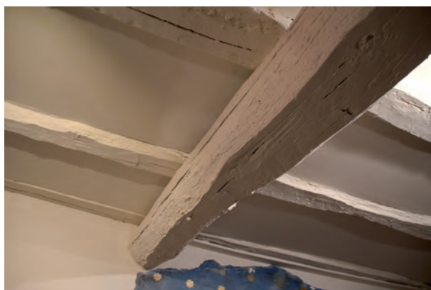
FIGURA A19. 30. ESTRUCTURA EN VIVIENDA EN PLANTA BAJA
