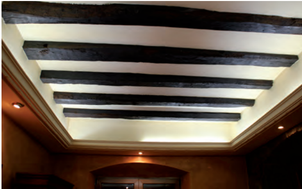
FIGURA A9. 47. VIGUETAS VISTAS EN VIVIENDA
