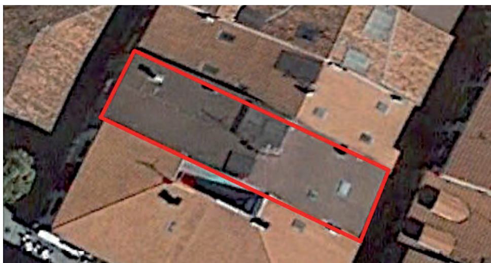
FIGURA A6. 13. CUBIERTA DE C/ MAYOR N° 19. FOTO AÉREA 5
