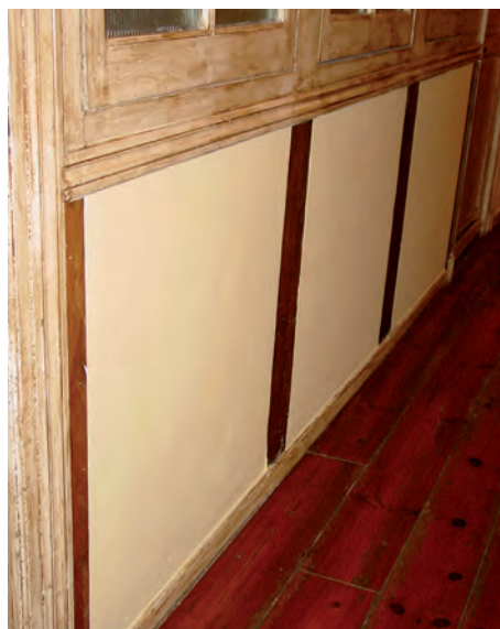
FIGURA A20. 31. ENTRAMADO DE MADERA EN CIERRE DE PATIO
