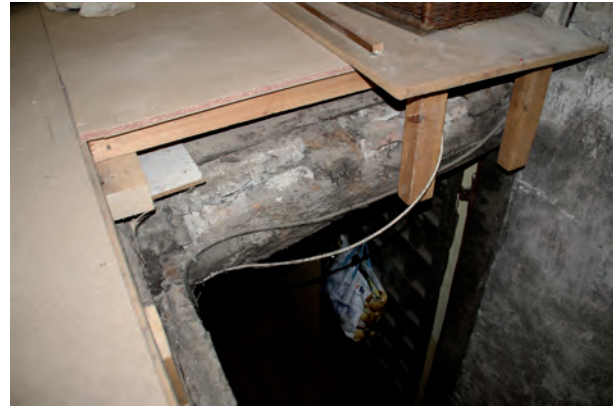
FIGURA A6. 34. FORJADO DE PLANTA BAJOCUBIERTA EN PROCESO DE REHABILITACIÓN
