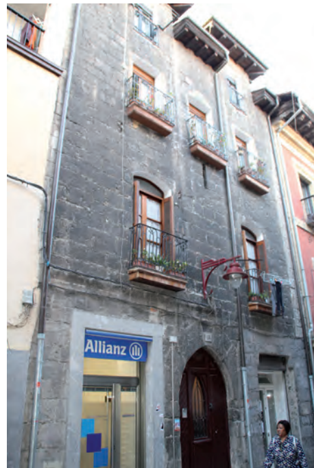
FIGURA A2. 6. FACHADA PRINCIPAL
