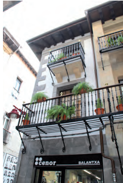
FIGURA A5. 33. FACHADA PRINCIPAL
