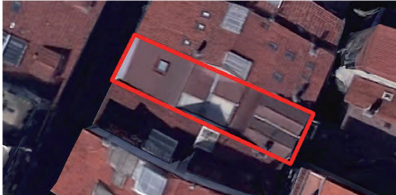
FIGURA A4. 14. CUBIERTA DE C/ MAYOR Nº 16. FOTO AÉREA 6
