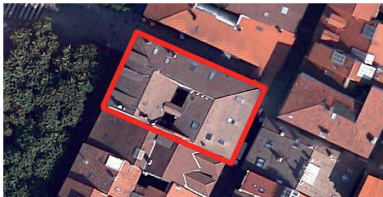
FIGURA A3. 27. CUBIERTA DE C/ MAYOR Nº 15. FOTO AÉREA 5
