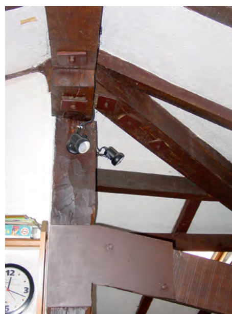
FIGURA A17. 44. REFUERZO DE ESTRUCTUA EN CUBIERTA
