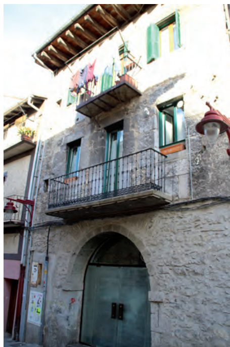
FIGURA A6. 6. FACHADA TRASERA A CALLE ITURRIAGA
