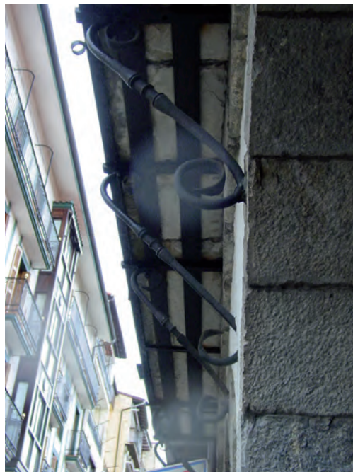
FIGURA A18. 27. ESTRUCTURA DE BALCÓN
