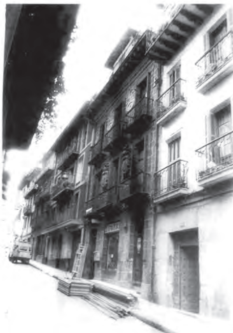
FIGURA A12. 19. 1982 FOTOGRAFIA DE FACHADA PRINCIPAL
