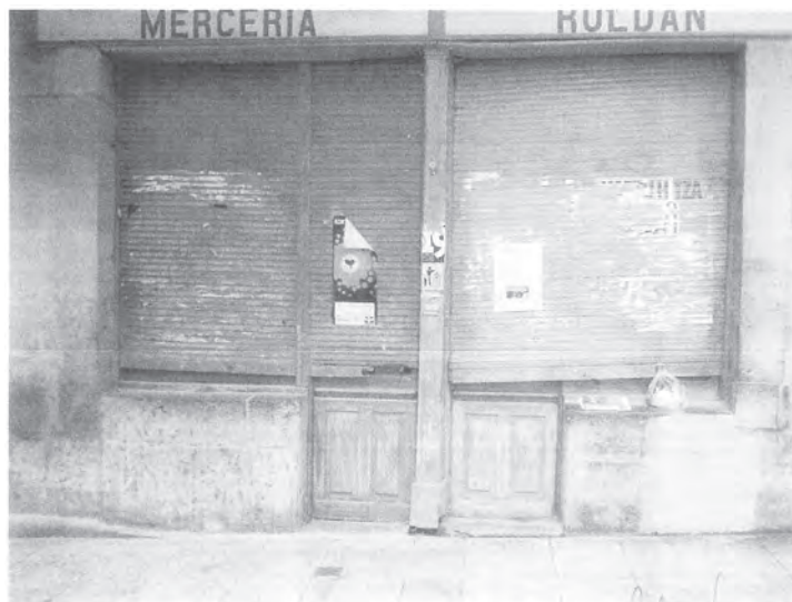
FIGURA A9. 39. 2004. FOTOGRAFÍA DE LA PLANTA BAJA DE LA FACHADA PRINCIPAL A CALLE MAYOR 43
