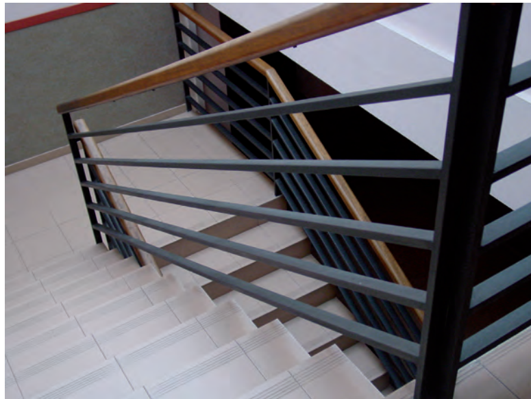
FIGURA A18. 25. ESCALERAS
