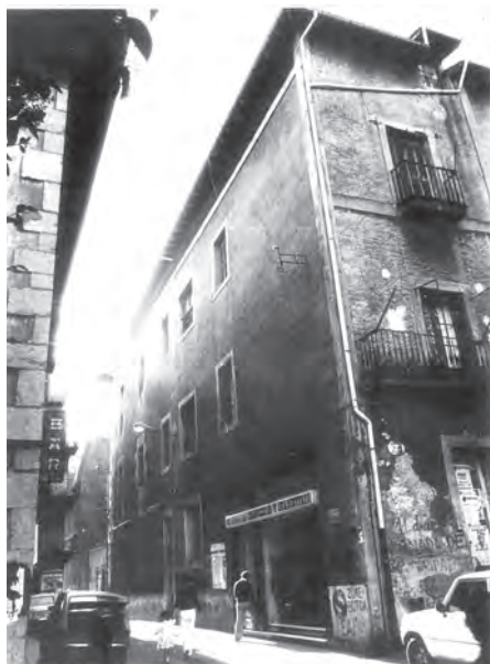
FIGURA A3. 36. FOTOGRAFÍA DE LA FACHADA EN 1982 24
