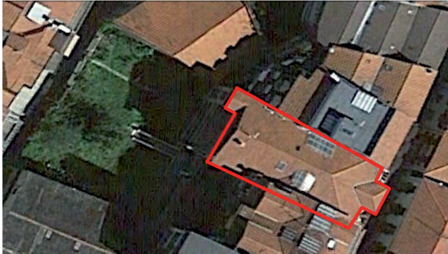
FIGURA A12. 18. CUBIERTA DE C/ MAYOR Nº 45. FOTO AÉREA 5
