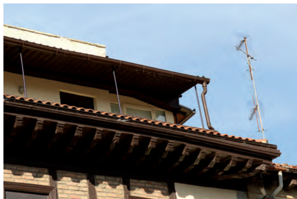
FIGURA A1. 50. PARTE DE CUBIERTA HACIA PLAZA
