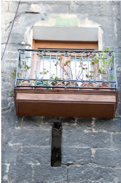
FIGURA A2. 3. TRONERA EN FACHADA PRINCIPAL
