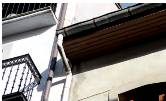
FIGURA A15. 29. FACHADA PRINCIPAL
