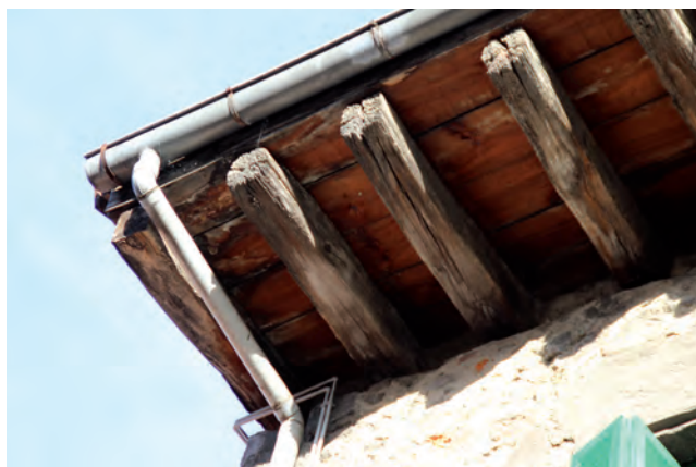
FIGURA A6. 43. ALERO DE MADERA Y BAJANTES
