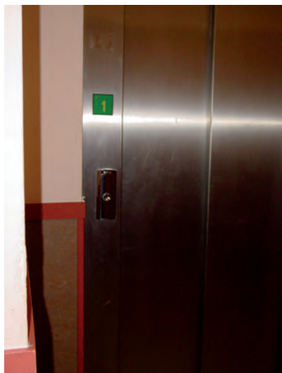
FIGURA A18. 36. ASCENSOR
