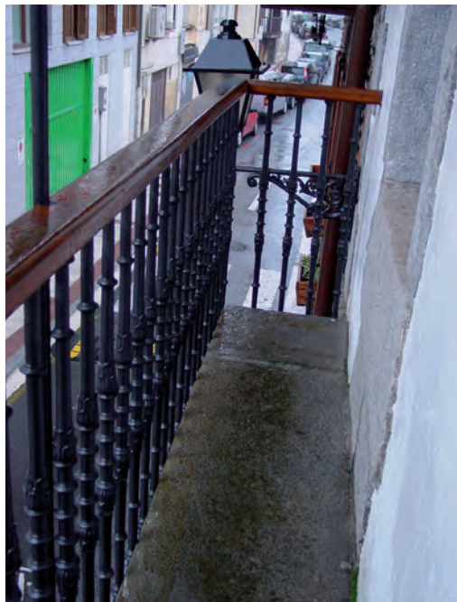
FIGURA A18. 26. Balcón corrido en fachada principal
