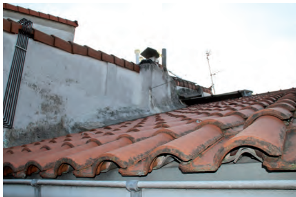
FIGURA A10. 29. CUBIERTA DE TEJAS DE HORMIGÓN
