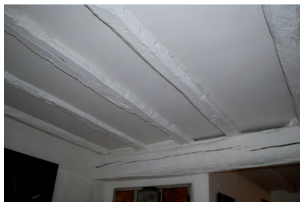
FIGURA A19. 31. ESTRUCTURA EN VIVIENDA EN PLANTA BAJA
