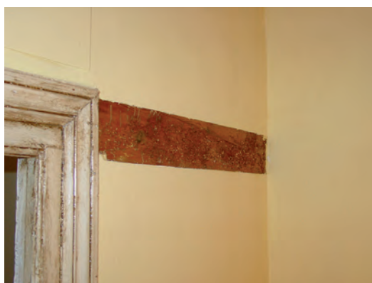
FIGURA A20. 30. ENTRAMADO DE MADERA EN CIERRE DE PATIO
