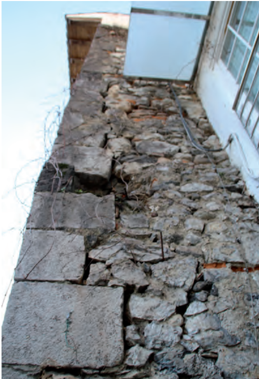
FIGURA A18. 23. ESQUINA DE MURO MEDIANERO
