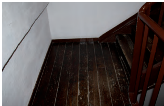
FIGURA A10. 22. RELLANO DE ESCALERA
