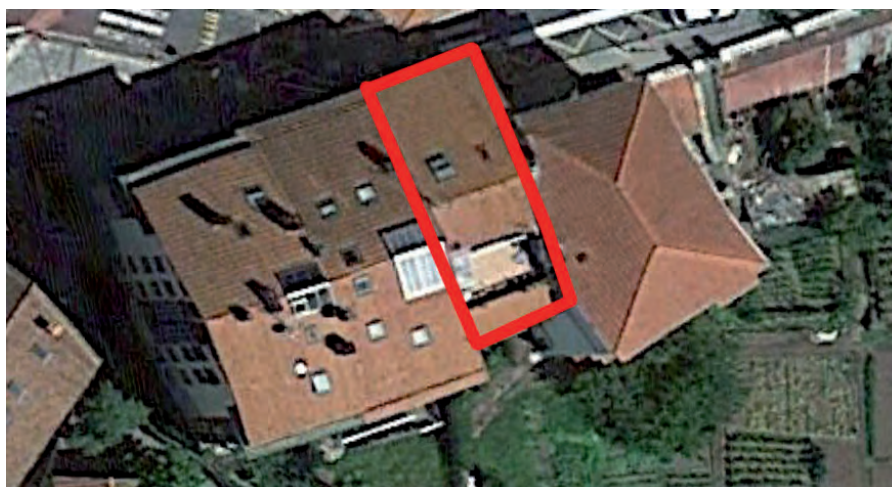
FIGURA A19. 15. CUBIERTA DE C/ ATZIETA Nº 6. FOTO AÉREA 7
