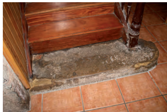
FIGURA A2. 31. PRIMER PELDAÑO DE PIEDRA EN PLANTA BAJA
