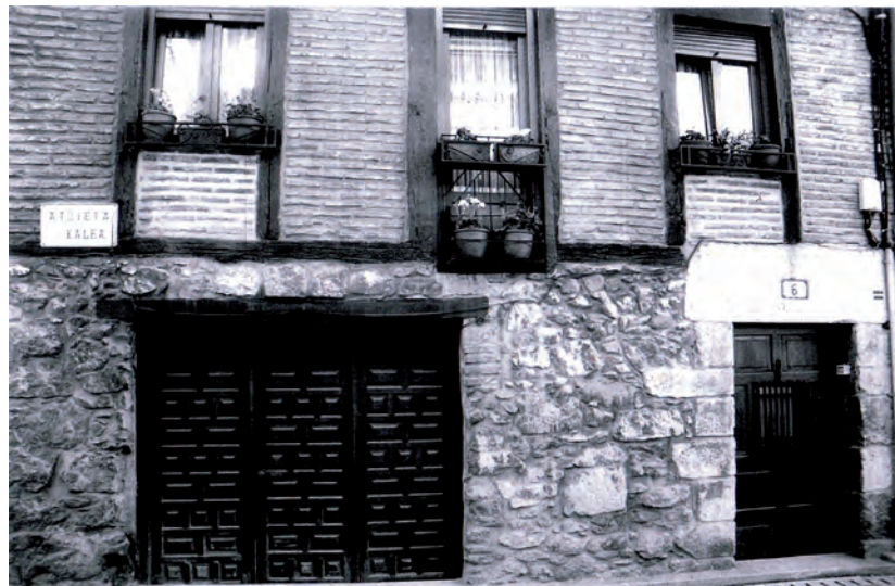
FIGURA A19. 23. 2002 FOTOGRAFÍA DE PUERTA A SUSTITUIR EN LA PLANTA BAJA
