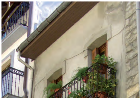
FIGURA A15. 36. FACHADA PRINCIPAL
