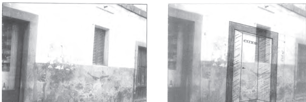
FIGURA A1. 29. FOTOGRAFÍAS DE PROPUESTA DE UBICACIÓN DE APERTURA DE HUECO EN FACHADA HACIA PLAZA 26
