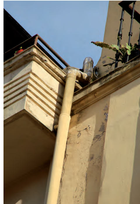
FIGURA A20. 40. DESCONCHAMIENTOS EN PINTURA
