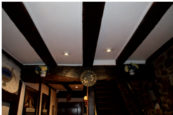
FIGURA A19. 26. TECHO DE PORTAL
