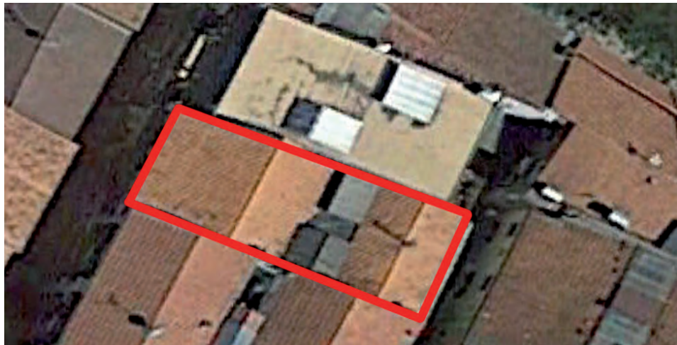
FIGURA A11. 16. CUBIERTA DE C/ MAYOR N° 42. FOTO AÉREA 2
