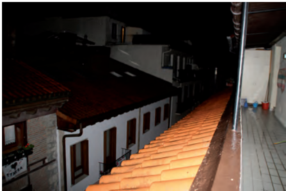
FIGURA A1. 51. CUBIERTA DE TEJA
