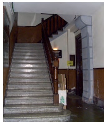
FIGURA A12. 25. ESCALERAS
