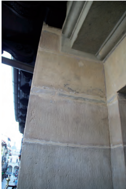
FIGURA A5. 32. FACHADA PRINCIPAL
