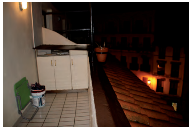
FIGURA A1. 48. TERRAZA DE LA PLANTA BAJOCUBIERTA
