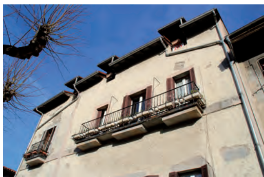
FIGURA A3. 23. FOTOGRAFÍA FACHADA TRASERA
