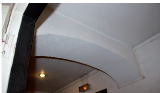
FIGURA A12. 22. ARCO EN MURO DE CARGA EN PLANTA BAJA
