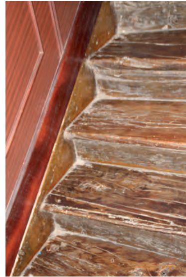
FIGURA A1. 42. PELDAÑOS DE ESCALERAS EN 2ª PLANTA
