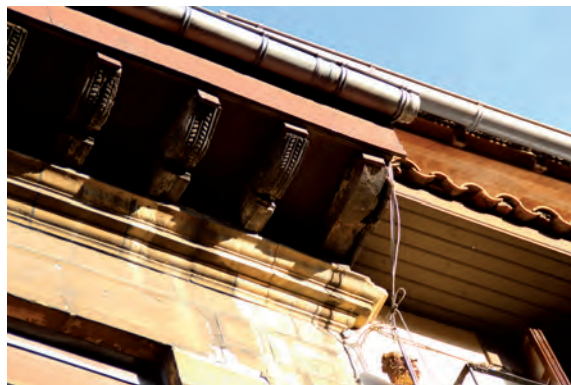
FIGURA A10. 30. ALERO EN FACHADA PRINCIPAL
