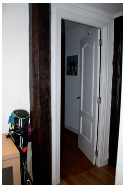
FIGURA A1. 39. PILARES DE MADERA EN 3º PLANTA
