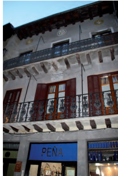
FIGURA A6. 40. FACHADA PRINCIPAL
