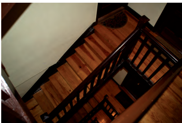
FIGURA A9. 55. ESCALERAS
