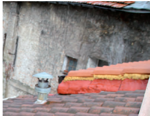
FIGURA A14. 23. CUBIERTA REHABILITADA
