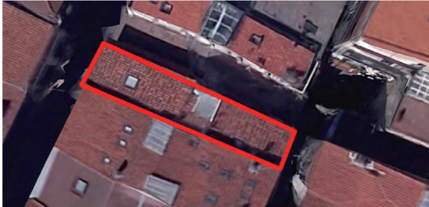
FIGURA A7. 12. CUBIERTA DE C/ MAYOR N° 20. FOTO AÉREA 4
