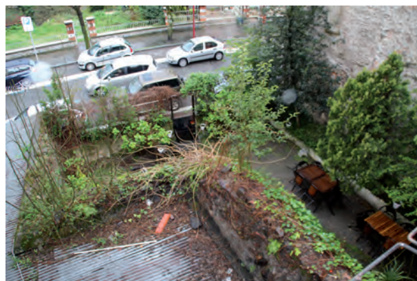
FIGURA A15. 4. MURO MEDIANERO
