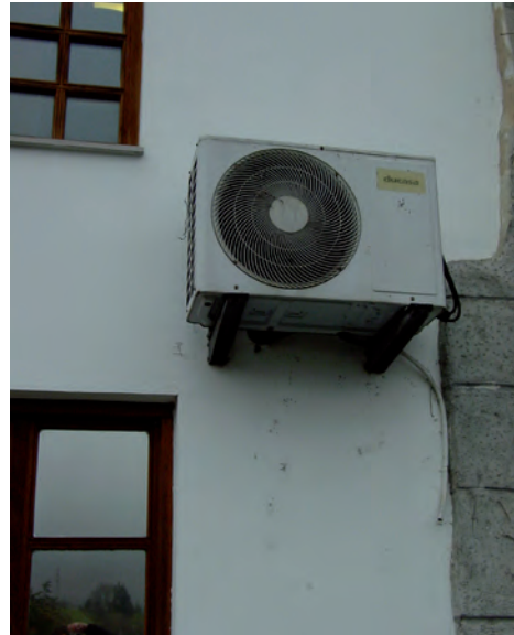
FIGURA A18. 31. INSTALACIONES EN FACHADA TRASERA
