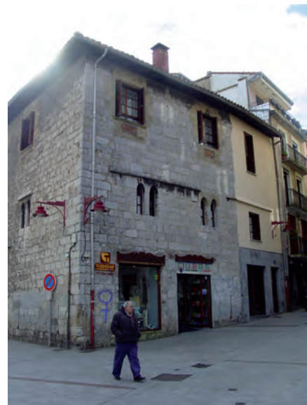
FIGURA A17. 10. FACHADA PRINCIPAL
