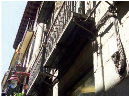
FIGURA A12. 37. INSTALACIONES ELECTRICAS POR FACHADA
