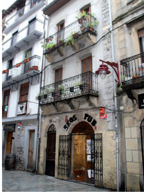
FIGURA A15. 6. FACHADA PRINCIPAL
