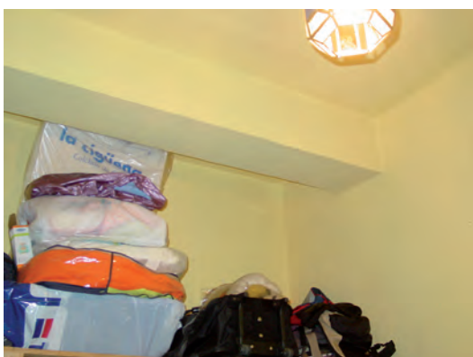
FIGURA A20. 29. VIGA REVESTIDA
