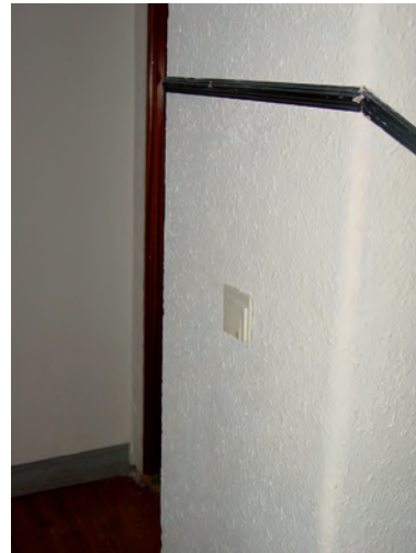
FIGURA A3. 17. FOTOGRAFÍA DE MURO DE CARGA DE ESCALERA
