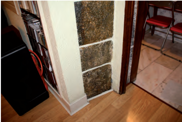
FIGURA A6. 29. MURO PARALELO A FACHADA TRASERA
