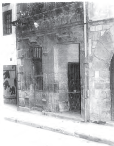
FIGURA A7. 13. 1970 FOTOGRAFÍA DE LA FACHADA DE LA PLANTA BAJA
