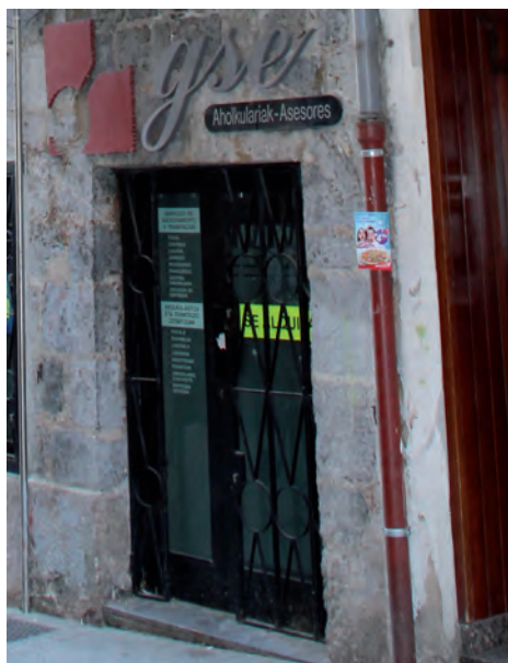
FIGURA A16. 20. PUERTA DE ACCESO A LOCAL
