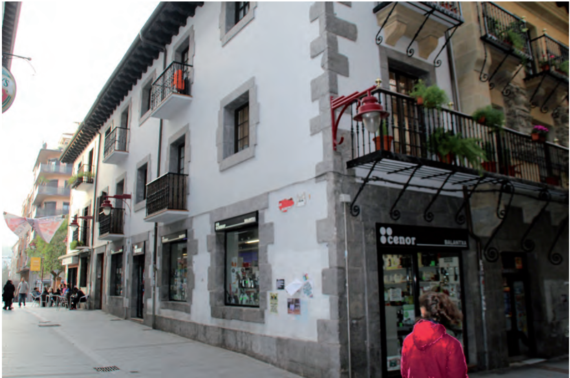
FIGURA A5. 9 FACHADA LATERAL
