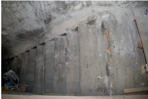
FIGURA A6. 33. ESCALERAS DE ACCESO A LA PLANTA BAJOCUBIERTA
