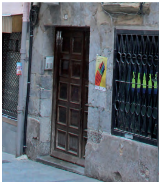
FIGURA A16. 19. PUERTA DE ACCESO A PORTAL
