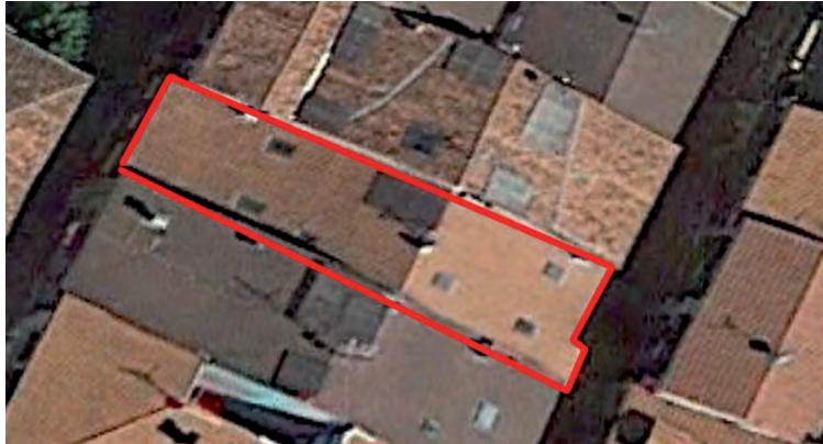
FIGURA A8. 13. CUBIERTA DE C/ MAYOR Nº 21. FOTO AÉREA 5
