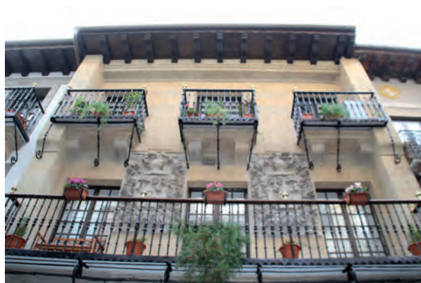
FIGURA A5. 31. FACHADA PRINCIPAL
