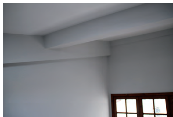
FIGURA A5. 29. ESTRUCTURA DE CUBIERTA
