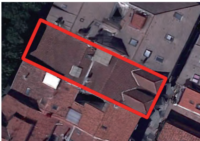
FIGURA A2. 15. CUBIERTA DE C/ MAYOR Nº 13. FOTO AÉREA 7
