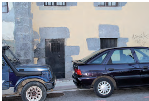
FIGURA A20. 36. ACCESOS DESDE FACHADA TRASERA
