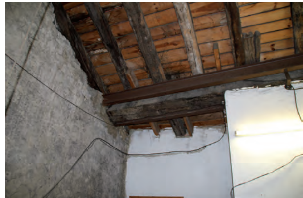
FIGURA A6. 42. ESTRUCTURA DE CUBIERTA
