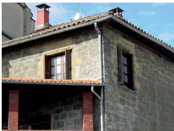
FIGURA A17. 51. CANALONES Y BAJANTES EN FACHADA TRASERA
