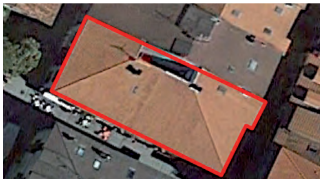
FIGURA A5. 19. CUBIERTA DE C/ MAYOR Nº 17 FOTO AÉREA 6
