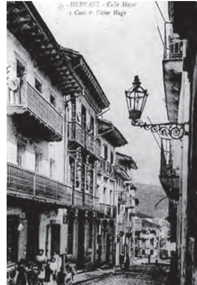
FIGURA A12. 10 FOTOGRAFÍA ANTIGUA DE FACHADA
