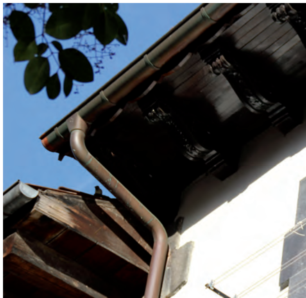
FIGURA A5. 42. BAJANTES POR FACHADA
