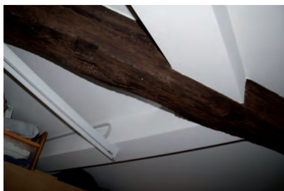
FIGURA A5. 28. ESTRUCTURA DE CUBIERTA
