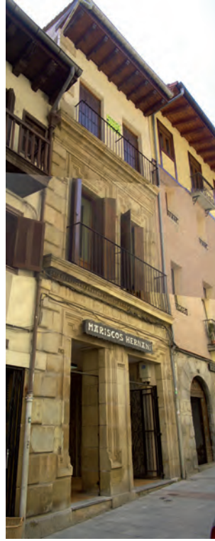
FIGURA A7. 3. FACHADA PRINCIPAL
