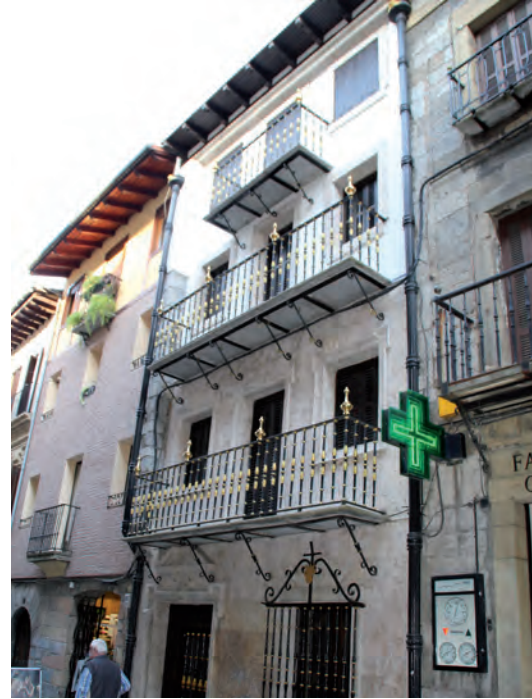
FIGURA A4. 5. FACHADA PRINCIPAL
