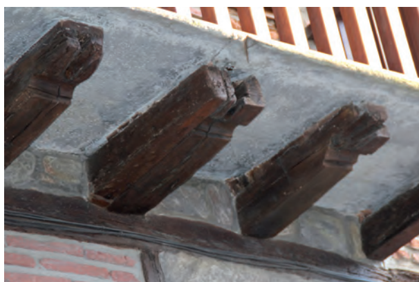
FIGURA A19. 28. ESTRUCTURA DE BALCÓN
