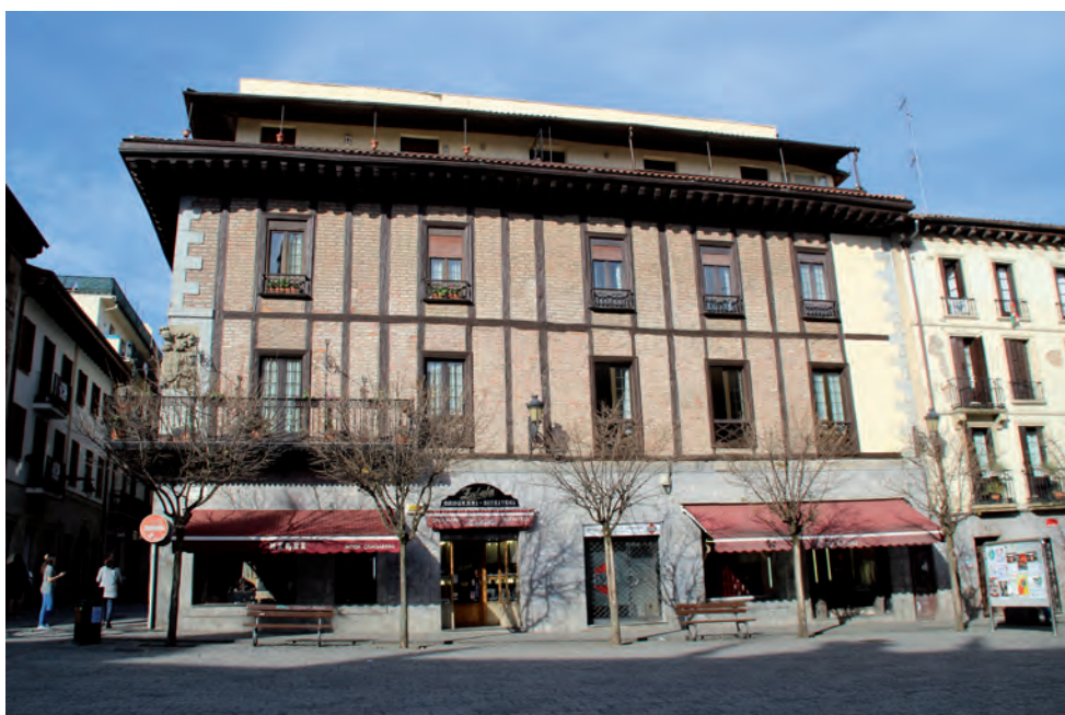
FIGURA A1. 4. FACHADA PRINCIPAL
