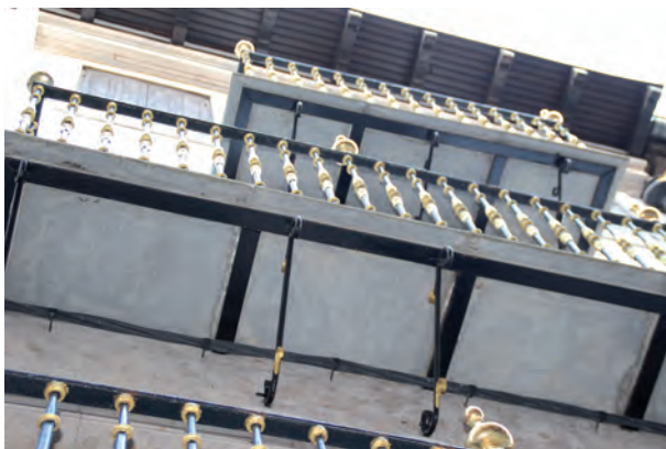
FIGURA A4. 32. PARTE INFERIOR DE BALCONES
