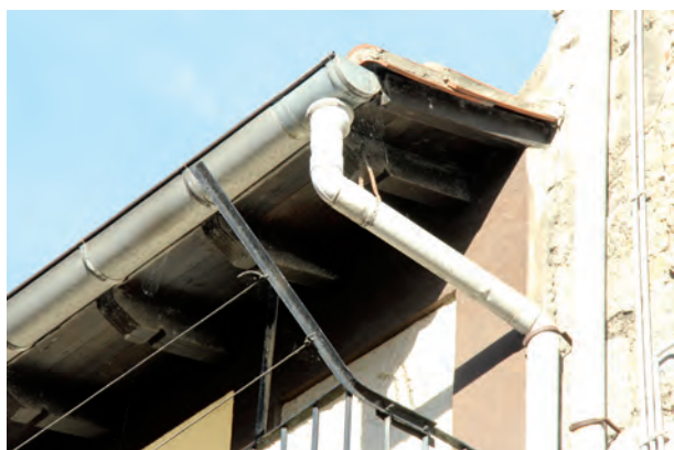
FIGURA A8. 35. CONDUCCIONES DE PLUVIALES FACHADA PRINCIPAL
