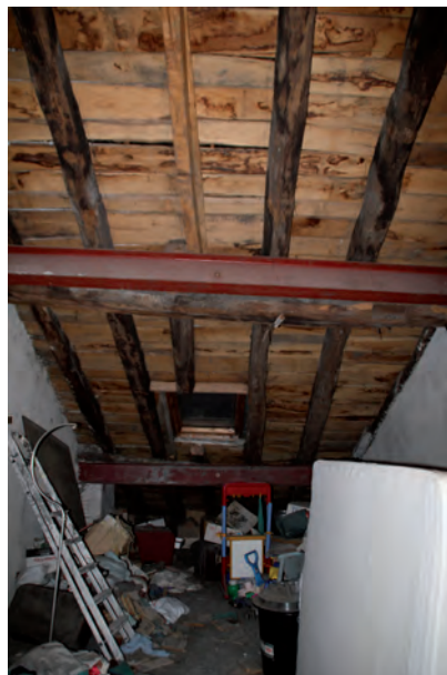
FIGURA A8. 32. REFUERZO ESTRUCTURAL
