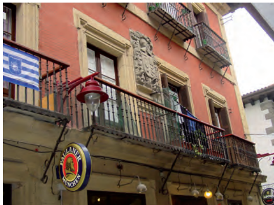
FIGURA A3. 21. FOTOGRAFÍA FACHADA PRINCIPAL
