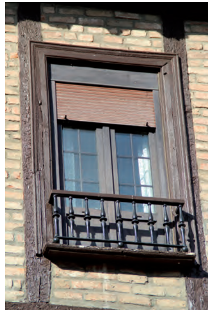
FIGURA A1. 46. HUECO HACIA PLAZA
