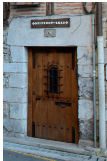
FIGURA A19. 39. PUERTA DE ACCESO
