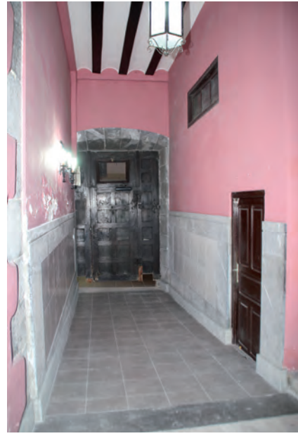
FIGURA A13. 56. RAMPA EN PORTAL
