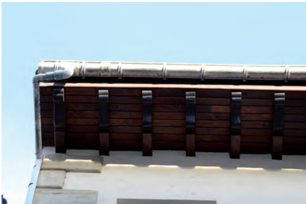
FIGURA A7. 28. CANALÓN Y BAJANTE DE PVC
