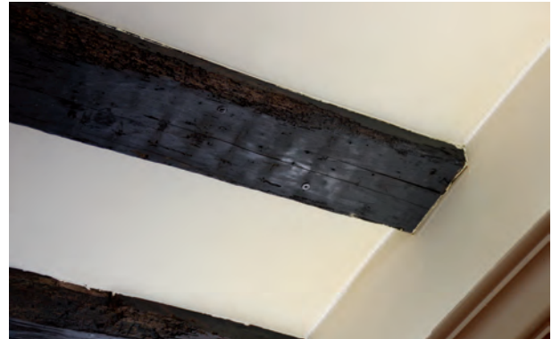
FIGURA A9. 48. ORIFICIOS EN MADERA PARA INSERCIÓN DE TRATAMIENTO ANTIXILÓFAGOS
