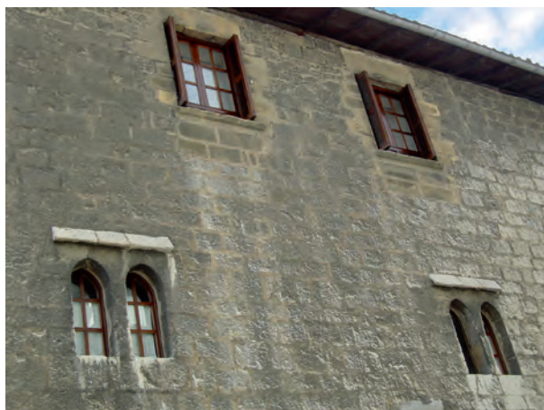
FIGURA A17. 46. FACHADA LATERAL
