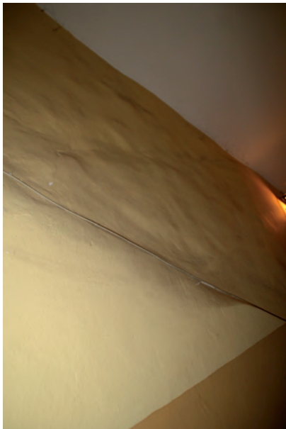
FIGURA A6. 31. MURO MEDIANERO EN ESCALERAS QUE DISMINUYE DE GROSOR EN ALTURA
