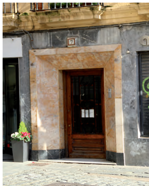
FIGURA A20. 45. PUERTA DE ACCESO
