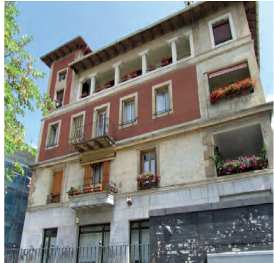
FIGURA A13. 8 FACHADA A PLAZA BERRI
