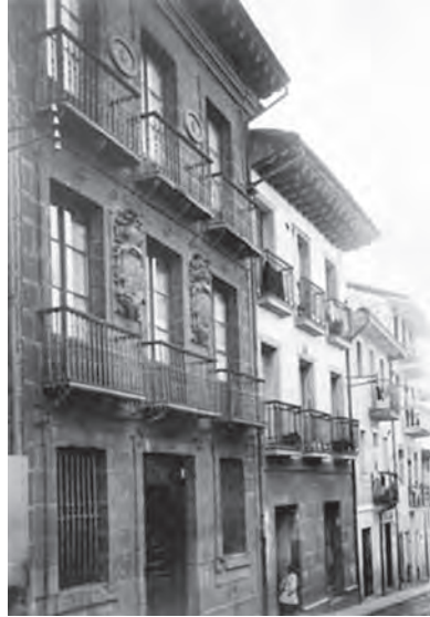
FIGURA A12. 9 FOTOGRAFÍA ANTIGUA DE FACHADA
