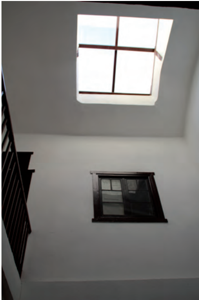
FIGURA A10. 31. LUCERNARIO EN CAJA DE ESCALERAS
