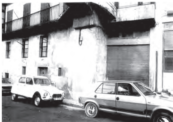
FIGURA A20. 23. 1988. FOTOGRAFÍA DE FACHADA TRASERA
