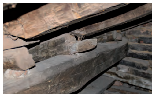
FIGURA A15. 33. ESTRUCTURA DE CUBIERTA
