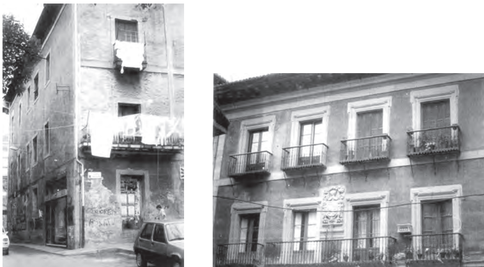
FIGURA A3. 40. FOTOGRAFÍAS DE LA FACHADA PRINCIPAL, LATERAL Y TRASERA 35
