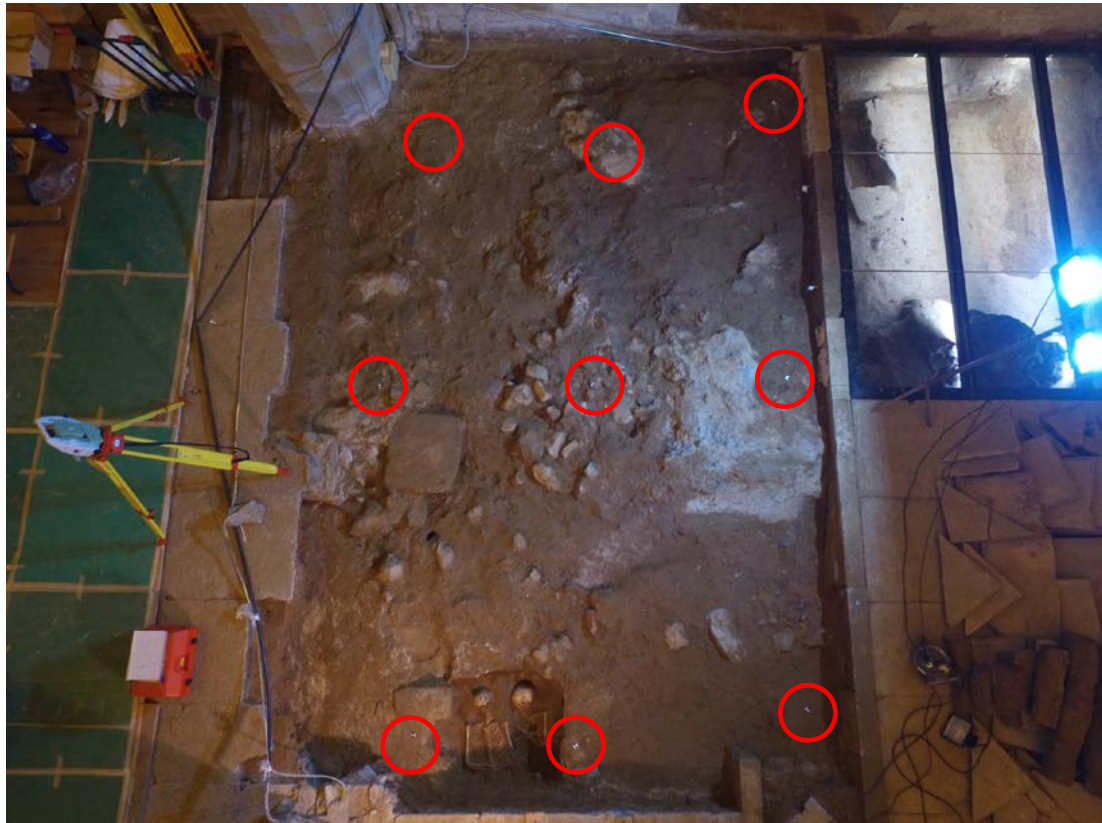
Fig. 8.- Situación del equipo topográfico y de las dianas utilizadas para el apoyo durante la documentación de las excavaciones.
